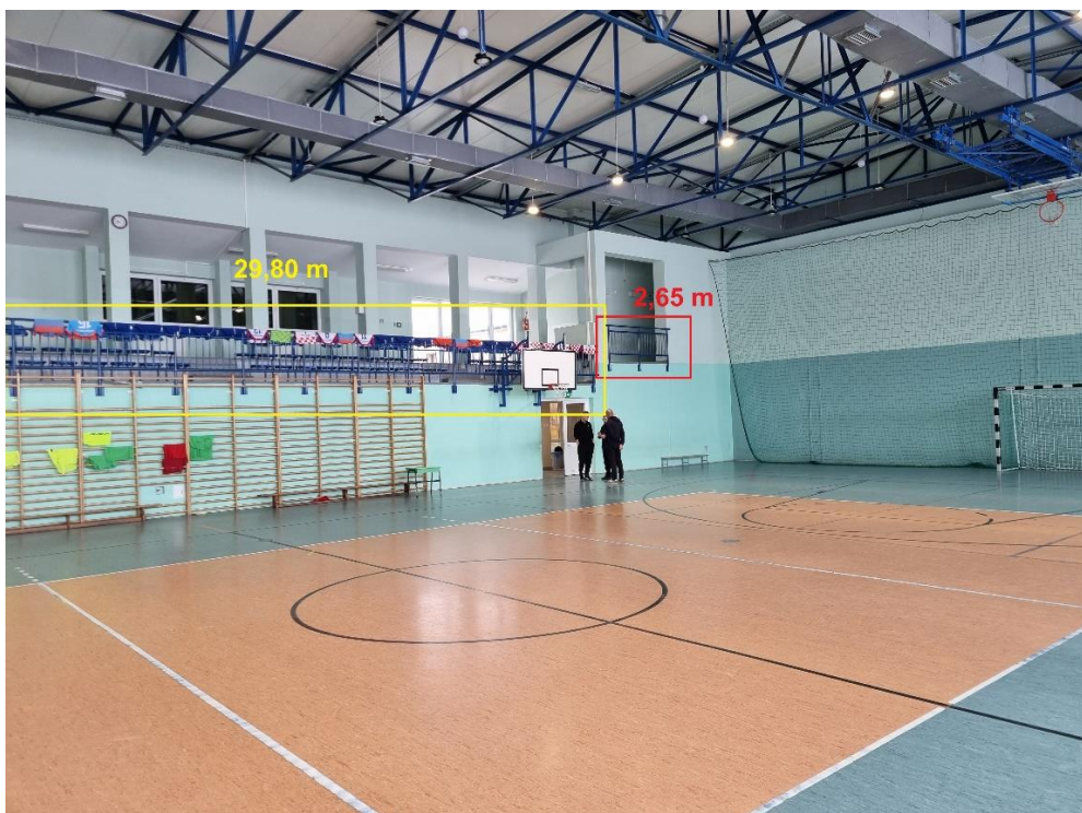
Zdj. 1. Widok balustrad przewidzianych do wymiany w Szkole w Branicach.
