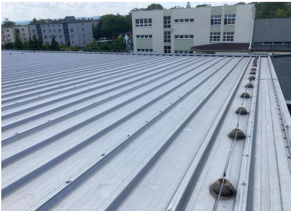
Zdj. 2. Widok pokrycia dachowego w hali sportowej przy Szkole w Branicach.
