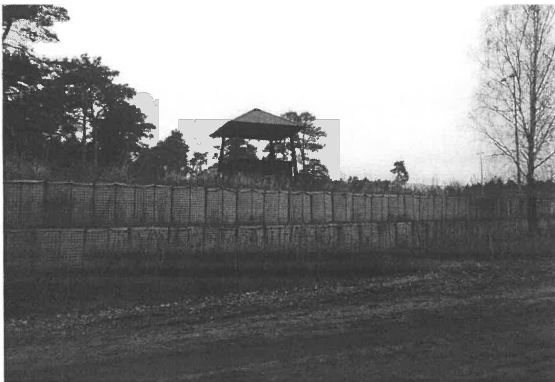
Fortyfikacje typu hesco bastion od strony pld.
