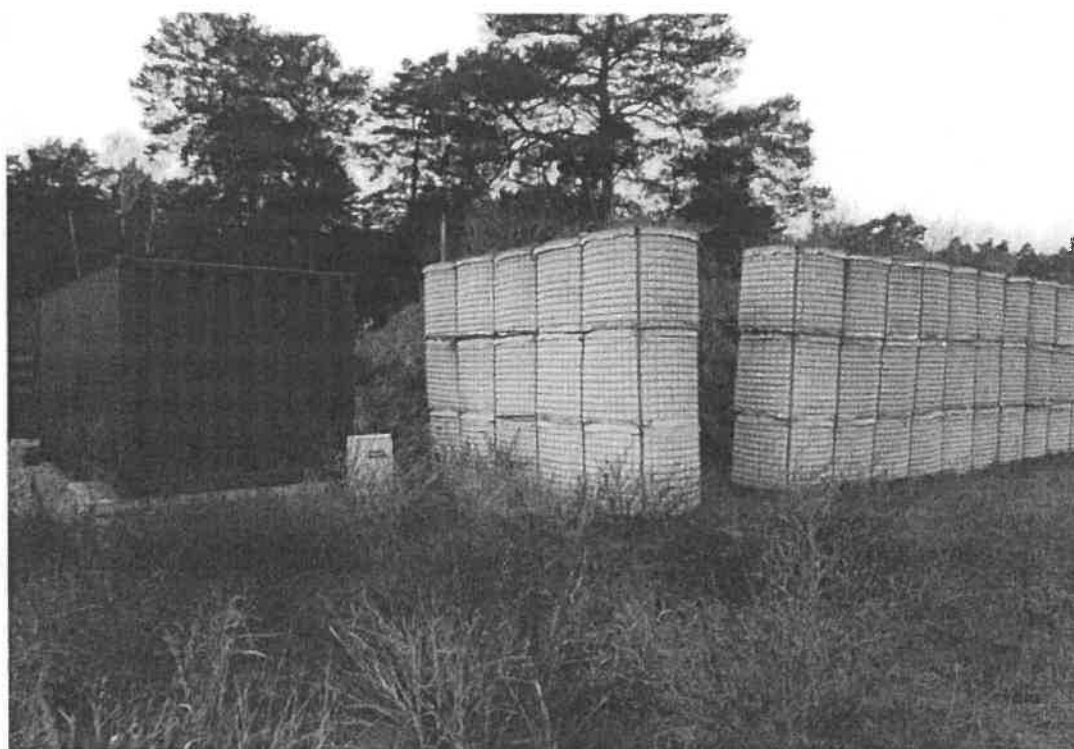
Schron ziemny z fortyfikacjami typu hesco bastion
