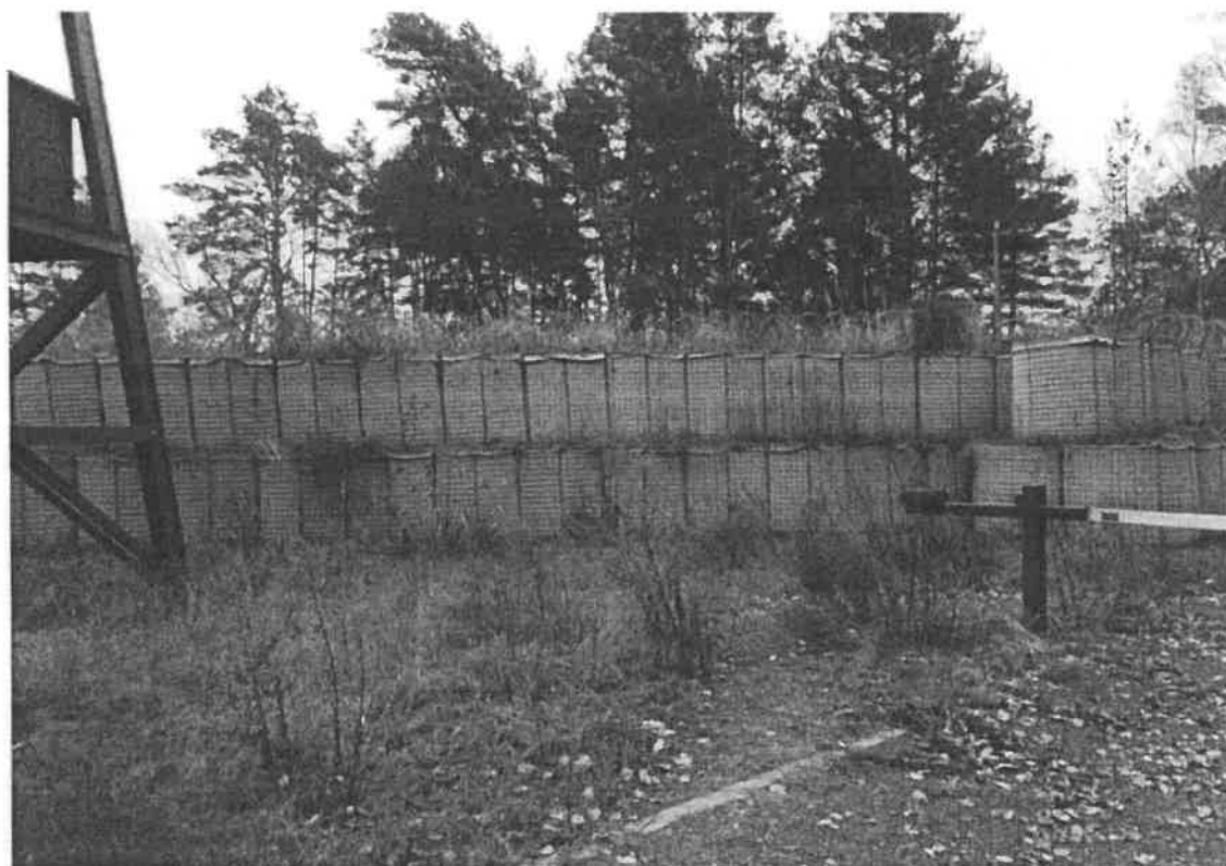
Fortyfikacje typu hesco bastion-od strony pld. Przy bramie wjazdowej
