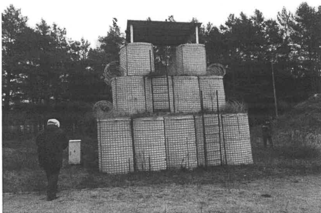
Wieża z fortifikacji typu hesco bastion
