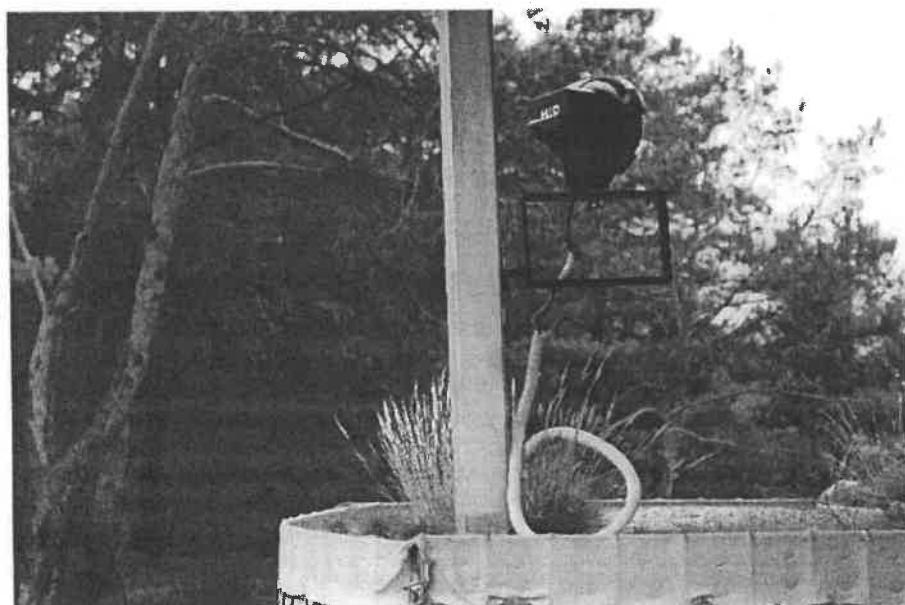
Nieprawidłowo wykonana izolacja przewodu –połączenie oprawy
