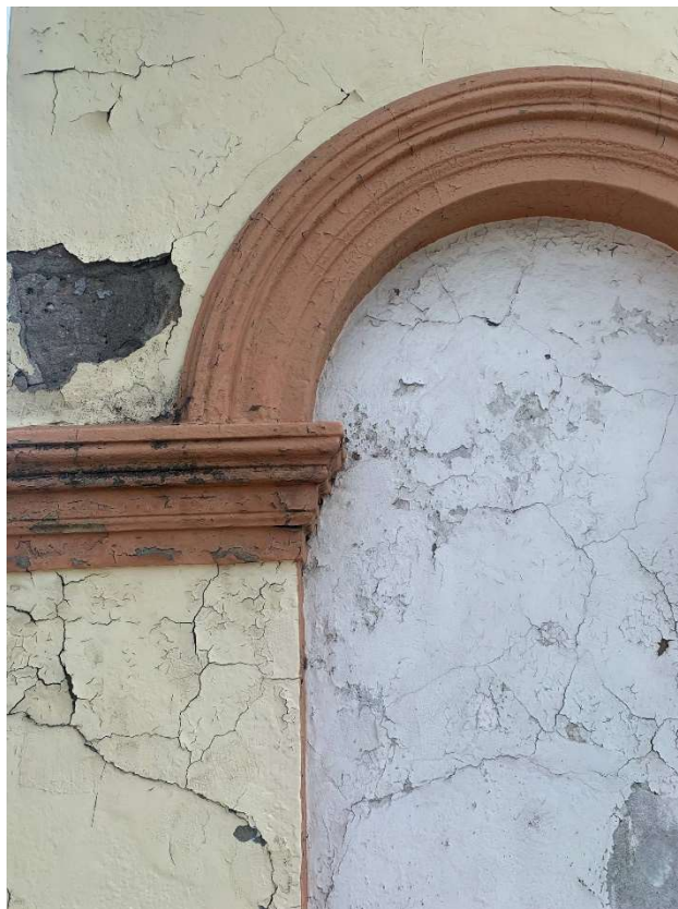
Zdj. nr 10 – Pęknięcia i ubytki lica muru
