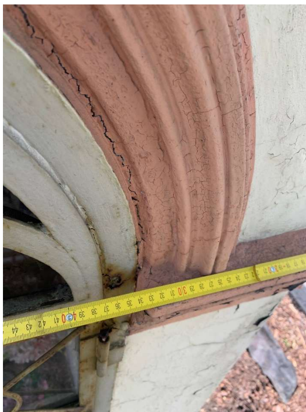
Zdj. nr 7 – Odspojenie gzymsu okiennego
