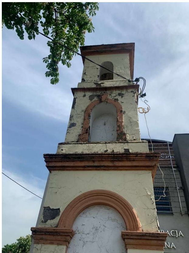
Zdj. nr 9 – Liczne odparzenia tynku i warstw malarskich
