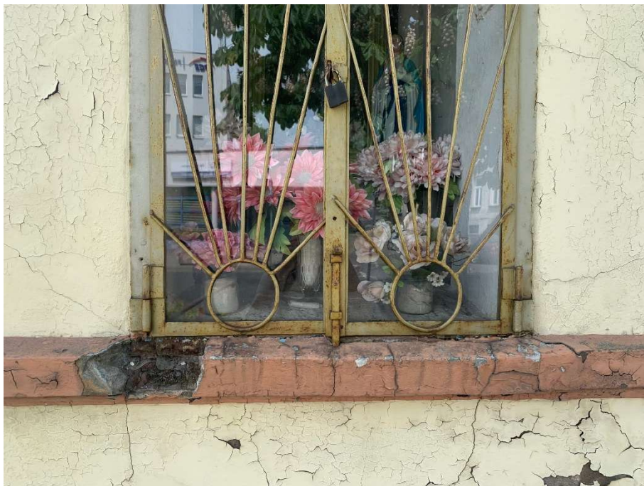
Zdj. nr 4 – Ubytki i pęknięcia gzymsu podokiennego
