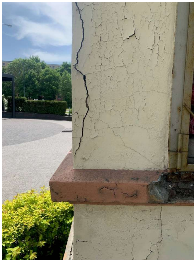
Zdj. nr 8 – Pęknięcie i odspojenie lica muru
