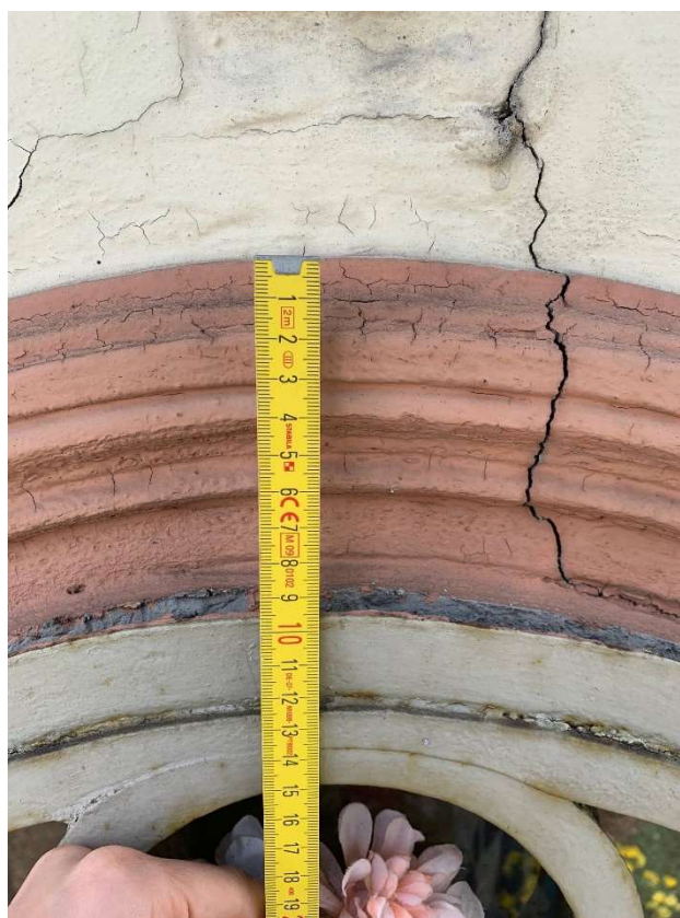
Zdj. nr 5 – Pęknięcie gzymsu i nadproża okiennego
