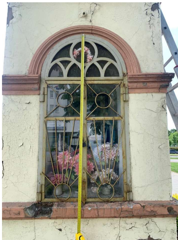
Zdj. nr 13 – Widok elewacji z widocznymi zabrudzeniami
