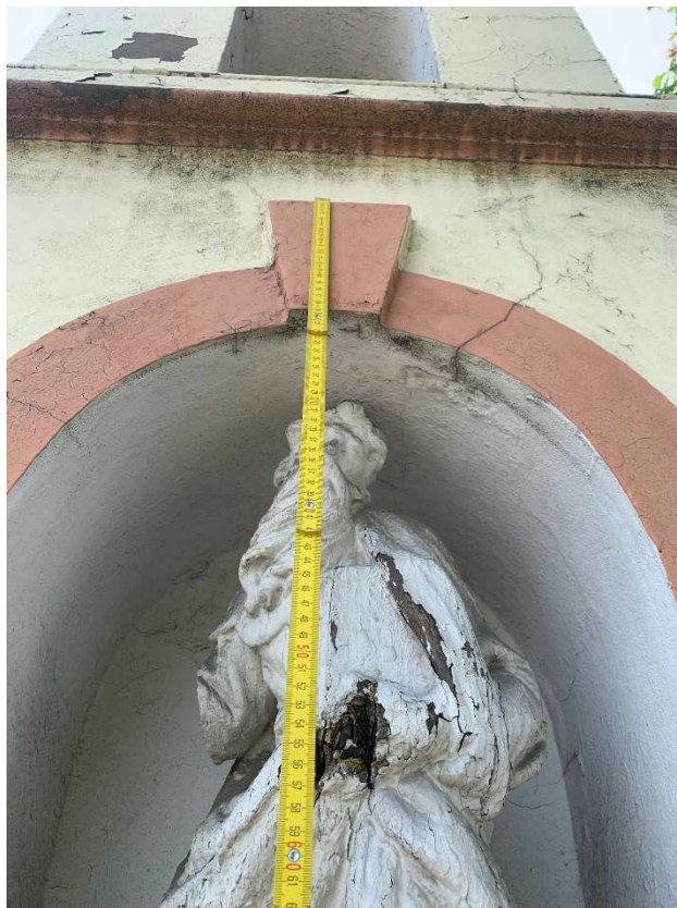
Zdj. nr 6 – Pęknięcie nadproża wnęki
