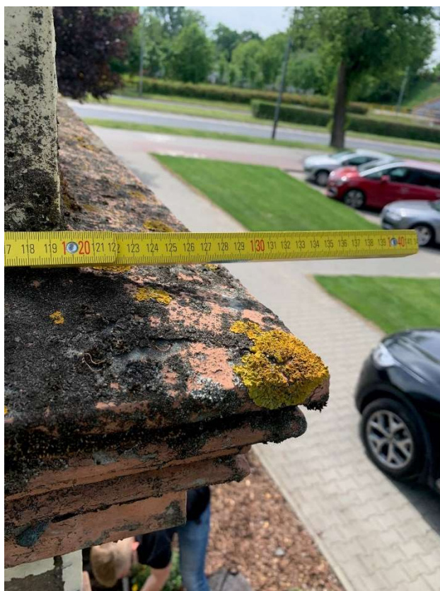
Zdj. nr 11 – Zabrudzenia i wykwity grzybów na gzymsie
