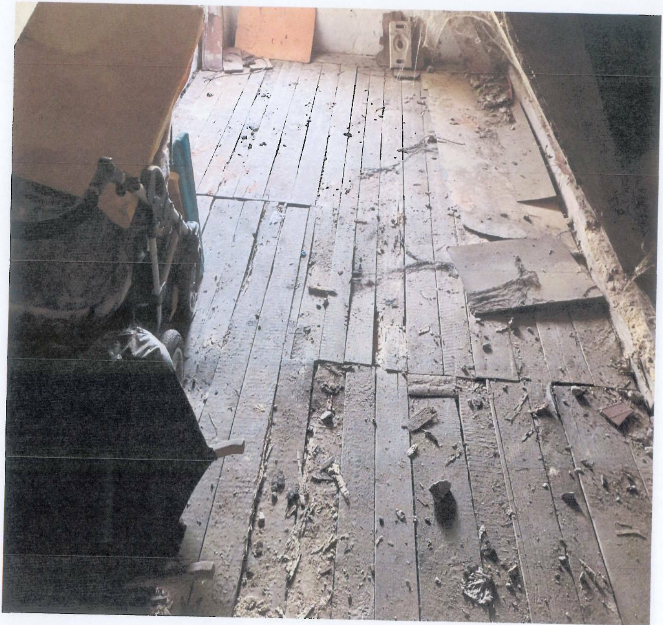
Podłoga nad poddaszem budynku
