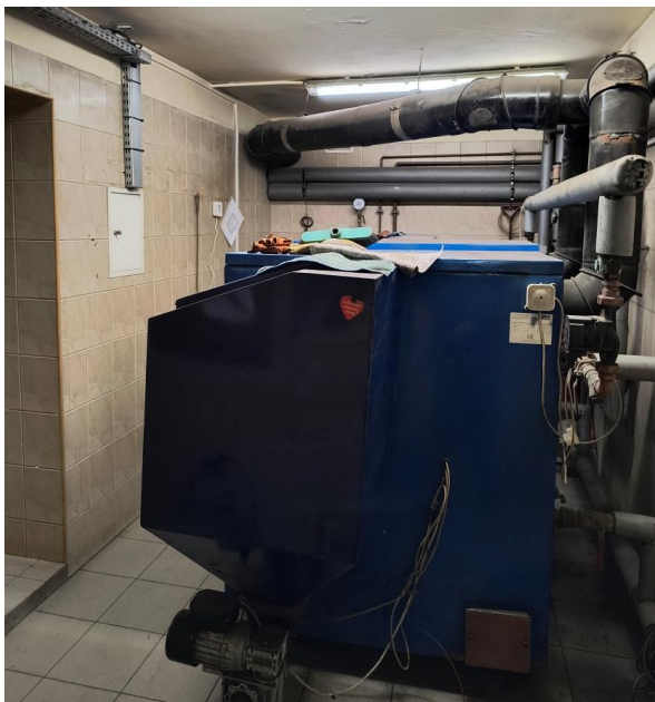
Rys. nr 1 – Kotłownia
