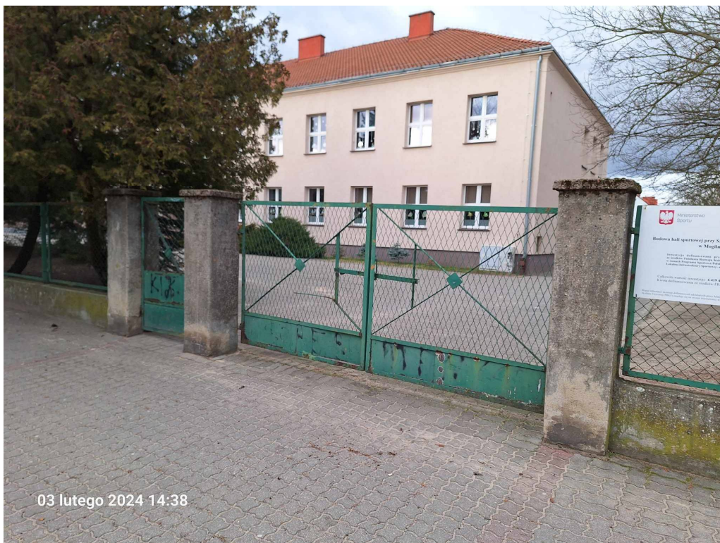
Fot. 4. Wschodnia część ogrodzenia. Widok na bramę wjazdową oraz furtkę.
