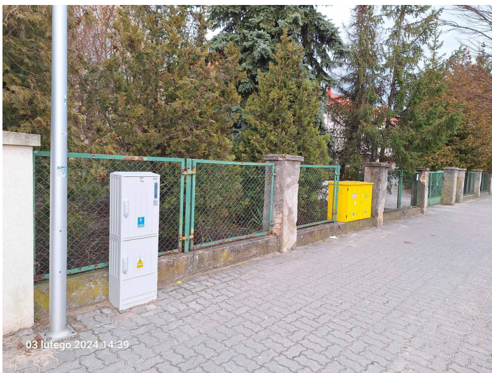
Fot. 2. Lokalizacja skrzynki elektrycznej oraz skrzynek gazowych.
