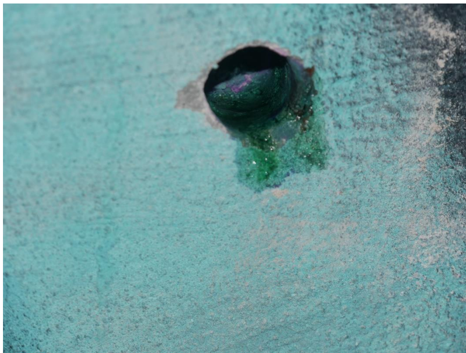
Fot. 2. Widoczny odwiert w miejscu pomiarowym nr 1 – belka skrajna
