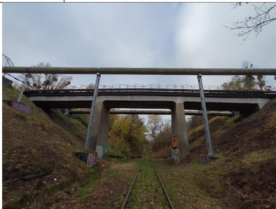
Wiadukt drogowego nad linią kolejową w ciągu ul. Toruńskiej
