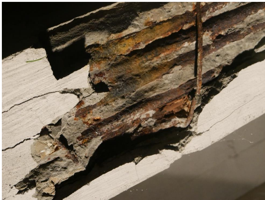
Fot. 1. Widoczne zbrojnie podłużne i poprzeczne belek.
