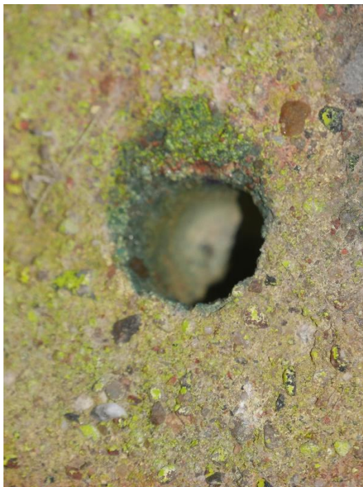
Fot. 1. Widoczny odwiert w miejscu pomiarowym nr 2 – korpus przyczółka południowego
