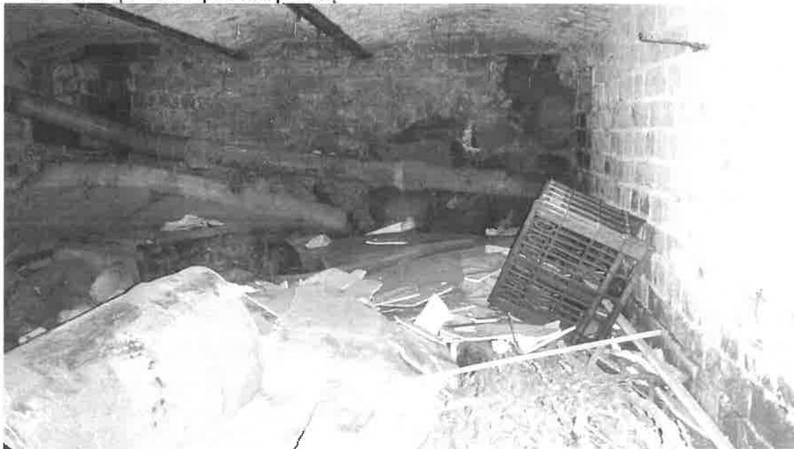
Fot 4. Widok oparcia stropów nad piwnicą
