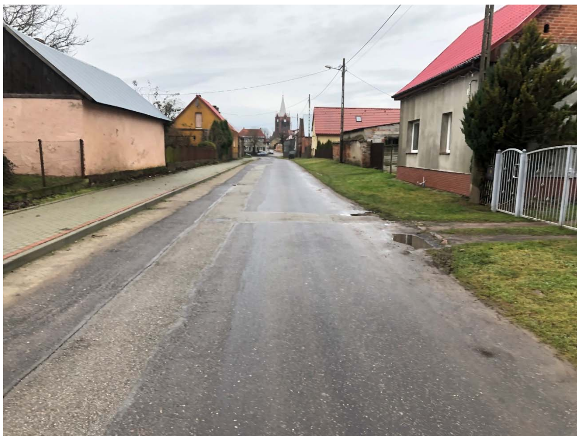
Zdjęcie 6. Widok na wysokości budynku nr 12 (zdjęcie w kierunku początku ulicy Żeromskiego)
