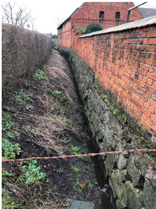
Zdjęcie 12. Widok rowu do odbudowy
