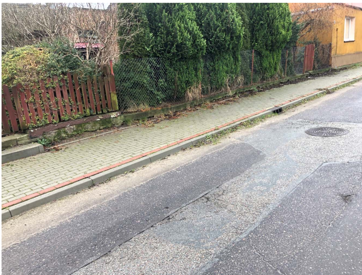
Zdjęcie 8. Widok na wysokości posesji na 10 (zdjęcie w kierunku początku inwestycji)
