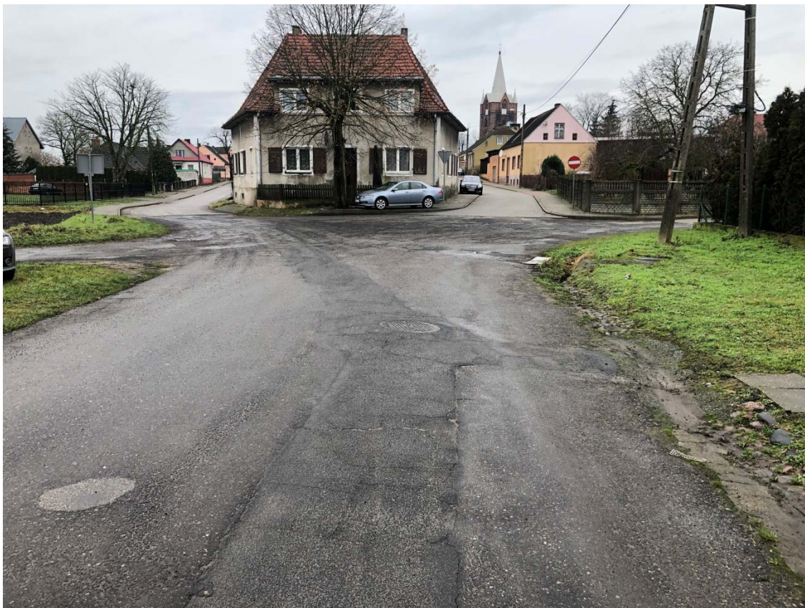
Zdjęcie 3. Widok początku ulicy Żeromskiego (zdjęcie w kierunku planowanego skrzyżowania o ruchu okrężnym)
