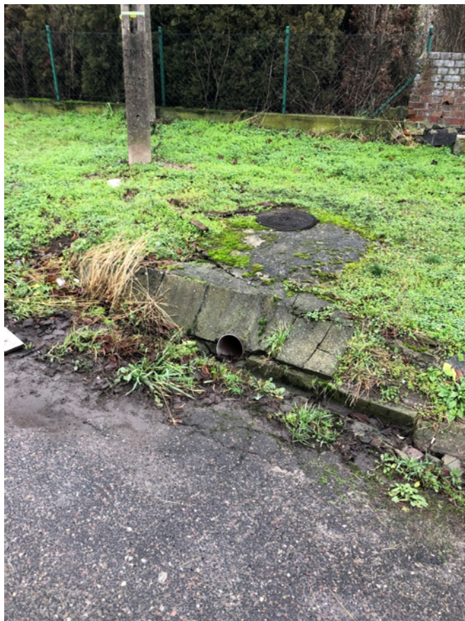
Zdjęcie 13. Widok z rejonu skrzyżowania o ruchu okrężnym (ściek do przebudowy)
