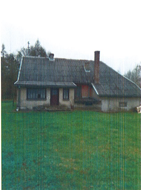
Stan pokrycia dachu z eternitu
