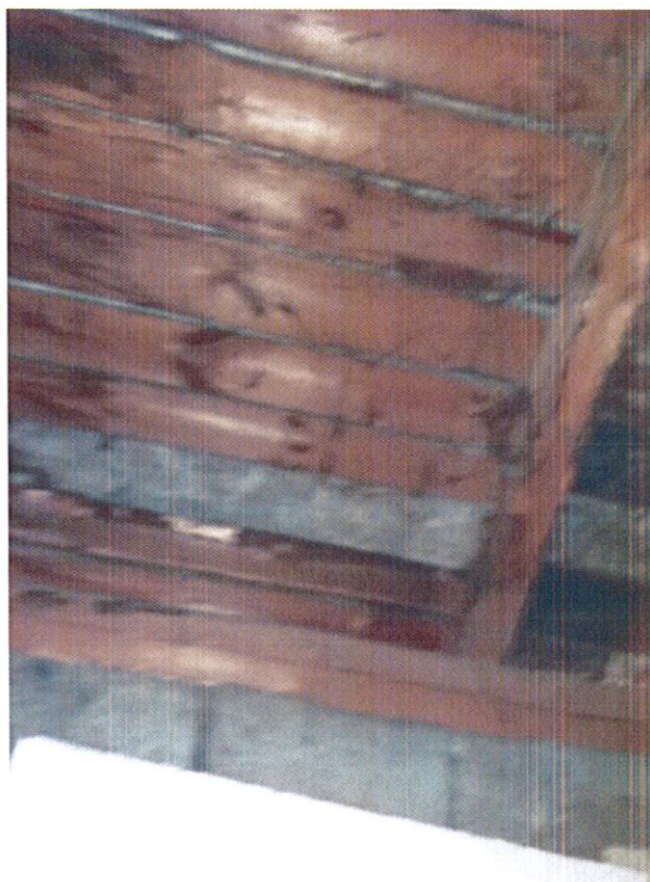
Drewniany stropodach kotłowni
