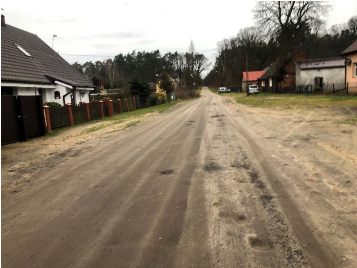
Zdjęcie 5. Widok na wysokości budynku nr 9 (zdjęcie w głąb drogi gminnej)
