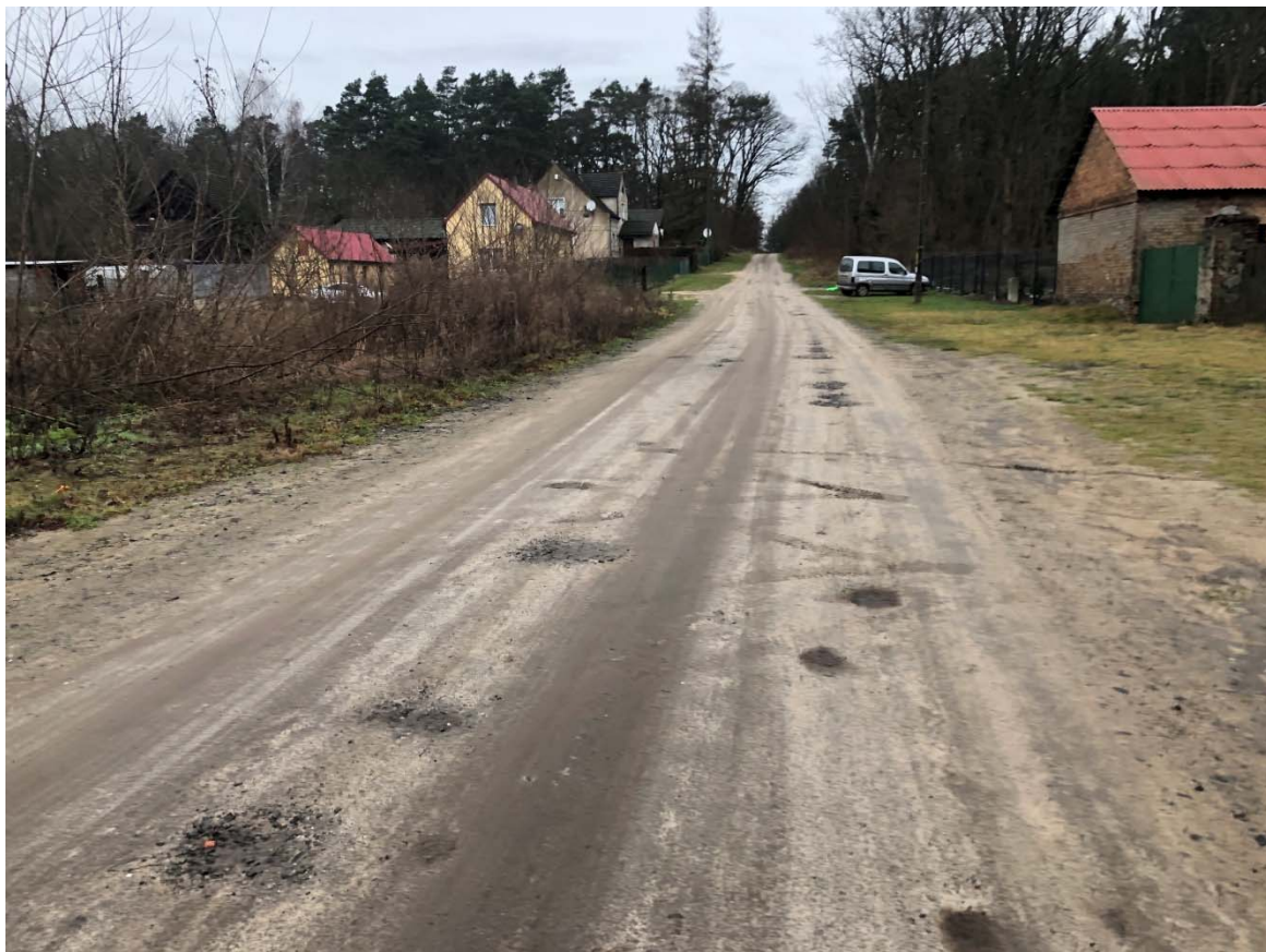
Zdjęcie 6. Widok na wysokości budynku nr 14 (zdjęcie w głąb drogi gminnej)
