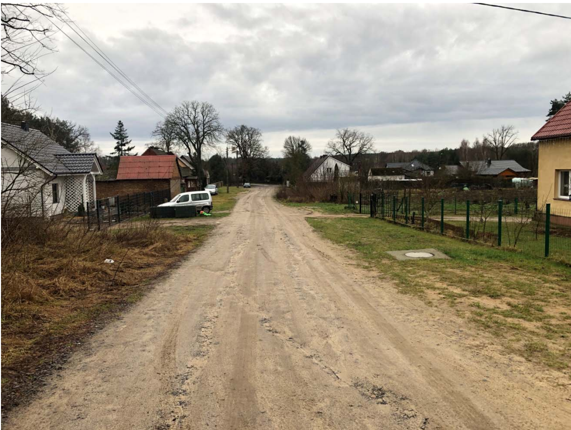
Zdjęcie 10. Widok w rejonie końca inwestycji (zdjęcie w kierunku drogi wojewódzkiej nr 127)
