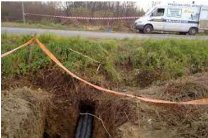
Rys. 31. Kanał kablowy umieszczony metodą przewiertu
