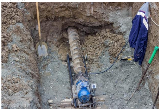
Rys. 30. Wykonywanie przewiertu
