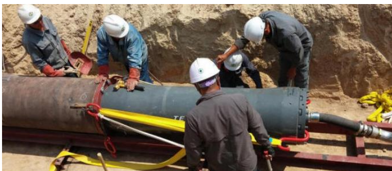
Rys. 28. Przecisk z ubijakiem umieszczonym za rurą stalową
