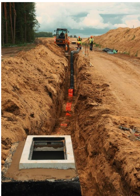
Rys. 34. Zamontowana studzienka kablowa
