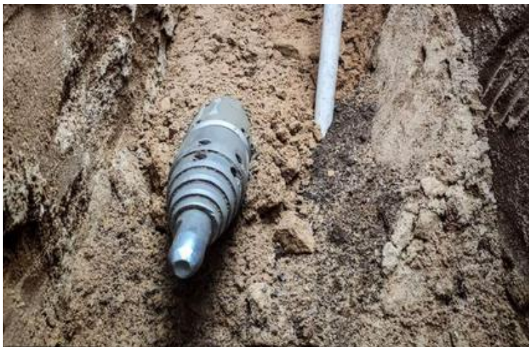
Rys. 27. Kret ciągnący rurę
