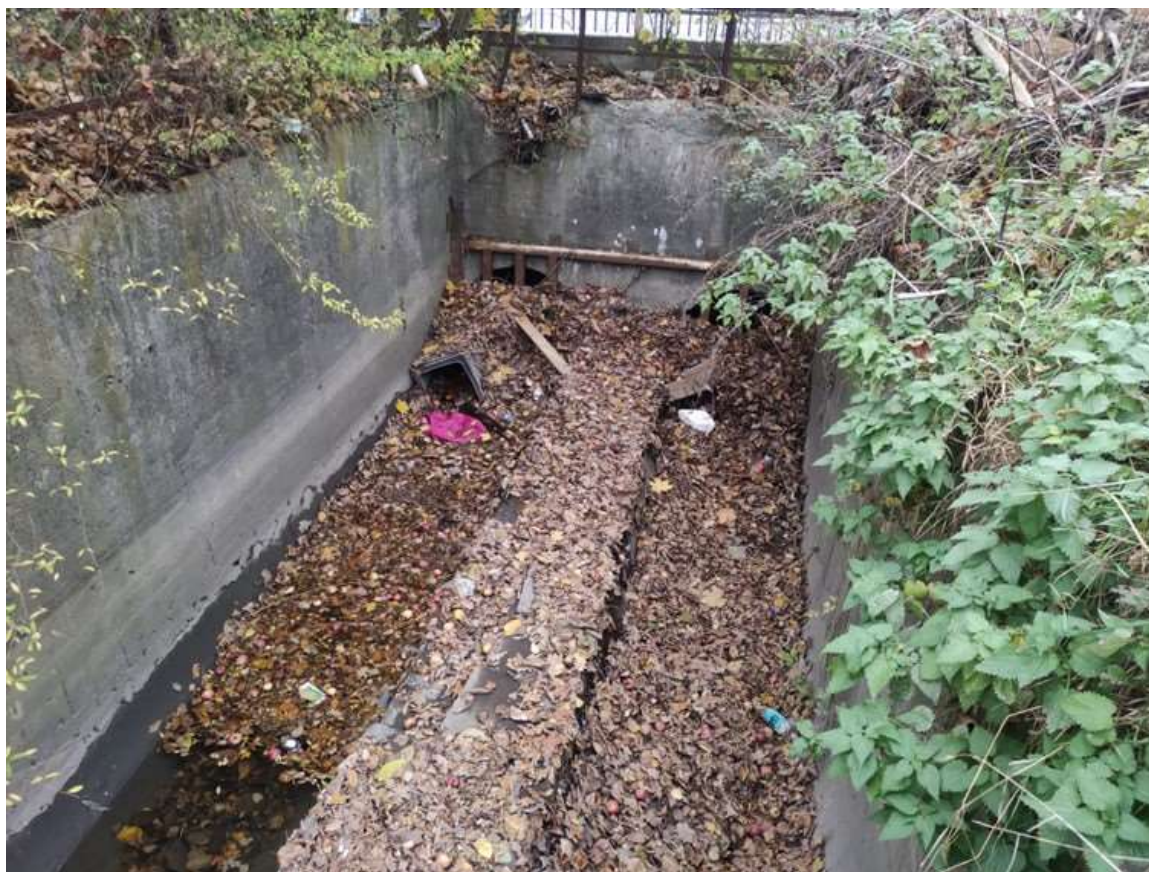
Zdjęcie 11 Witeradówka – wlot odcinka otwartego do odcinka zarurowanego
