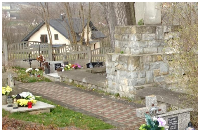
Mur pld. po str. zewnętrznej niemal w połowie zastał przysłonięty wskutek podniesienia poziomu cmentarza cywilnego wraz z alejką.
