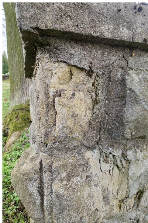
Lokalnie kamień w miejscach słabszej struktury osypuje się tworząc rozległe ubytki.
