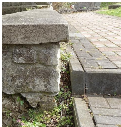
Mur pld. po str. zewnętrznej niemal w połowie zastał przysłonięty wskutek podniesienia poziomu cmentarza cywilnego wraz z alejką.
