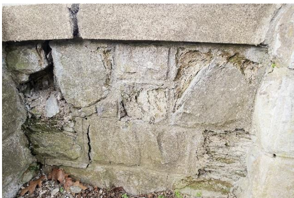
Lokalnie kamień w miejscach słabszej struktury osypuje się tworząc rozległe ubytki.
