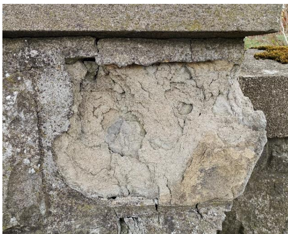
Lokalnie kamień w miejscach słabszej struktury osypuje się tworząc rozległe ubytki.
