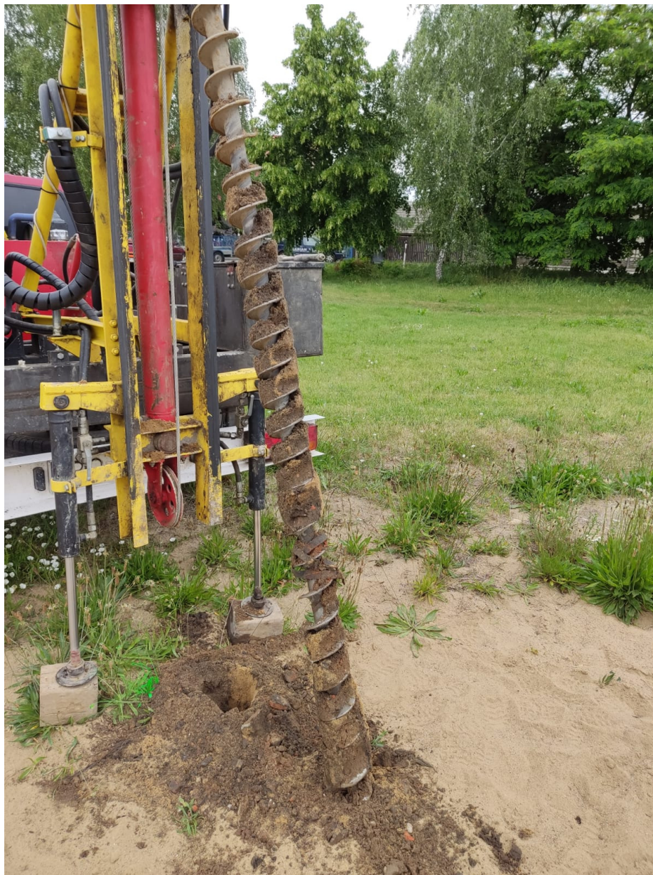
fol.5. Lokalizacja odwiertu geotechnicznego nr 5
