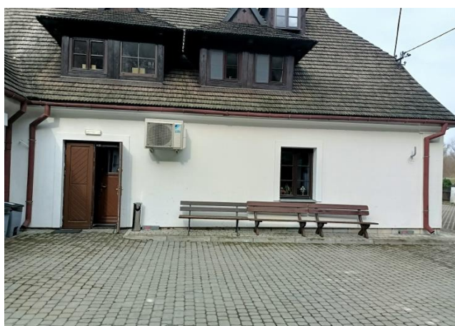
Elewacja wschodnia przy tylnym wyjściu z obiektu.
