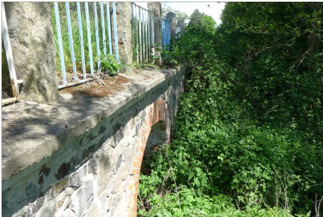
Fot. 3 – Widok od dolnej wody
