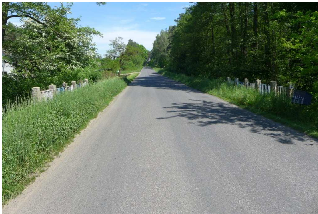
Fot. 1 – Część przejazdu.
