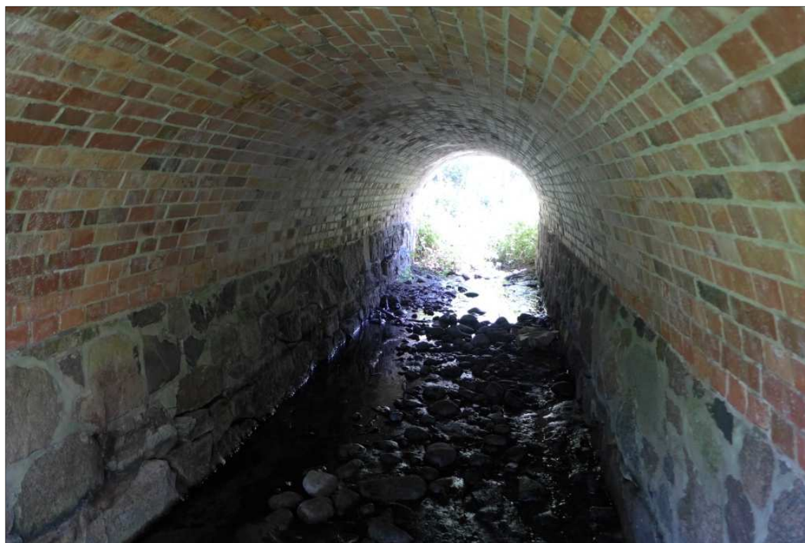
Fot. 4 – Przestrzeń podmostowa
