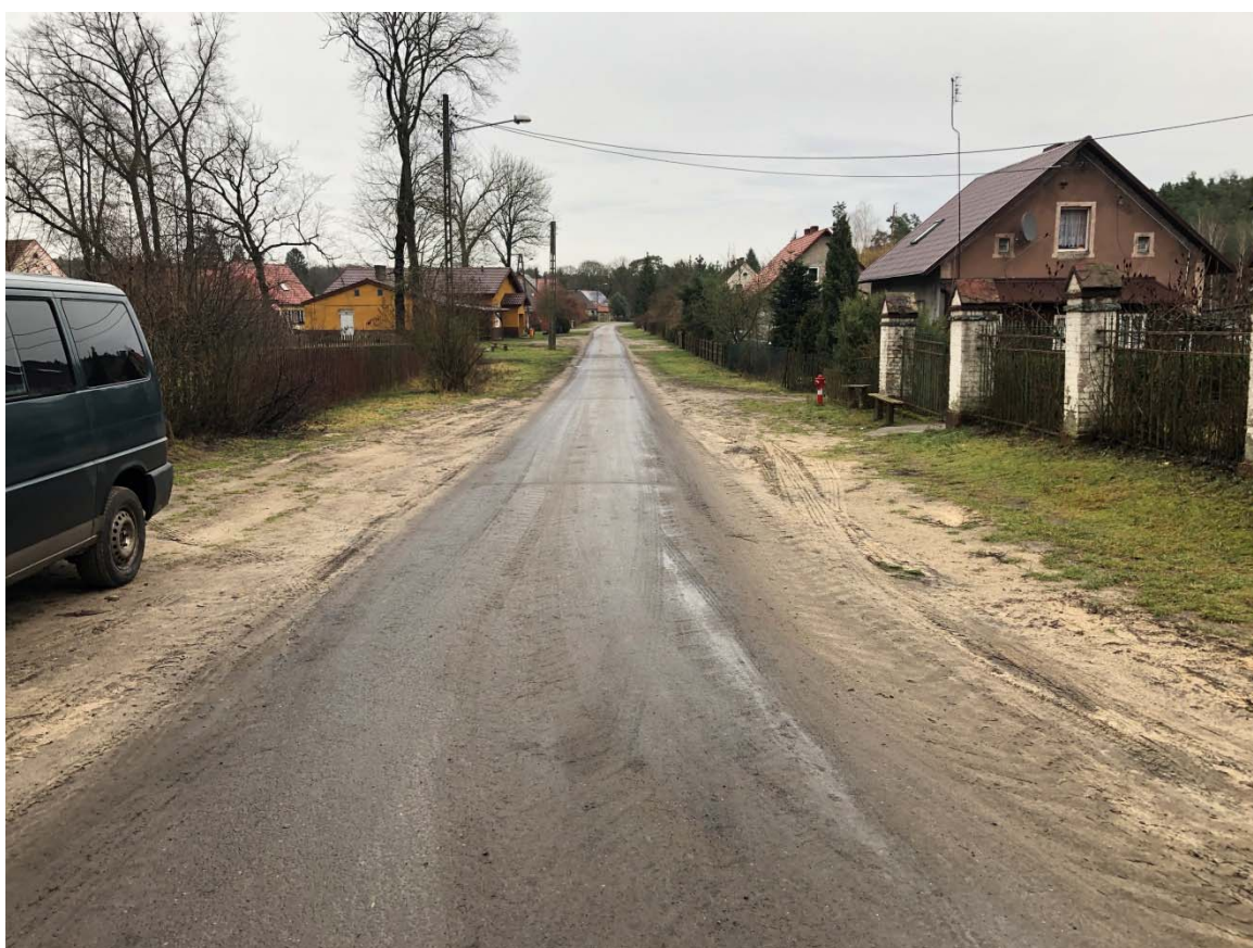
Zdjęcie 12. Widok w rejonie zjazdu na drogę wewnętrzną (zdjęcie w kierunku drogi powiatowej)
