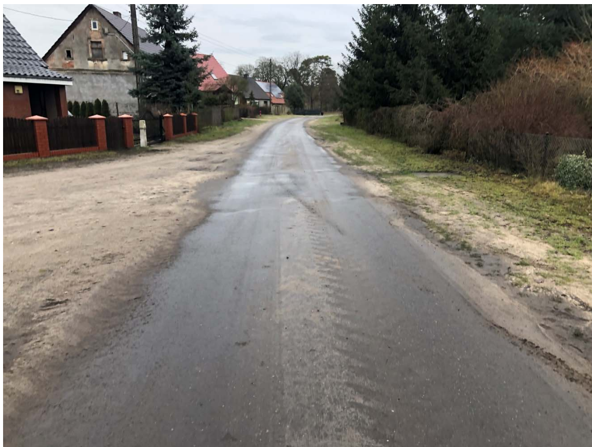
Zdjęcie 7. Widok na wysokości posesji nr 12 (zdjęcie w kierunku drogi powiatowej)
