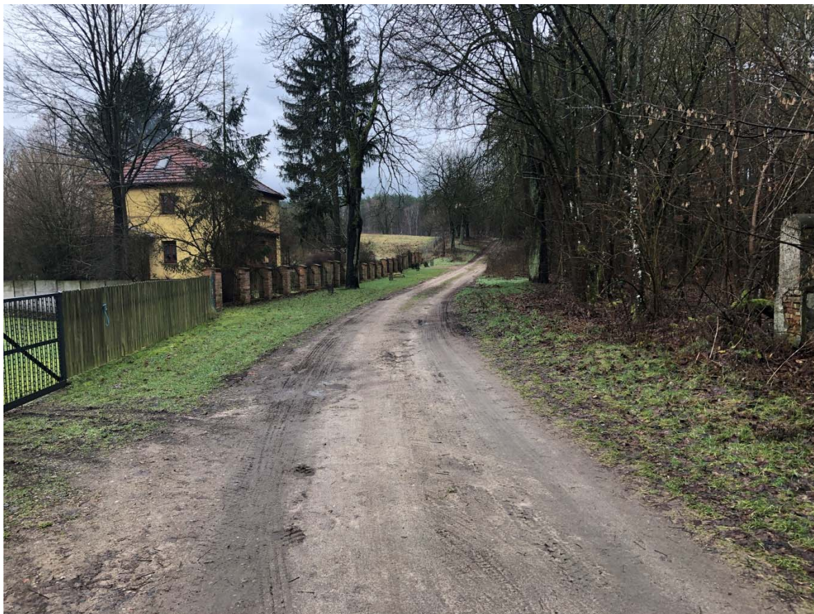
Zdjęcie 16. Widok w rejonie posesji nr 17 (zdjęcie w głąb drogi wewnętrznej)
