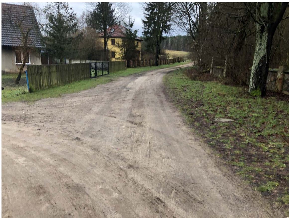
Zdjęcie 14. Widok w rejonie skrzyżowania z drogą wewnętrzną na dz. 80 (zdjęcie w głąb drogi wewnętrznej)
