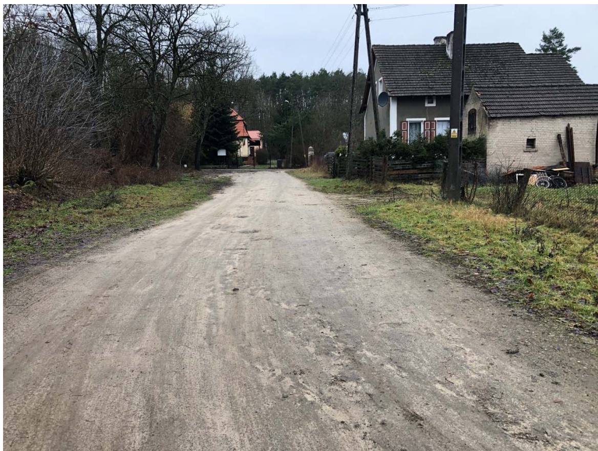
Zdjęcie 15. Widok w rejonie skrzyżowania z drogą wewnętrzną na dz. 80 (zdjęcie w kierunku drogi gminnej)
