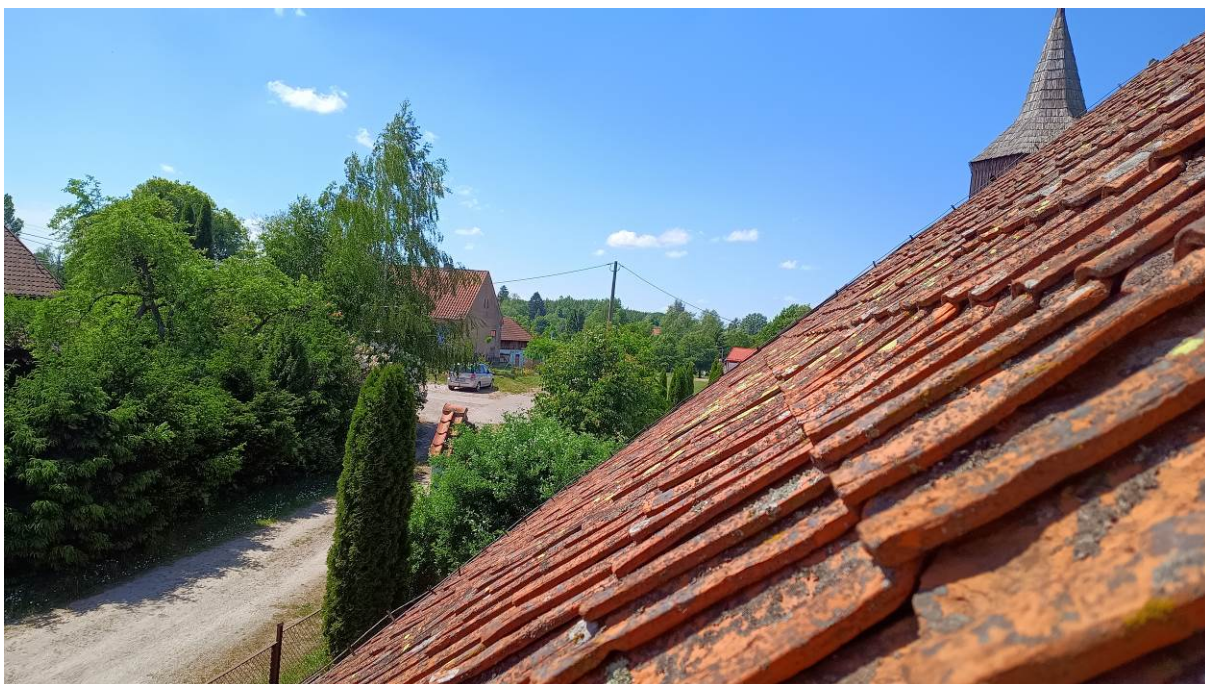
Zdj. 32. Widok pokrycia dachu z dachówki holenderki - widoczne porosty.
