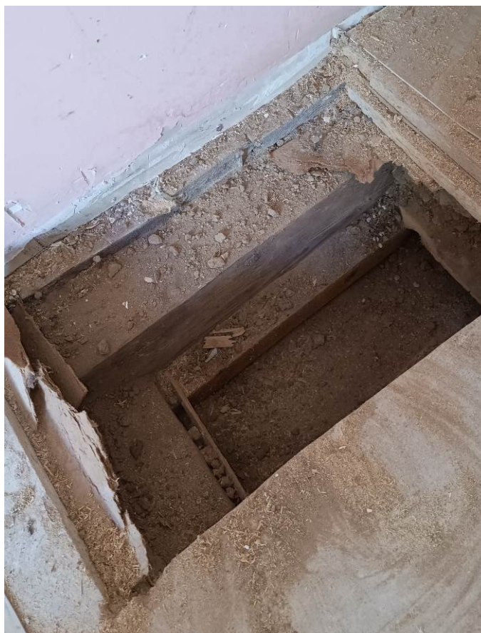
Zdj. 34. Odkrywka stropu nad parterem.
