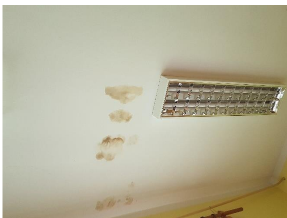
Zdj. 43. Zacieki na suficie nad parterem
