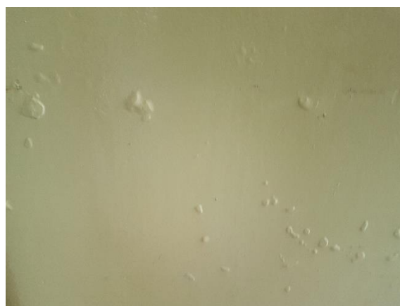
Zdj. 44. Kapilarne podciąganie wody gruntowej w jadalni
