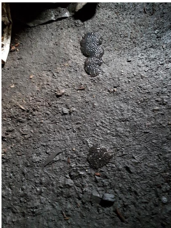
Zdj. 29. Podsiąkanie wody gruntowej widoczne na posadzce
