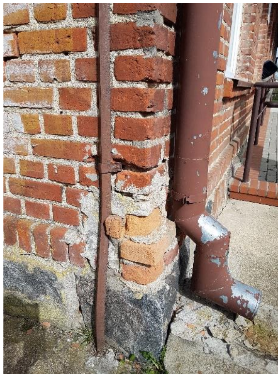
Zdj. 14. Nieudana próba naprawy narożnika
