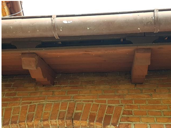
Zdj. 21. Detal krokwi i wentylacji dachu
