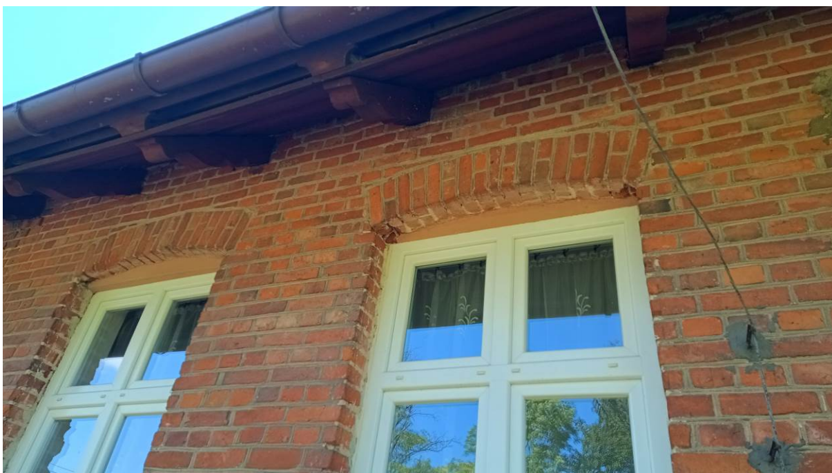
Zdj. 17. Stan nadproży krokwi oraz orywnowania. Brak widocznych odspojień i uszkodzeń.
