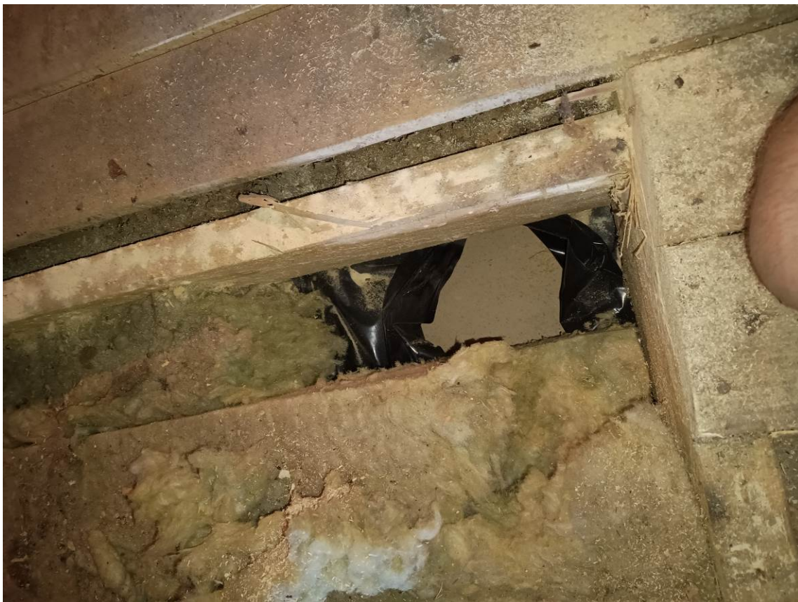
Zdj. 30. Przekrój konstrukcji stropu I piętra. Widoczna izolacja termiczna z wełny mineralnej.
