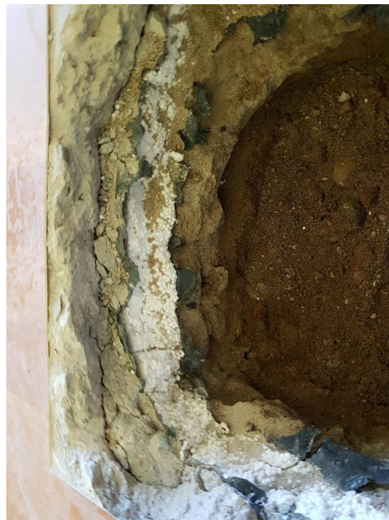
Zdj. 42. Warstwy posadzki na gruncie, brak wody, piasek wilgotny
