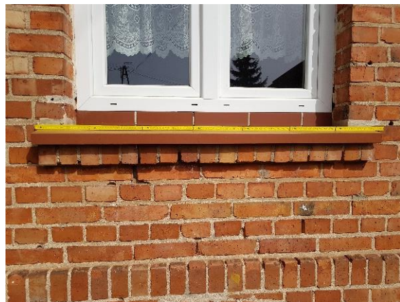
Zdj. 6. Parapet ceglany z blaszanym opierzeniem
