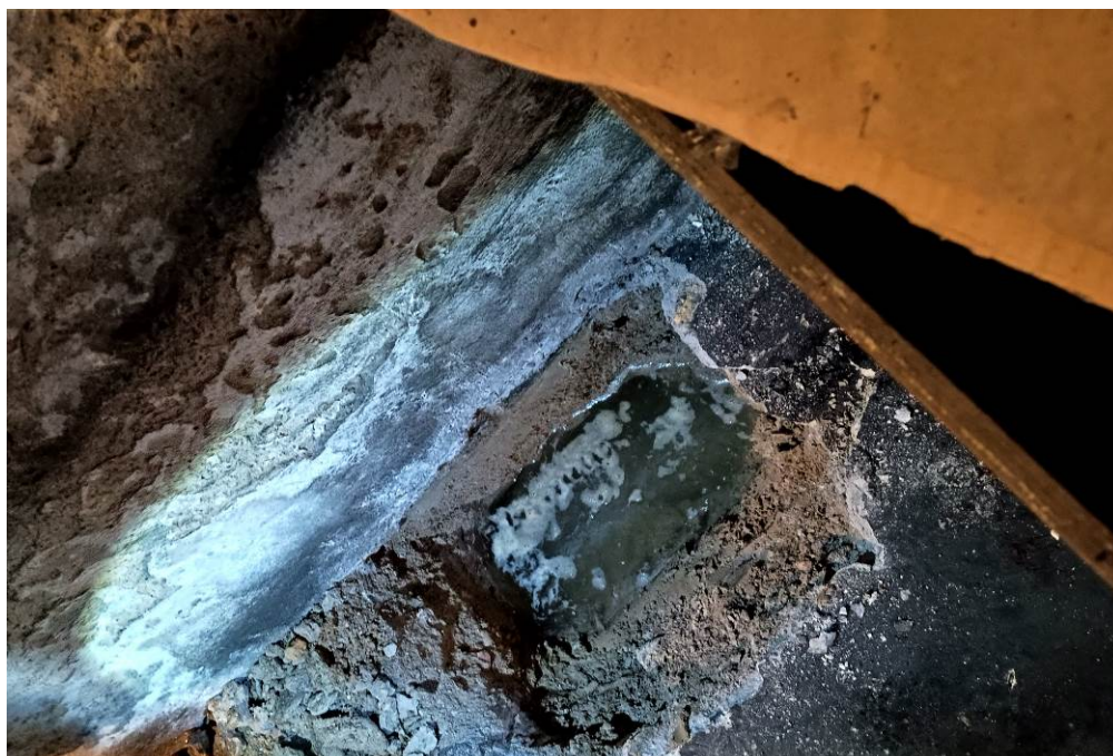
Zdj. 18. Odkrywka fundamentu budynku od wewnątrz – widoczna woda gruntowa powodująca zawilgocenie ścian fundamentowych, piwnic i części ścian parteru. Brak izolacji przeciwwodnej.
