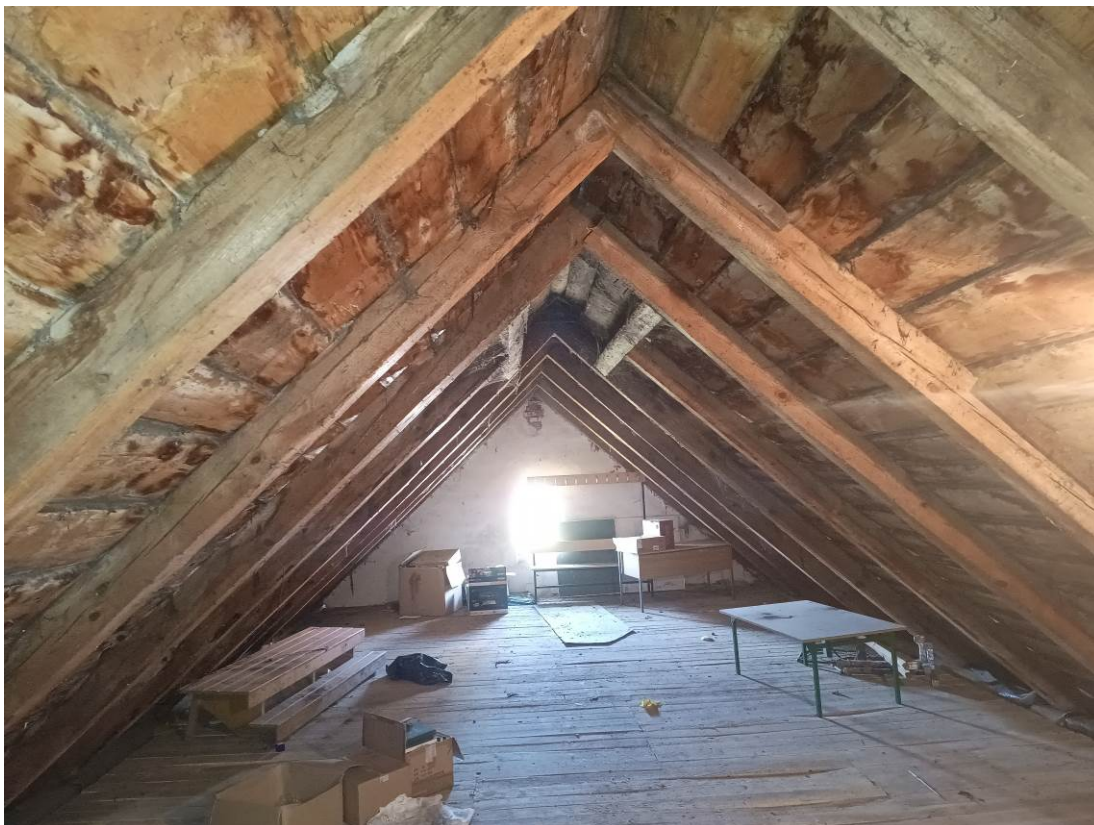
Zdj. 26. Widok poddasza użytkowego – brak widocznej korozji krokwi, na deskowaniu zakładkowym widoczne ślady zawilgocenia związane z brakiem membrany dachowej, widoczne pęknięcia podłużne krokwi.
