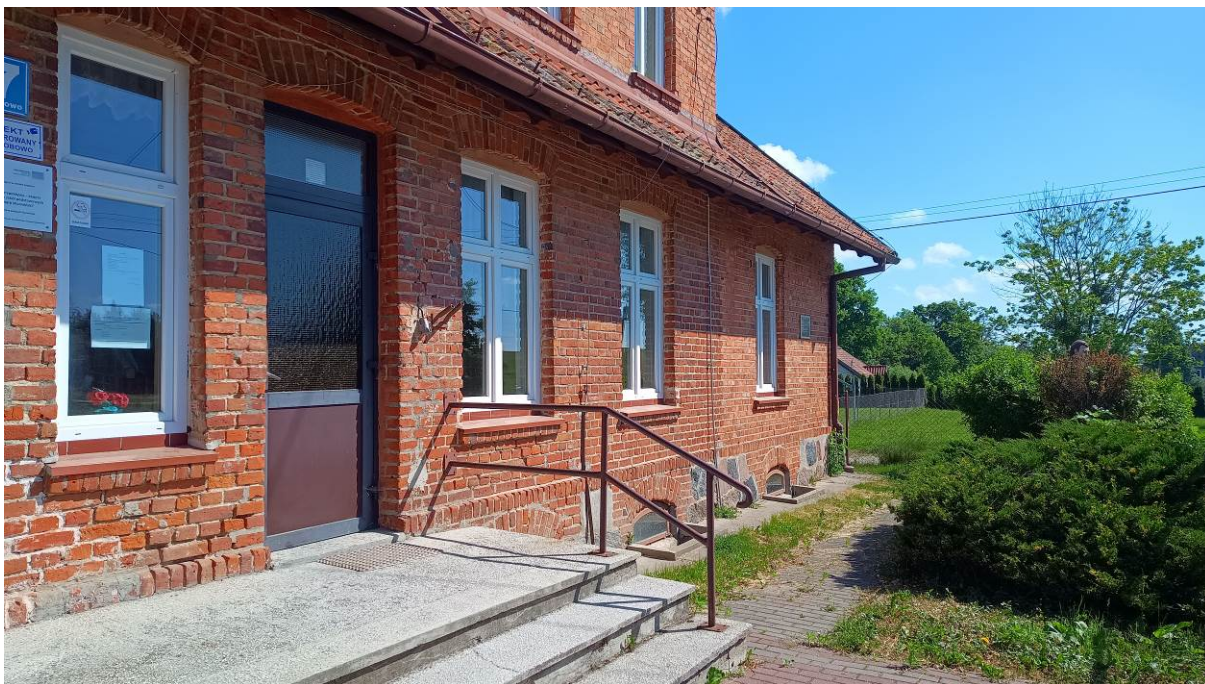
Zdj. 15. Korozja cegieł i ubytki zaprawy ścian zewnętrznych.
