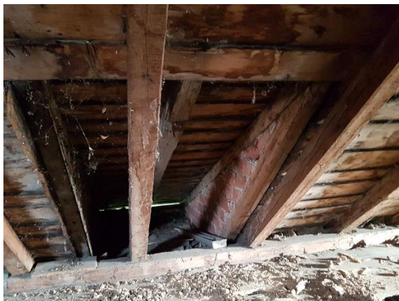
Zdj. 55. Niewykorzystane wymiany pod oświetlenie
