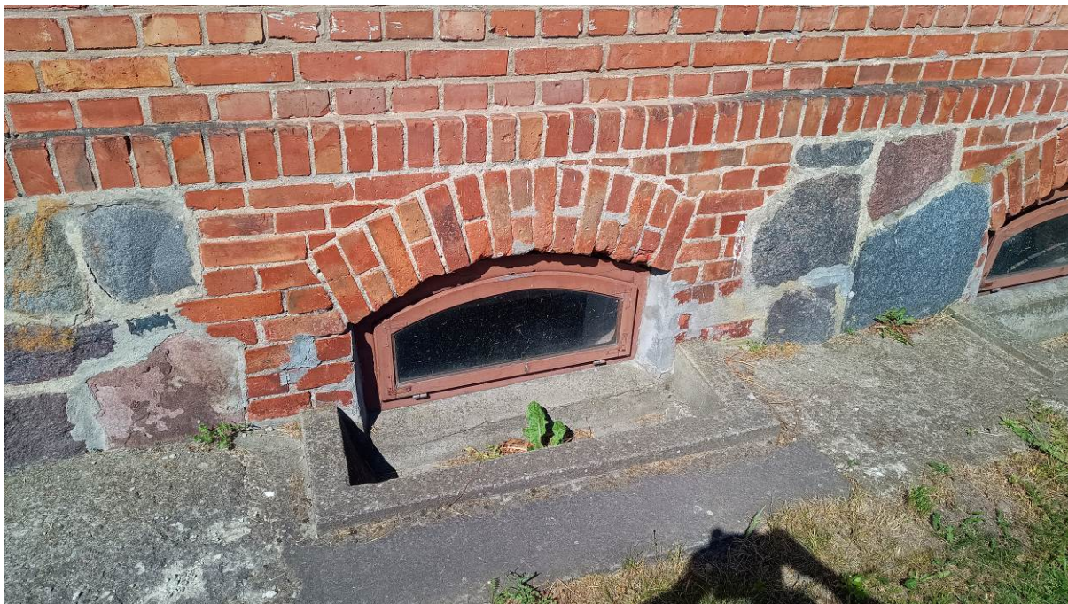
Zdj. 14. Nieszczelne okna piwniczne powodujące przenikanie wody deszczowej do piwnic i dodatkowe zawilgocenie.
