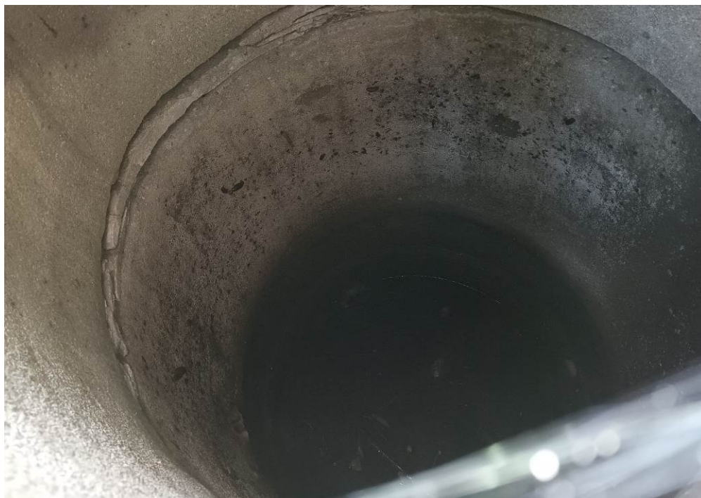
Zdj. 8. Studnia odprowadzająca wodę z budynku – widoczny poziom wody.
