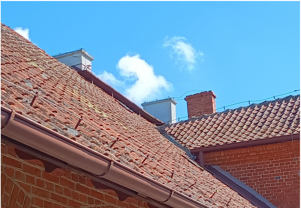
Zdj. 12. Widok kominów – rysy oraz odspojenia łączń cegieł. Widoczne porosty na połaci dachu.
