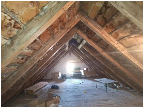
Zdj. 53. Układ krokwi na strychu
