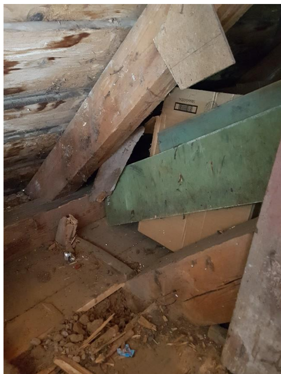
Zdj. 58. Mocowanie krokwi i zastrzału w belce wiązarowej
