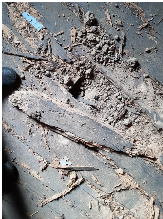
Zdj.64. Skorodowane deskowanie podłogi strychu
