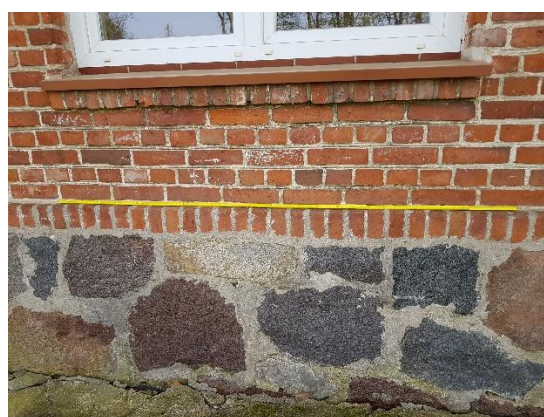
Zdj. 12. Kamienna podmurówka z ceglanym gzymsem
