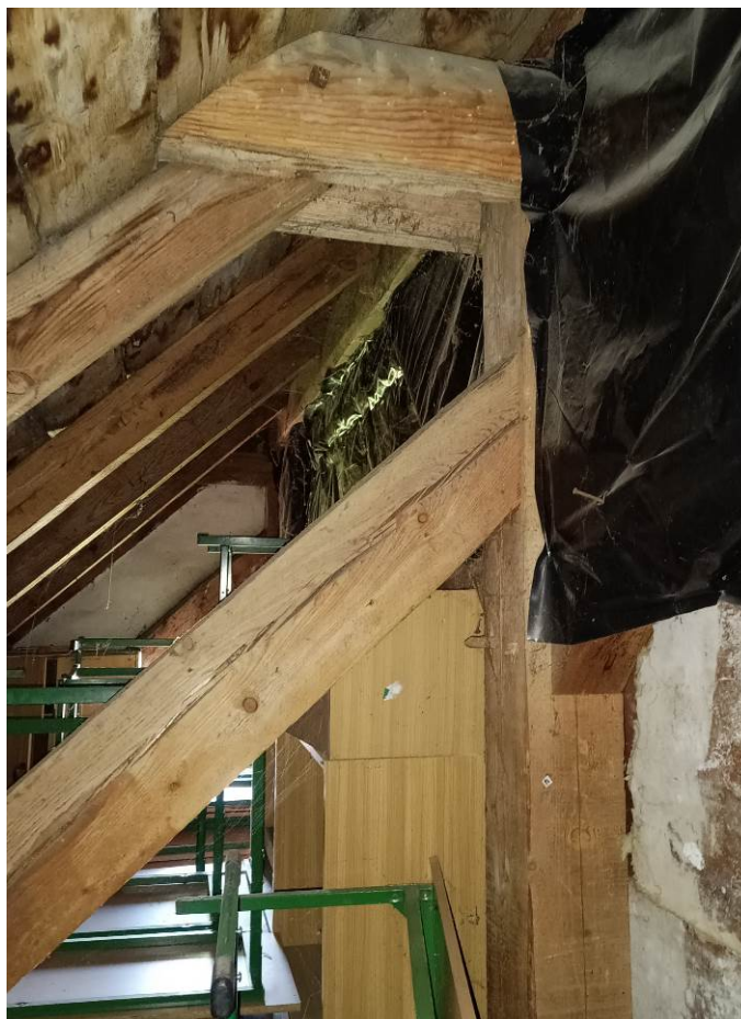
Zdj. 27. Widok konstrukcji więzara pełnego – widoczny wieszak, kleszcze, krokwie i zastrzał – brak widocznej korozji biologicznej, widoczne pęknięcia podłużne wieszaka, krowi i zastrzału.
