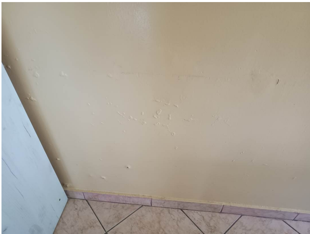
Zdj. 22. Odchodzenie farby i purchle w zawilgoconej ścianie parteru w związku z podciąganiem kapilarnym od ścian piwnic.
