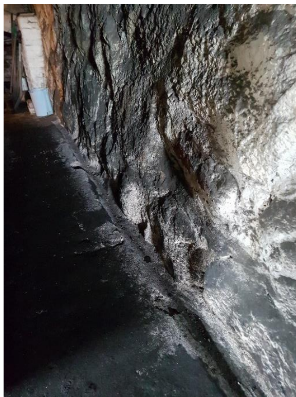
Zdj. 30. Rynna odciekowa wzdłuż ściany
