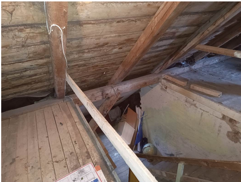
Zdj. 28. Widok poddasza użytkowego – połączenia z płatwią, widoczny miecz oraz drewniane schody na poddasze nieużytkowe. Widoczne pęknięcia wzdłuż osi podłużnej krokwi. Brak widocznej korozji biologicznej elementów więźby.
