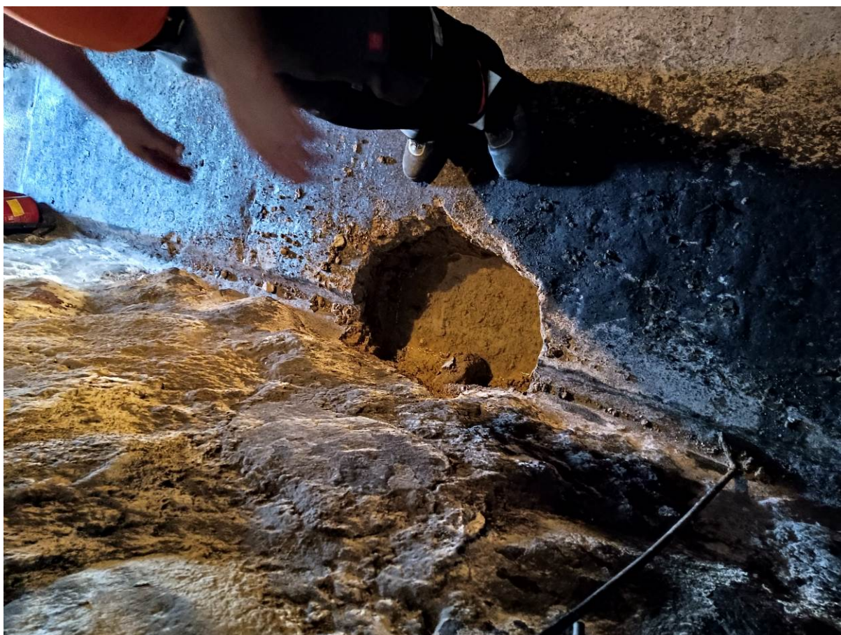
Zdj. 19. Odkrywka fundamentu budynku od wewnątrz – widoczna woda gruntowa powodująca zawilgocenie ścian fundamentowych, piwnic i części ścian parteru. Brak izolacji przeciwwodnej.
