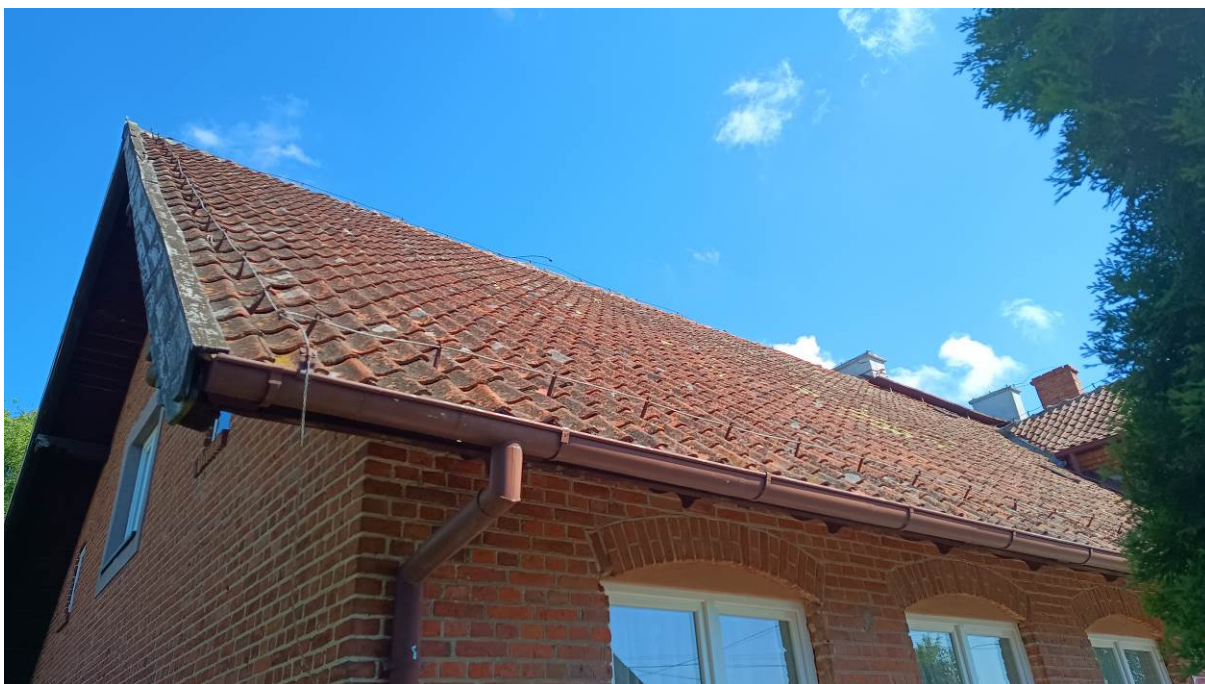
Zdj. 16. Stan nadproży okiennych, orywnowania i połaci dachowej. Geometria dachu bez widocznych śladów zapadnięć i ugięć. Widoczne porosty na połaci dachu.
