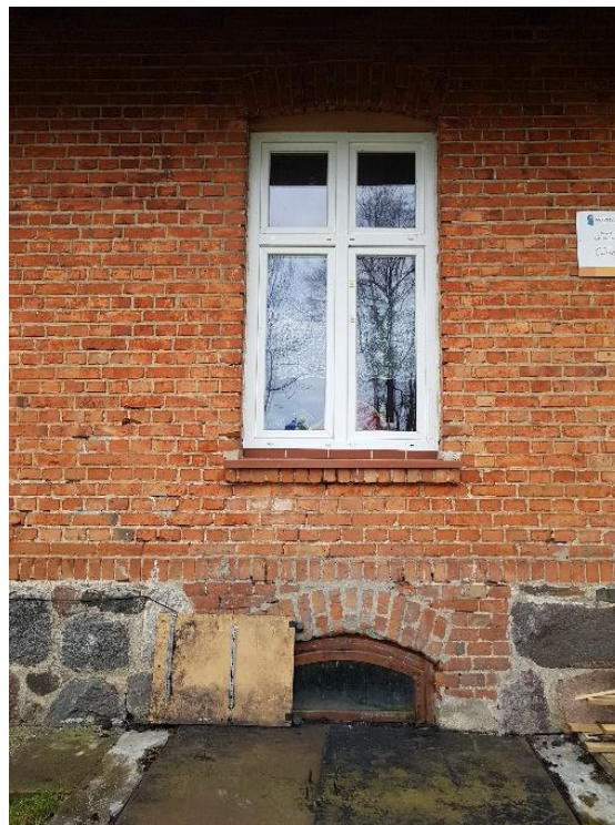
Zdj. 16. Przemurowania na elewacji północnej
