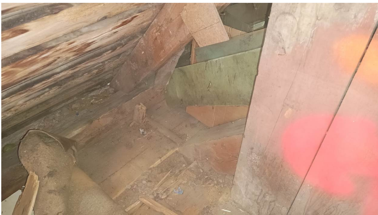
Zdj. 29. Widok połączenia krokwi z płatwią oraz zastrzału z belką więzara. Brak widocznej korozji. Na deskowaniu widoczne zawilgocenie spowodowane najprawdopodobniej brakiem membrany dachowej.
