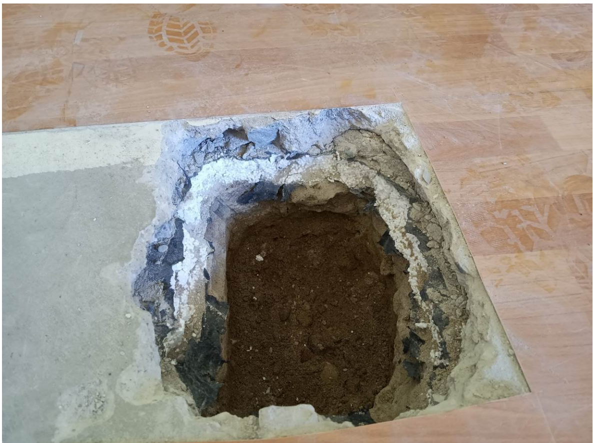
Zdj. 21. Odkrywka posadzki na gruncie części niepodpiwniczonej. Widoczna izolacja termiczna i przeciwwilgociowa. Grunt jest wilgotny, ale nie nasycony wodą jak w przypadku posadzki w piwnicy.
