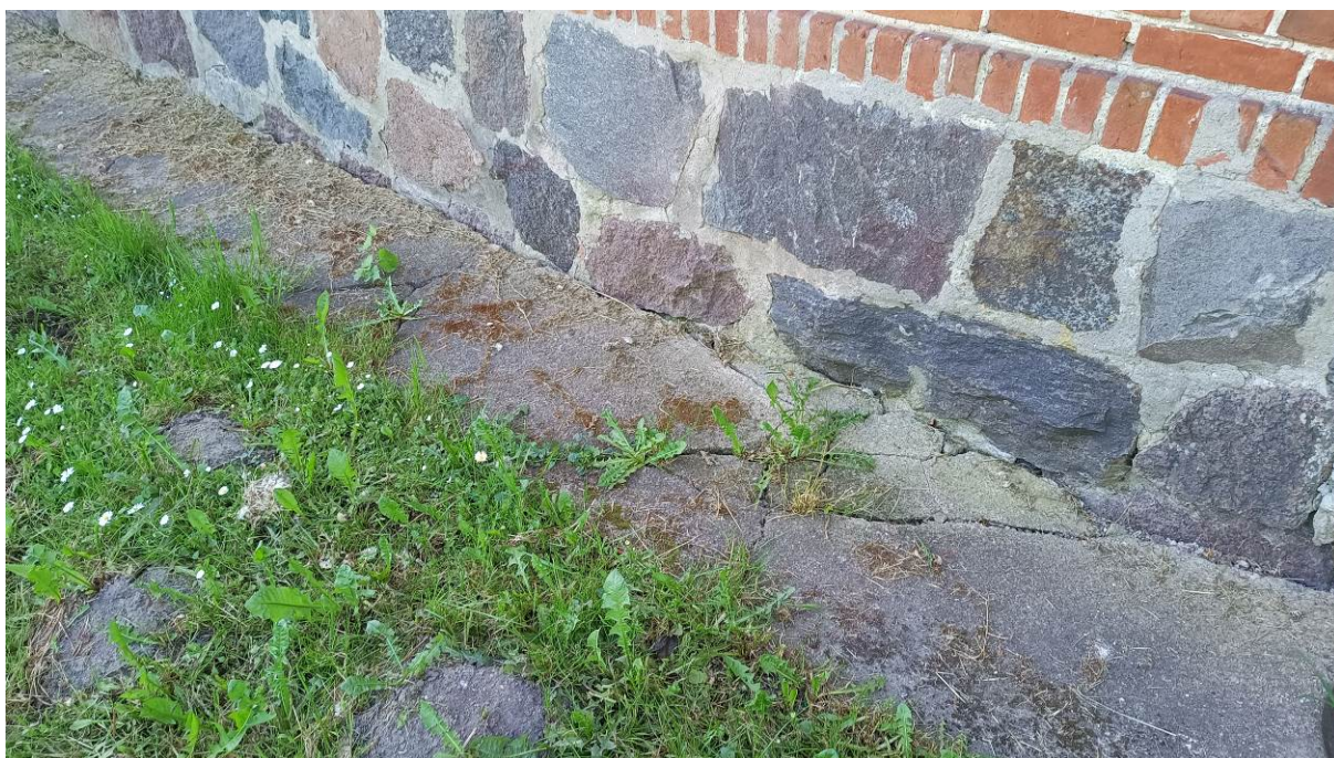
Zdj. 11. Pęknięta opaska w obrębie naroża północno-zachodniego budynku.
