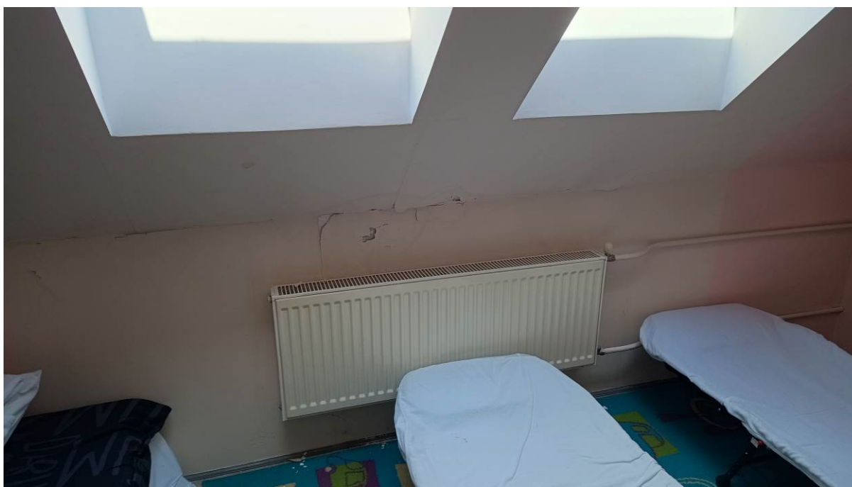
Zdj. 25. Pęknięcie połączenia na styku ściany z obudową g-k w poziomie piętra.
