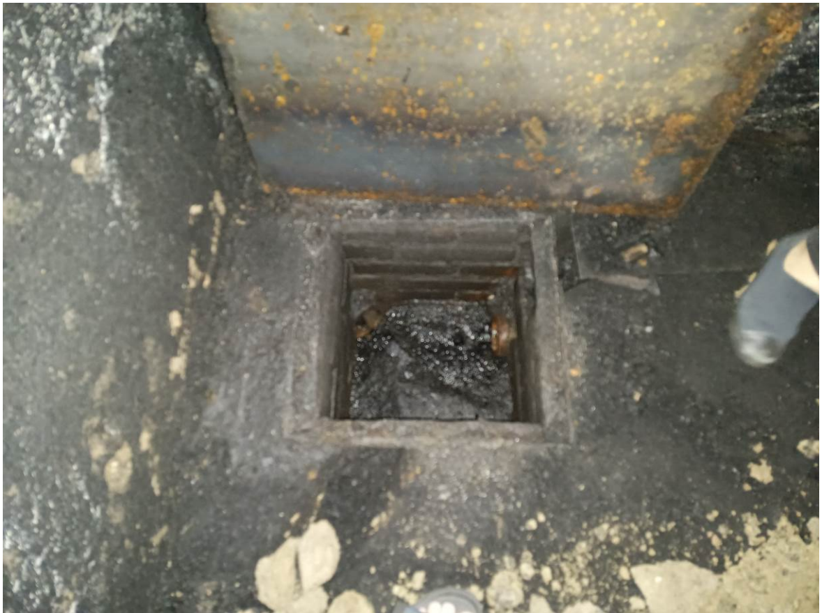
Zdj. 20. Zawilgocona studzienka odprowadzająca wodę z drenaży wewnątrz budynku do studni poza budynkiem. Na ścianach widoczne silne zawilgocenie ścian i posadzki.
