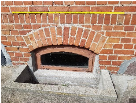
Zdj. 5. Okienko piwniczne z płytką studzienką
