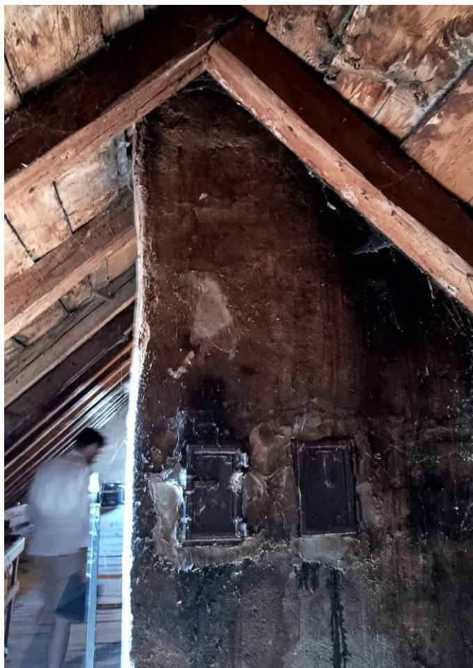
Zdj. 31. Widok kominów w poziomie poddasza nieużytkowego – widoczne przecieki z dachu.
