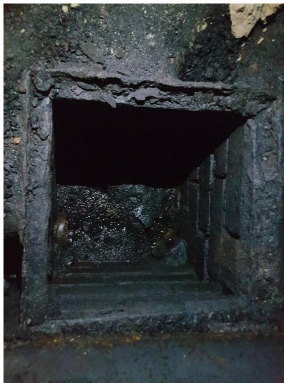
Zdj. 32. Kotłownia, studnia chłonna na drenażu
