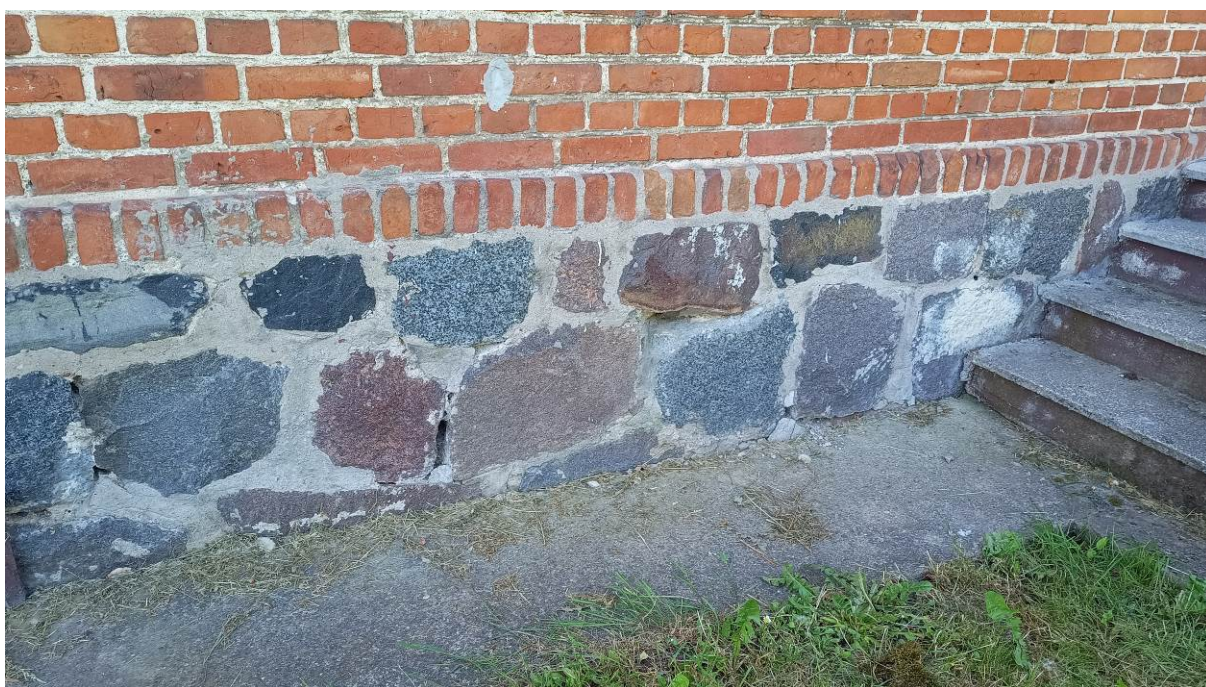
Zdj. 9. Ubytki zaprawy ścian zewnętrznych (widok ściany północnej).
