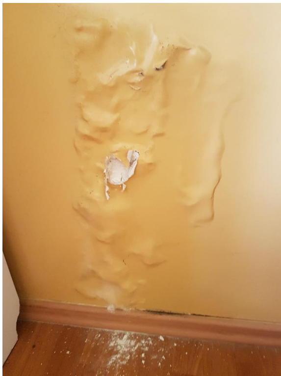
Zdj. 41. Kapilarne podciąganie wody gruntowej w sali lekcyjnej
