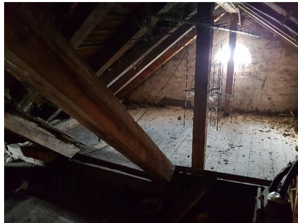
Zdj. 54. Konstrukcja wystawki
