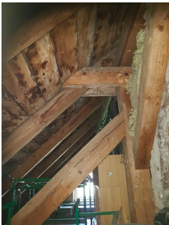
Zdj. 57. Węzeł więźby dachowej: słup, miecz, kleszcze, krokiew, zastrzał
