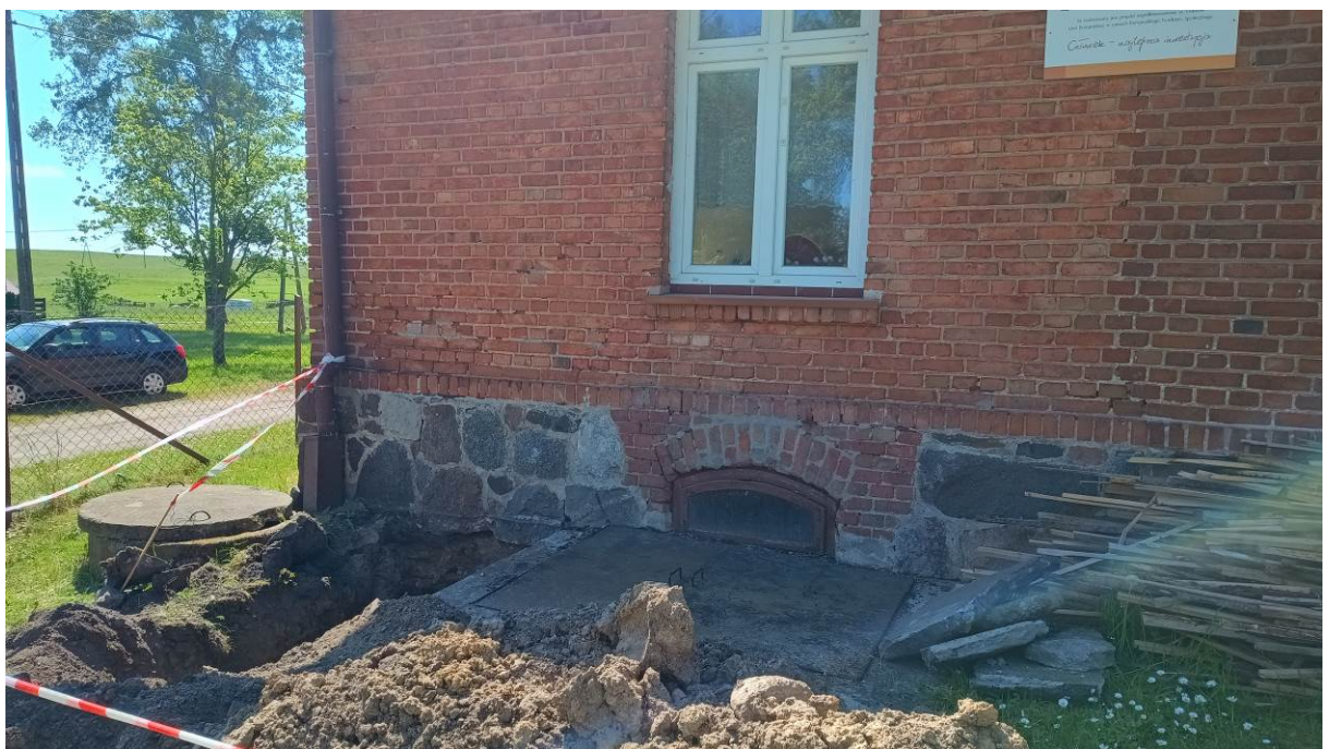
Zdj. 13. Ubytki spoin w ścianie oraz lokalizacja studni odprowadzającej wodę gruntową z drenaży.
