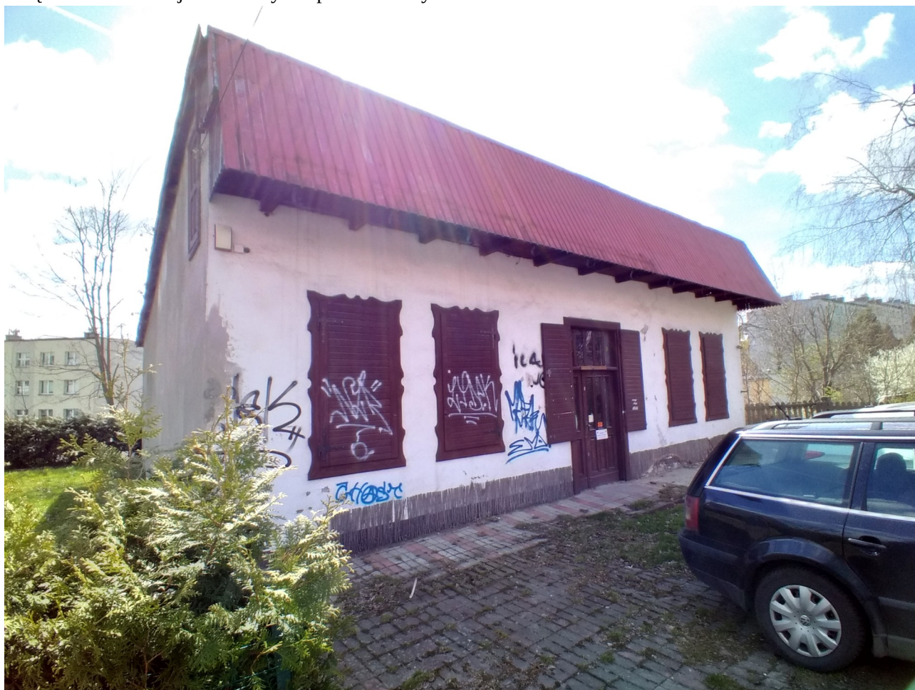
Załącznik – ul. 1 Maja 15D budynek przeznaczony do rozbiórki
