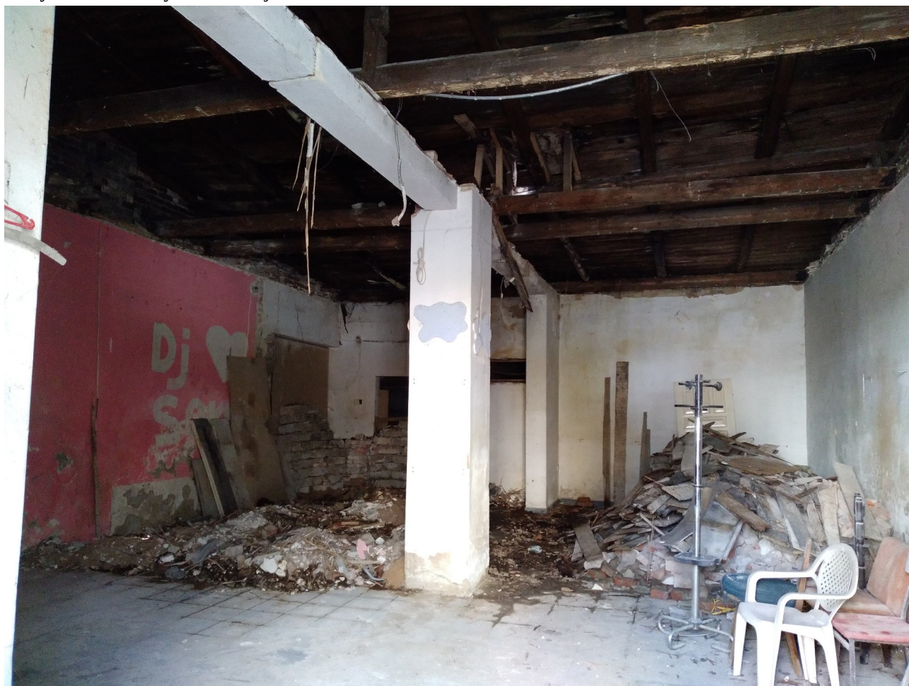
Budynek murowany – ul. 1 Maja 15D
