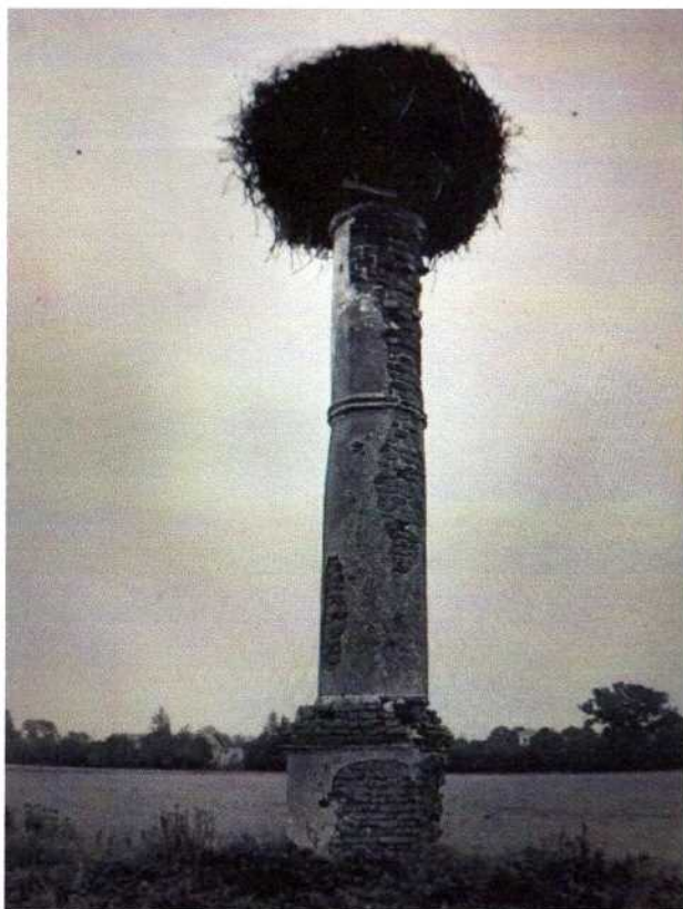
Fot. 3-4. Archiwalne zdjęcie przedstawiające kolumnę, brak informacji o czasie wykonania zdjęć. Widać, że już wtedy kolumna była zaniedbana: duże zniszczenia tynków, brak elementu wieńczącego kolumnę.
