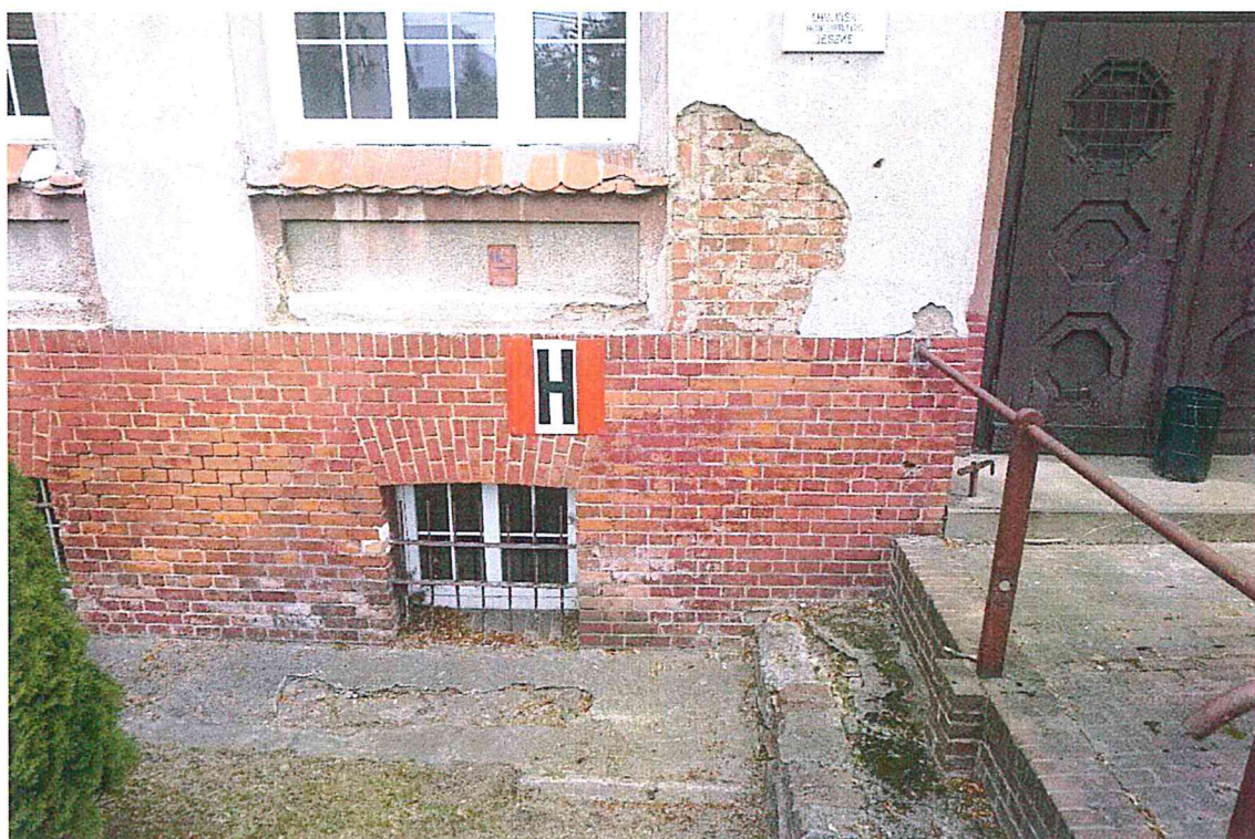
Fotografia 5. Malowanie cegły na kolor czerwony (oryginalna pomarańczowe) oraz ubytki w tynku i parapetach z dachówki karpiówki
