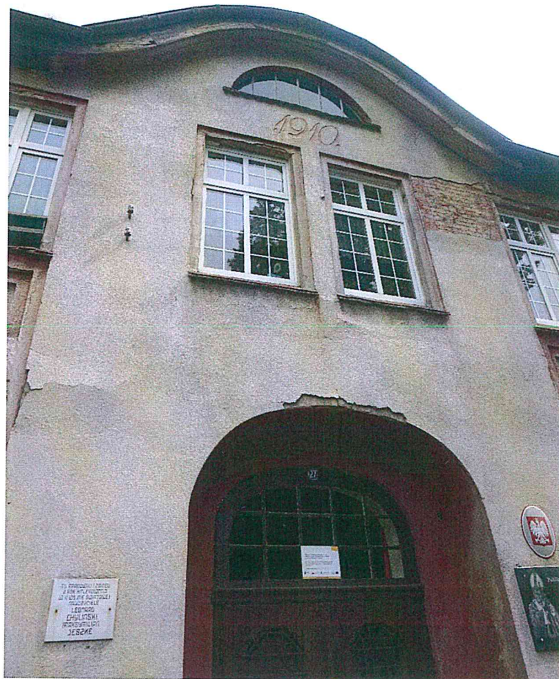
Fotografia 2. Ubytki i odszczepienia tynku na elewacji frontowej (portal główny)
