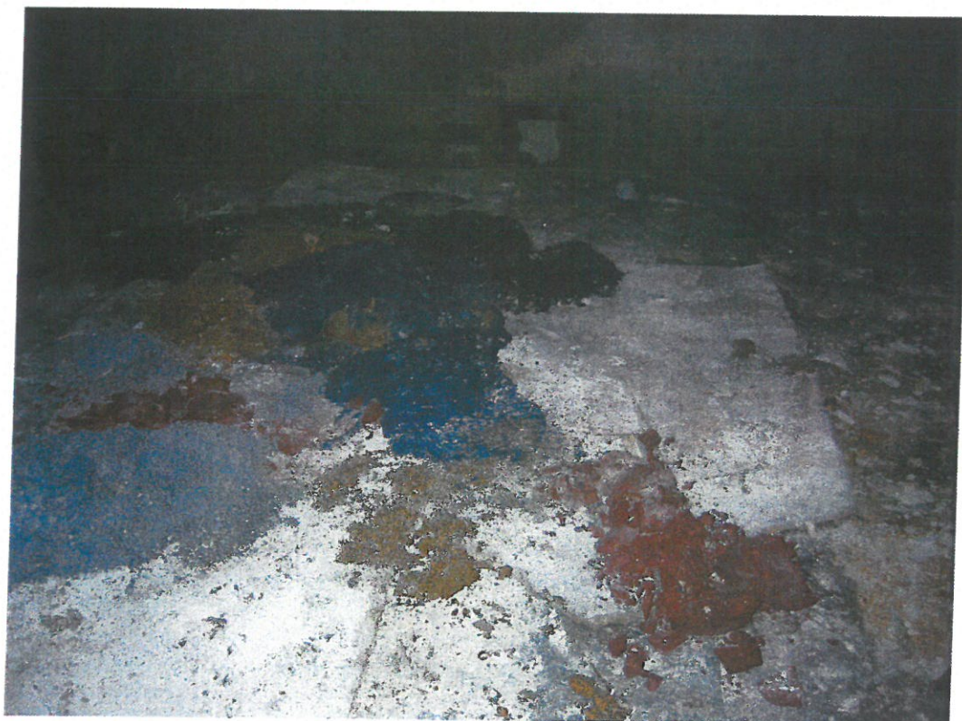
Zdjęcie Nr 10. Farby rozsypane na podłodze piwnicy browaru
