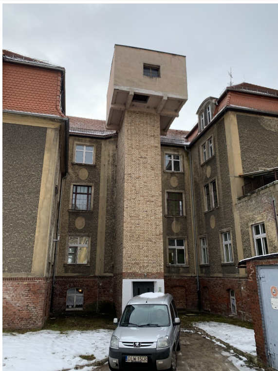
Widok szybu windy zewnętrznej z nadwieszonym nadszybiem
