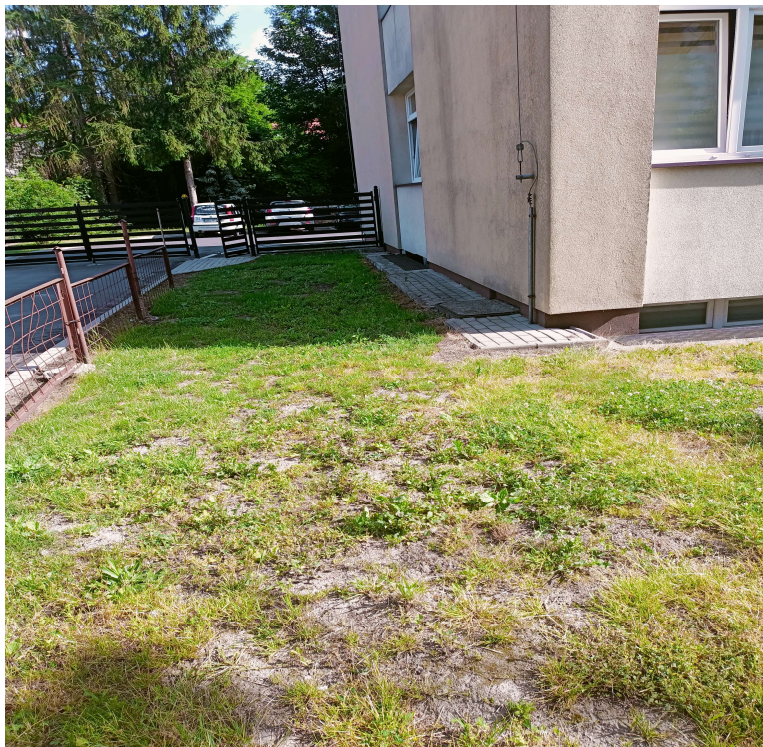
Opaska z kostki Polbruk i betonowa obudowa (naświetle) okna piwnicznego przeznaczone do rozbiórki;
