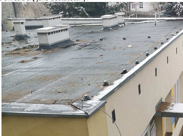
Fot. 5 Widok n stropodach wentylowany
