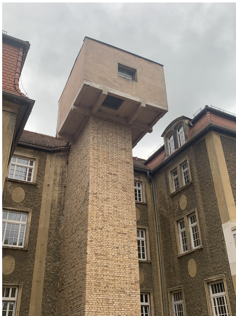
Istniejący szyb windy - część górna z pokazaną maszynownią;
