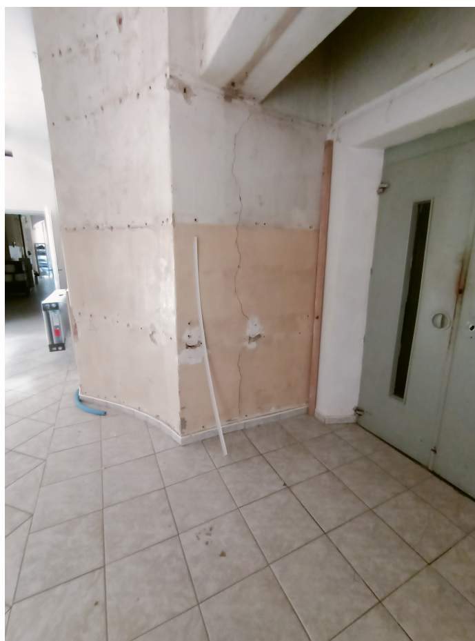
Wewnątrz budynku - widoczne do demontażu - popękane okładziny ścian i okładziny płytek na posadzce do wymiany po robotach rozbiórkowych istniejących drzwi,
