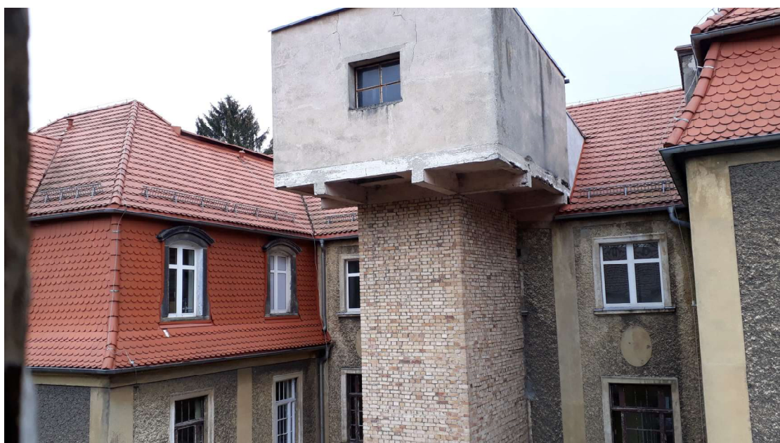
Istniejąca maszynownia windy przeznaczona do rozbiórki - widok z zewnątrz
