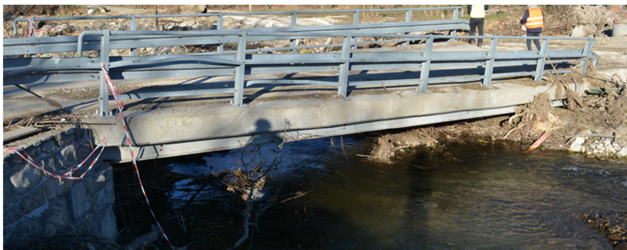
Rys. 1.2 Widok na osiadłą podporę mostu
