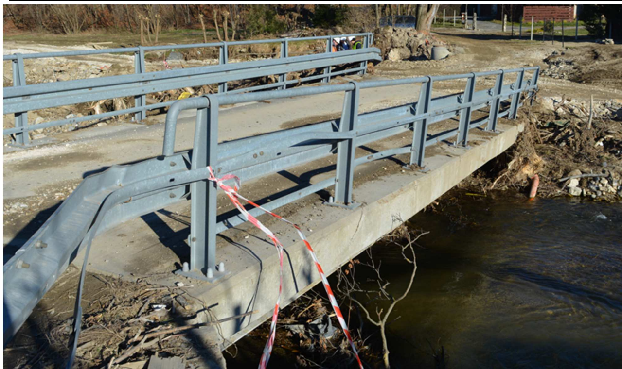
Rys. 3.1 Widok na most i uszkodzony przyczółek
