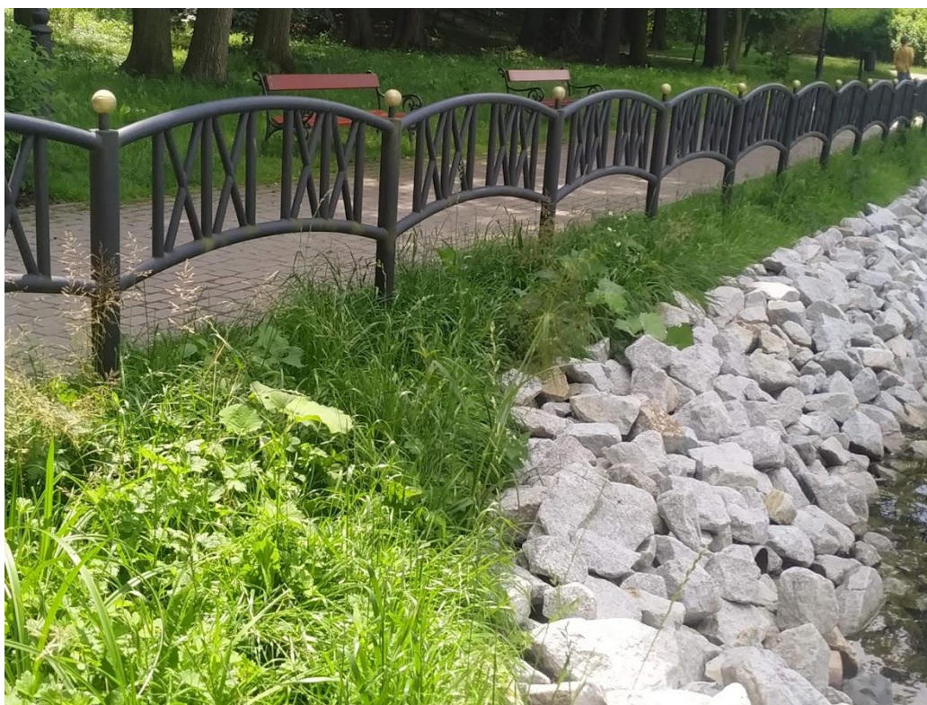
Fot. 6 Pas powyżej narzutu kamiennego do obsadzenia
