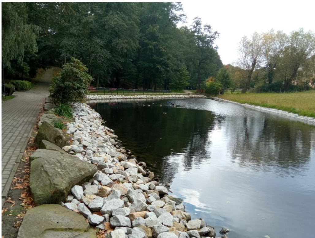
Fot. 3 Umocnienie brzegu – narzut kamienny
