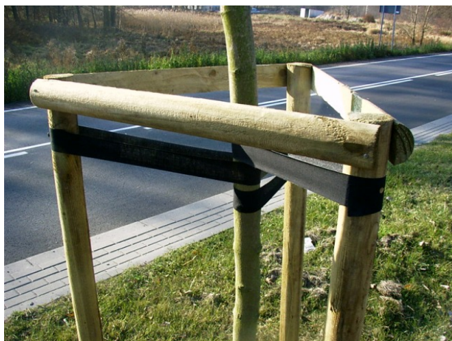
Zdjęcie nr 2. Prawidłowo wykonane mocowanie palików stabilizujących drzewa.
