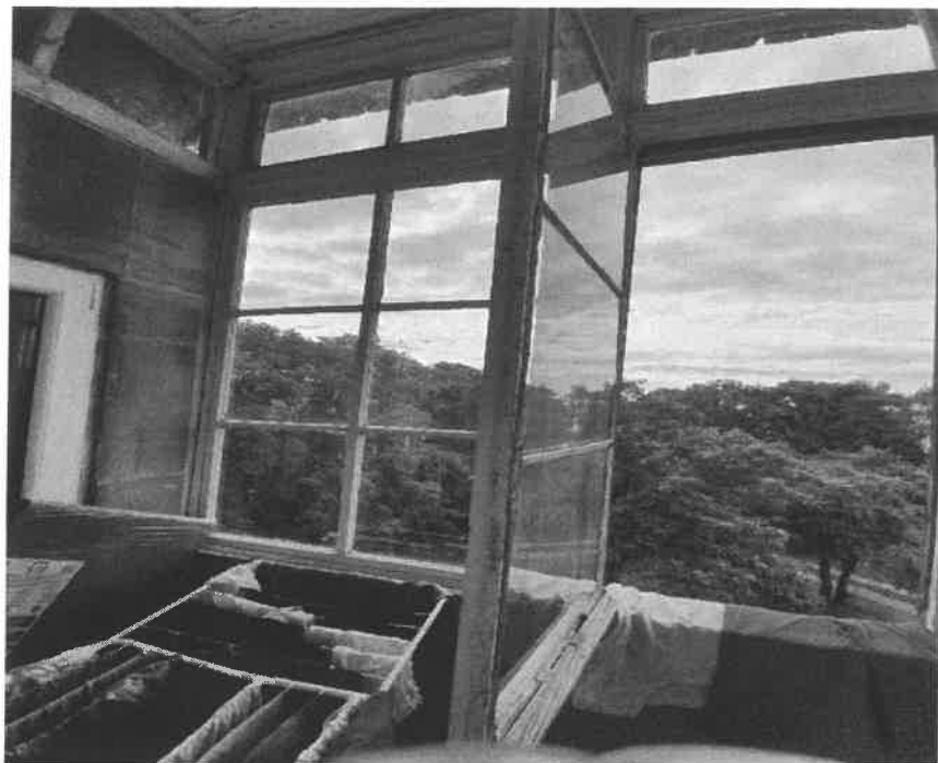
Lokal komunalny przy ul. Dworcowej w Pyrzycach ( zabudowa balkonu)
