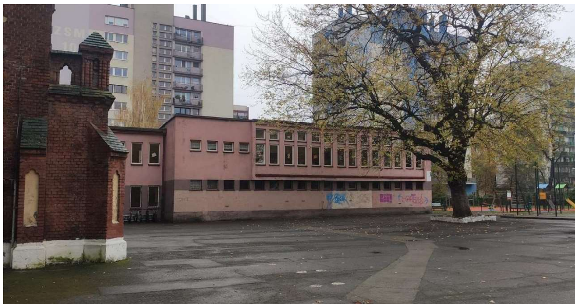
Fot. 2 – Budynek sali gimnastycznej – widok od str. wschodniej.
