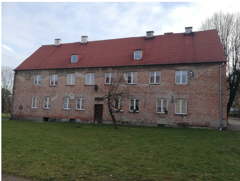
Zdj. nr 1 Widok elewacji zachodniej.
