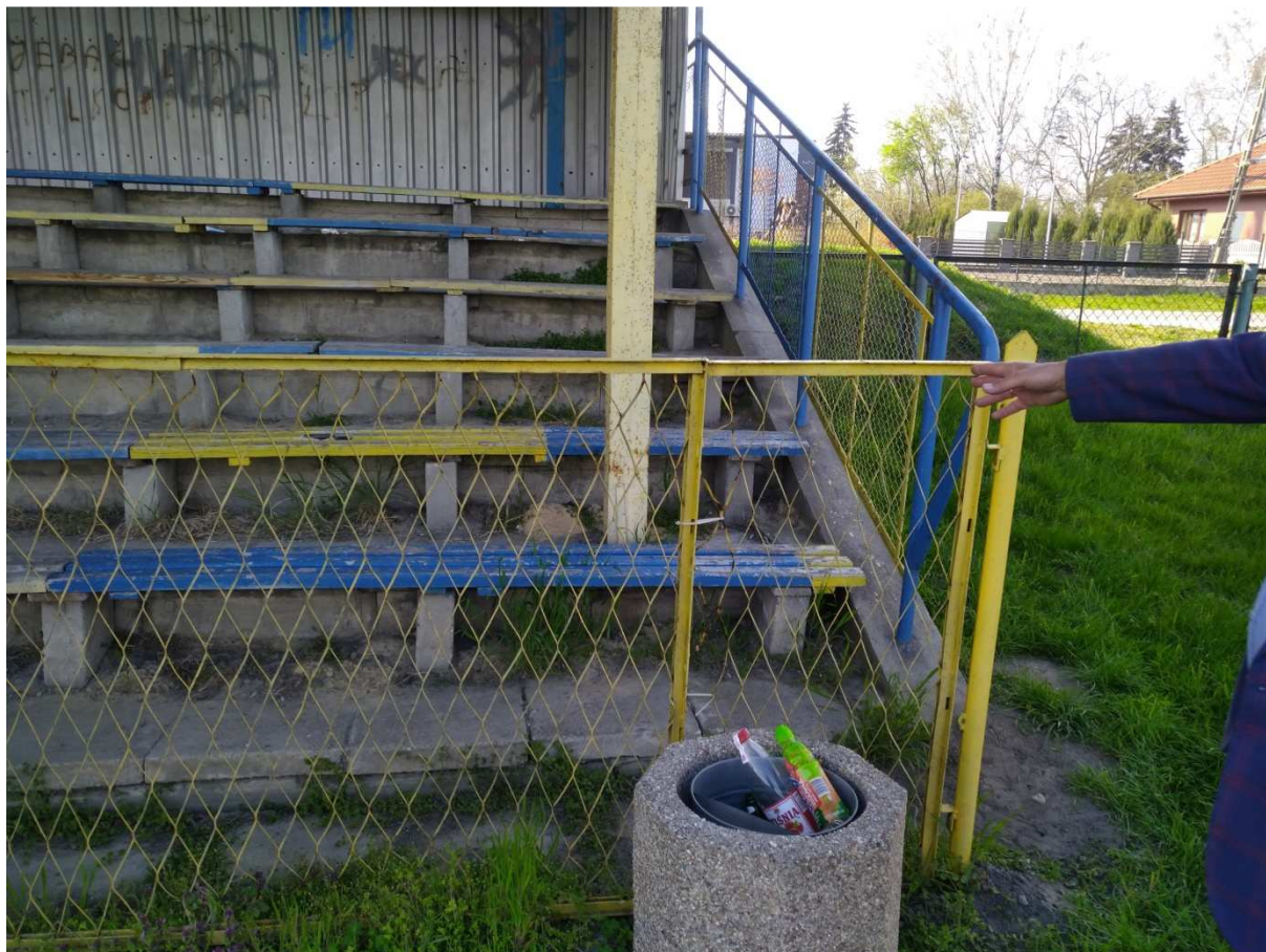
Zdjęcie 3 Istniejące ogrodzenie do demontażu, konstrukcja zadaszzenia do oczyszczenia i malowania.
