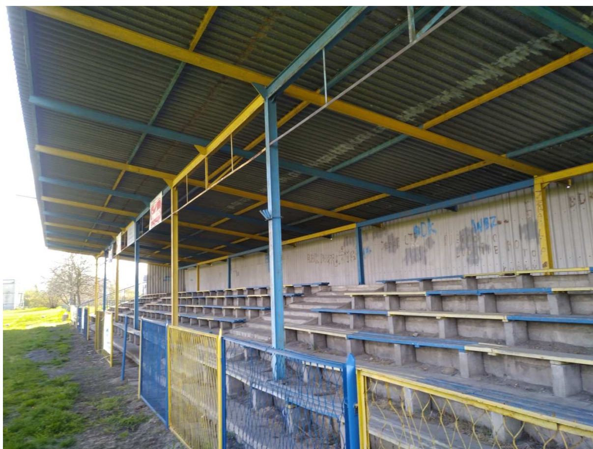
Zdjęcie 4 Konstrukcja do wieszania reklam do demontażu.
