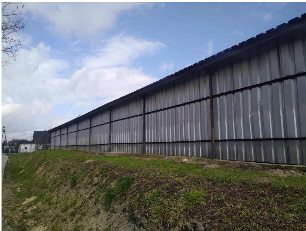
Zdjęcie 1 Skarpa do obłożenia ażurem. Tylna ściana z blachy trapezowej do demontażu.
