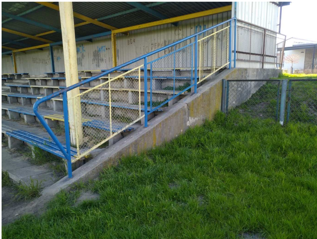
Zdjęcie 5 Murki do obłożenia płytka klinkierową.
