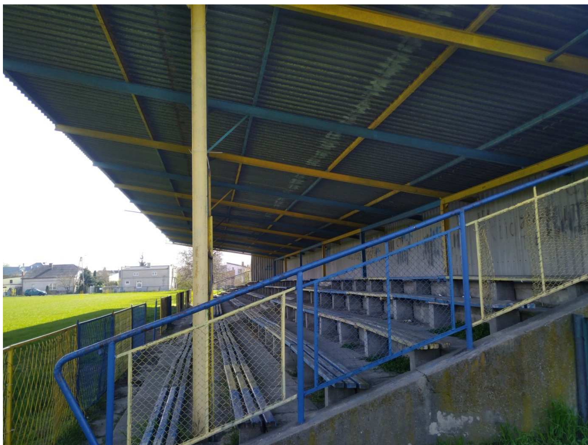
Zdjęcie 6 Pokrycie dachowe do malowania zestawem malarskim do ocynku.
