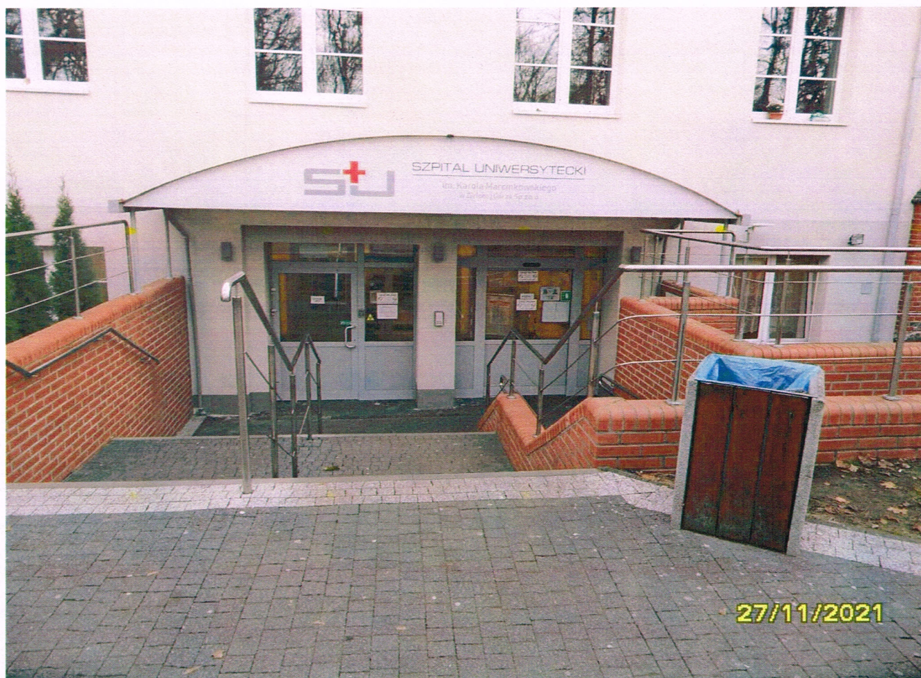
Wejście główne do Szpitala od ul. Wazów.
