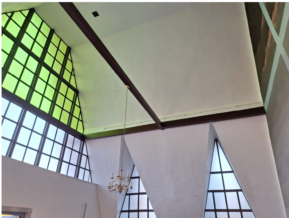
Rys. 8. Kaplica cmentarna – istniejąca konstrukcja stalowa - widok 3
