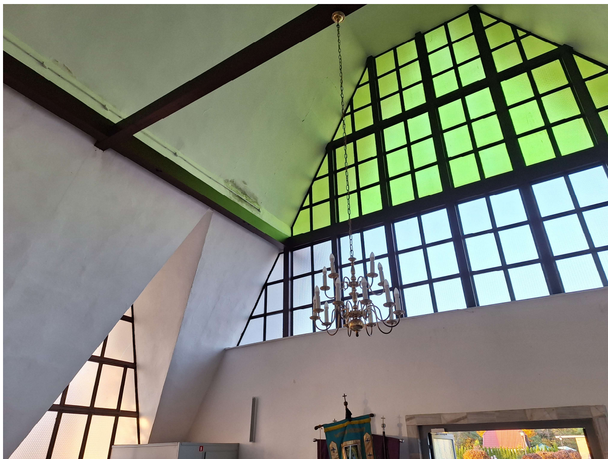
Rys. 6. Kaplica cmentarna – istniejąca konstrukcja stalowa - widok 1
