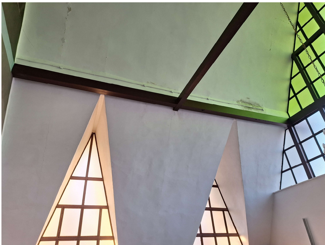
Rys. 7. Kaplica cmentarna – istniejąca konstrukcja stalowa - widok 2
