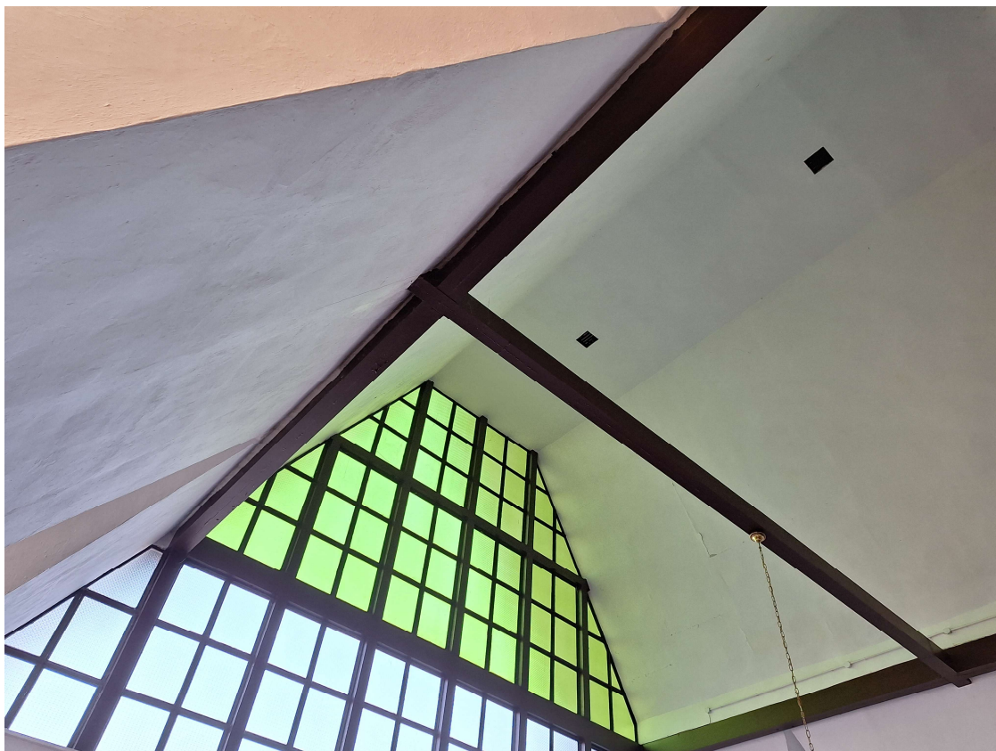
Rys. 9. Kaplica cmentarna – istniejąca konstrukcja stalowa - widok 4
