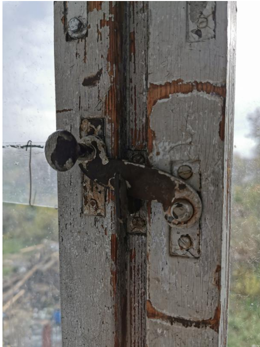
Fot. 18 i 19. Rewers okna - oryginalna zakrętka dźwigniowa i zawias czopowy
