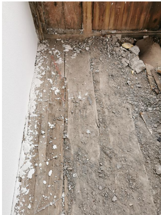
Fot. 17. Wnętrze altany - widoczna na deskach gruba warstwa zalegających zabrudzeń i zachlapania nową warstwą tynku założonego na ścianę w trakcie aktualnego remontu
