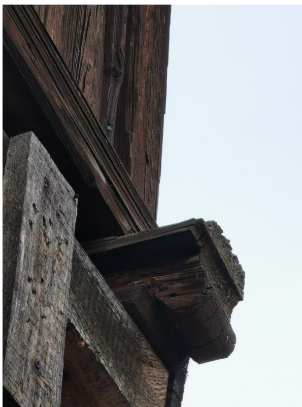
Fot. 6. Profil ozdobnego zakończenia belki stropowej
