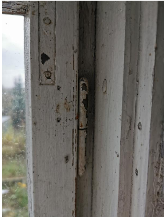
Fot. 18 i 19. Rewers okna - oryginalna zakrętka dźwigniowa i zawias czopowy
