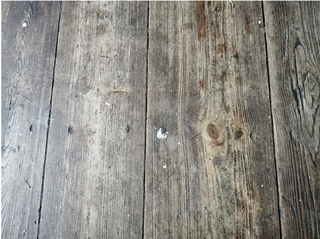
Fot. 21. Deski podłogowe we wnętrzu piętra werandy - dobry stan zachowania drewna
