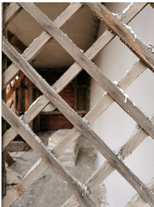
Fot. 9. Fragment kratownicy zdobiącej altanę
