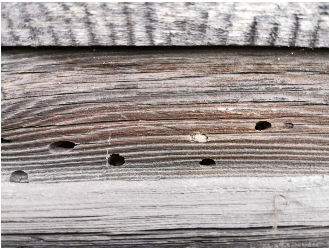
Fot. 15. Zbliżenie na otwory wylotowe spuszczela pospolitego
