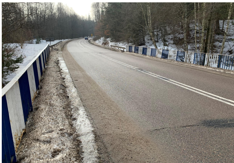
Fot. 5 Widok na jezdnię ubytki, deformacje i zarysowania jezdni w strefie dylatacji oraz na środku obiektu
