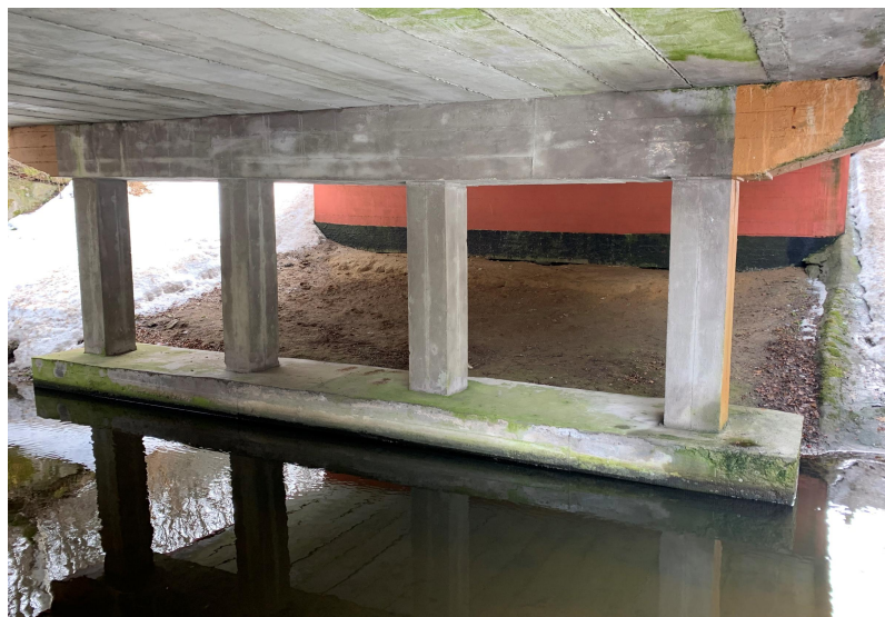
Fot. 12 Widok na filar osady i wykwity na powierzchni odsadzek fundamentów oraz korozja i osady na oczepie
