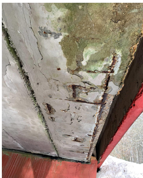
Fot. 8 Widok na ustrój nośny ubytki, przecieki i osady na powierzchni betonu oraz korozja stali zbrojeniowej
