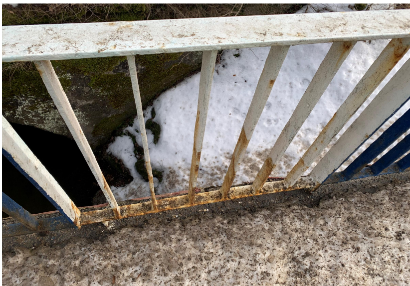
Fot. 6 Widok na fragment balustrady widoczna korozja/ zniszczenie zabezpieczeń antykorozyjnych
