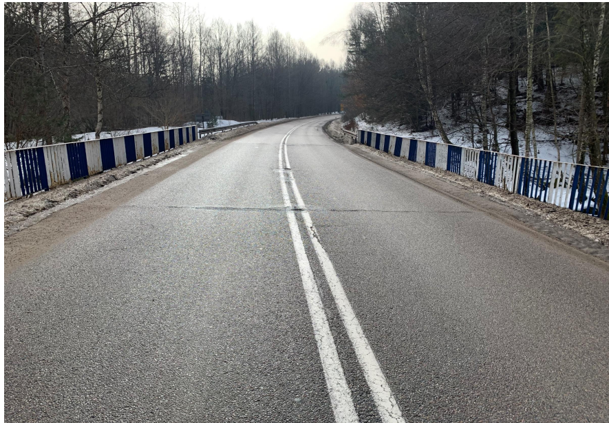
Fot. 9 Widok na jezdnię deformacje, pęknięcia, ubytki i zarysowania nawierzchni w strefie dylatacji
