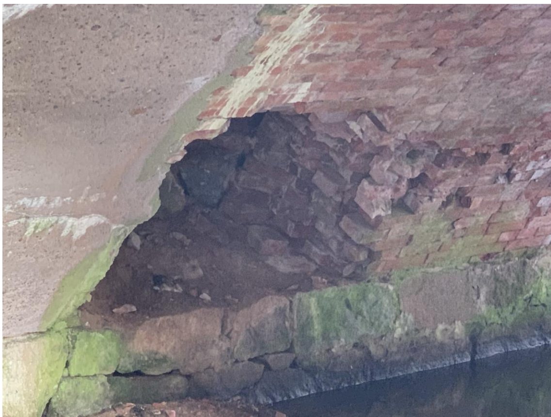
Fot.6 Uszkodzenie sklepienia w strefie węzłowania, obiektu zlokalizowanego obok istniejącego mostu w ciągu DW 209
