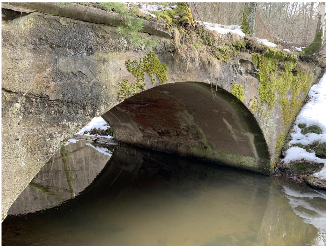
Fot.6 Uszkodzenie sklepienia w strefie węzłowania, obiektu zlokalizowanego obok istniejącego mostu w ciągu DW 209
