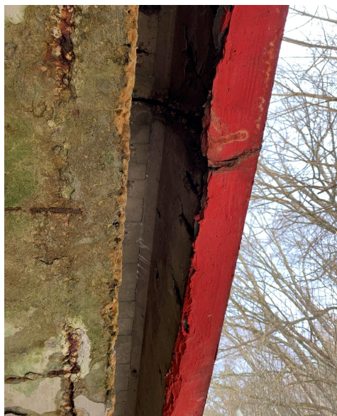
Fot. 11 Widok na wspornik poschodnikowy korozja i zarysowania betonu
