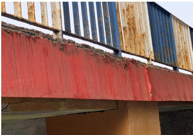
Fot. 7 Widok na gzyms korozja, zanieczyszczenia oraz spękania betonu
