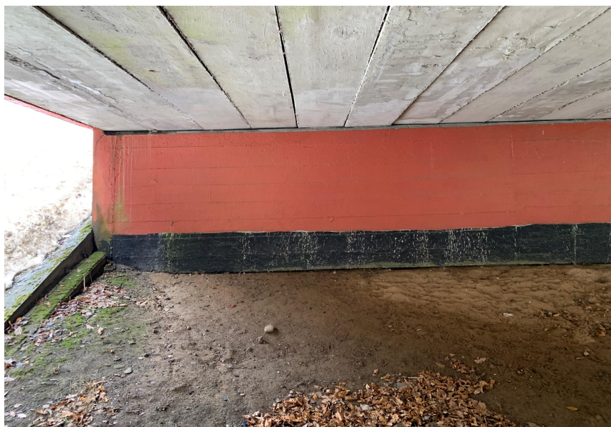
Fot. 10 Widok na przyczółek odzacieki i osady na powierzchni czołowej przyczółka
