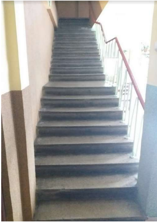
Wnętrze- schody wewnętrzne
