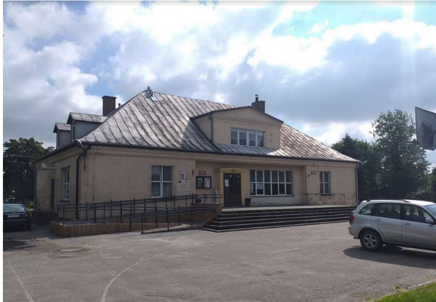
Elewacja budynku- widok od południa
