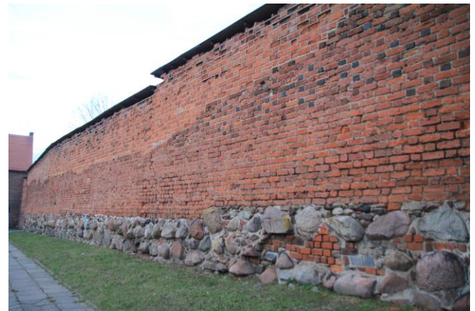
Podmurówka kamienna, muru na fragmentach zewnętrznym i wewnętrznym odcinka południowo – wschodniego. Przykład zróżnicowania budowy lica po pracach naprawczych.
