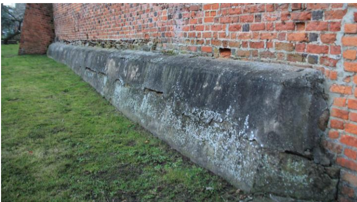
Podmurówka kamienna pod warstwą wzmocnienia cementowego Przykład zróżnicowania materiału kamiennego.
