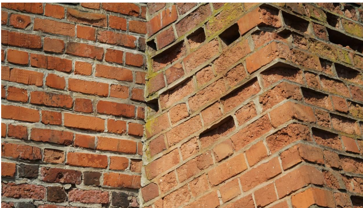
Różnice stanu zachowania lica na przykładzie fragmentu muru i przypory na odcinku południowo-wschodnim.
