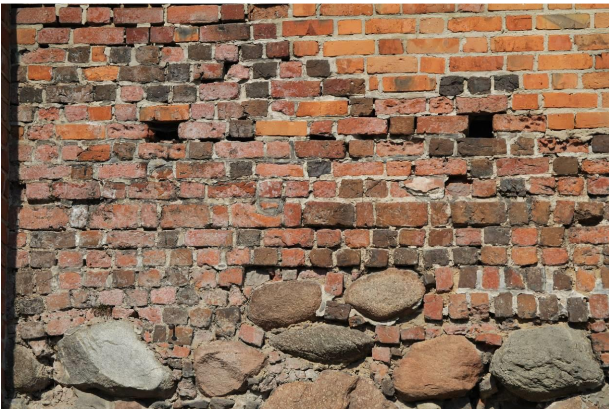
Zróznicowany układ cegieł lica.
