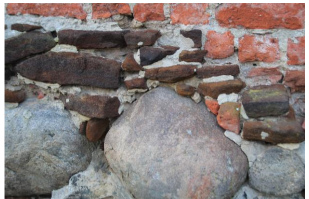
Podmurówka kamienna pod warstwą wzmocnienia cementowego Przykład zróżnicowania materiału kamiennego.
