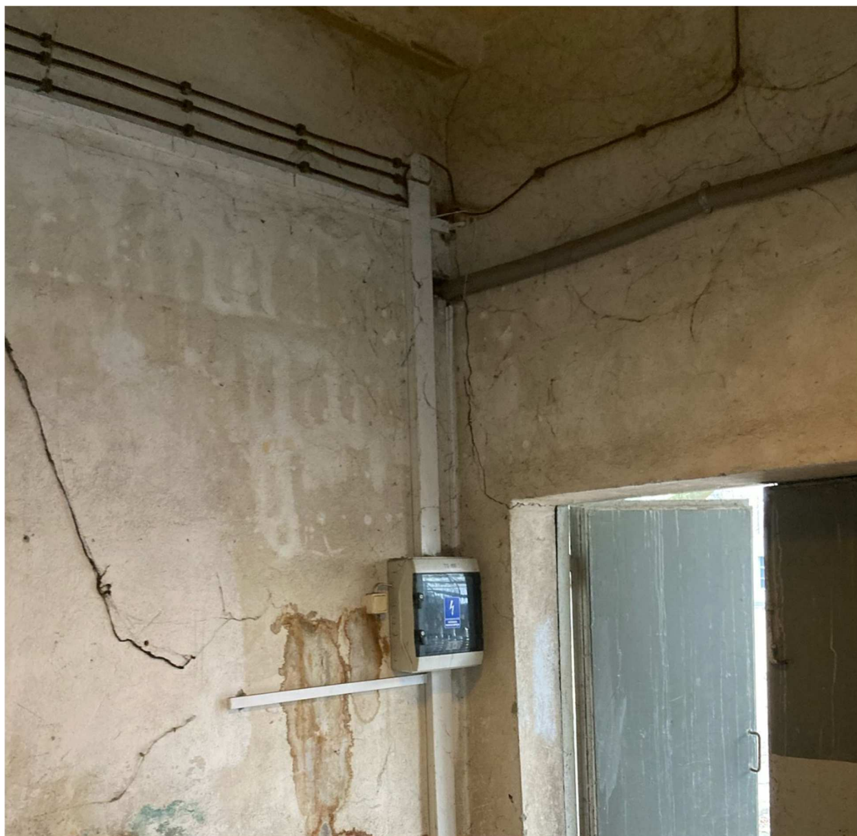
Zdjecie.3. Zarysowania ścian zewnętrznych (inventaryzacja fotograficzna)
