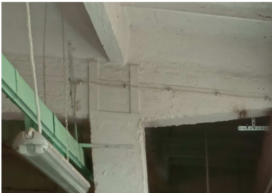
Rys.4. Oparcie rygla na słupie (inwentaryzacja fotograficzna)
