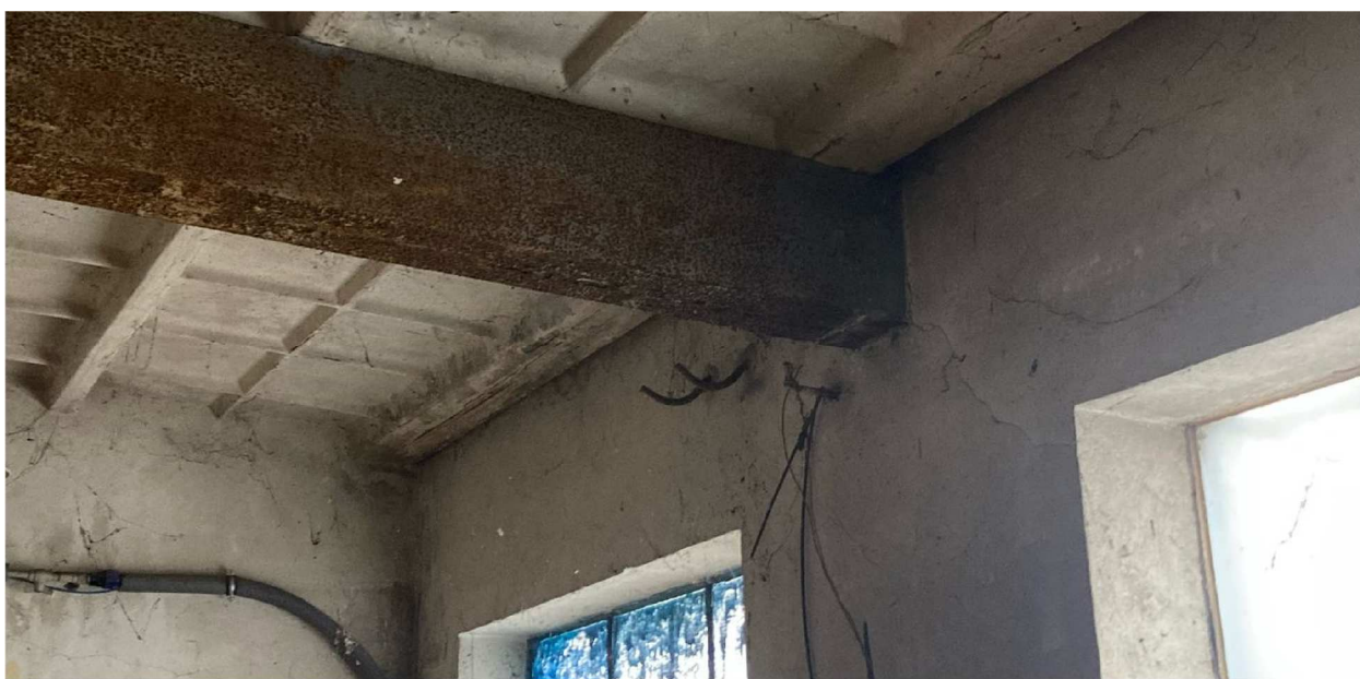
Zdjęcie 2. Oparcie stalowej belki nośnej dachu na ścianie zewnętrznej (inwentaryzacja fotograficzna)
