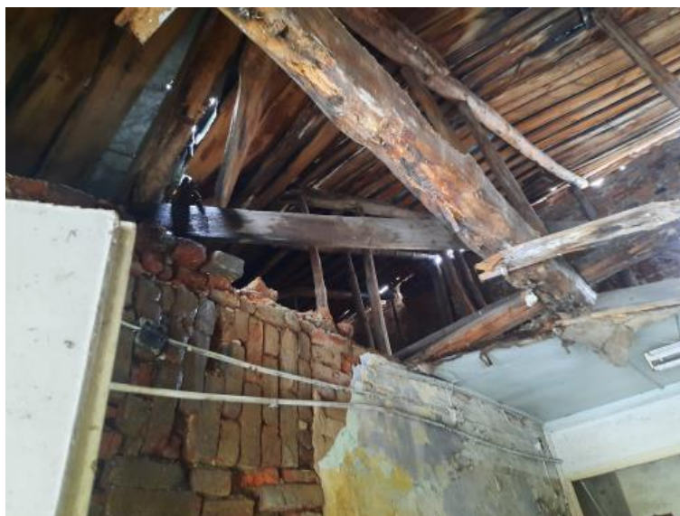
Uszkodzona konstrukcja dachu, zawalona podsufitka
