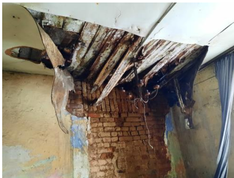
Uszkodzona podsufitka w pomieszczeniu
