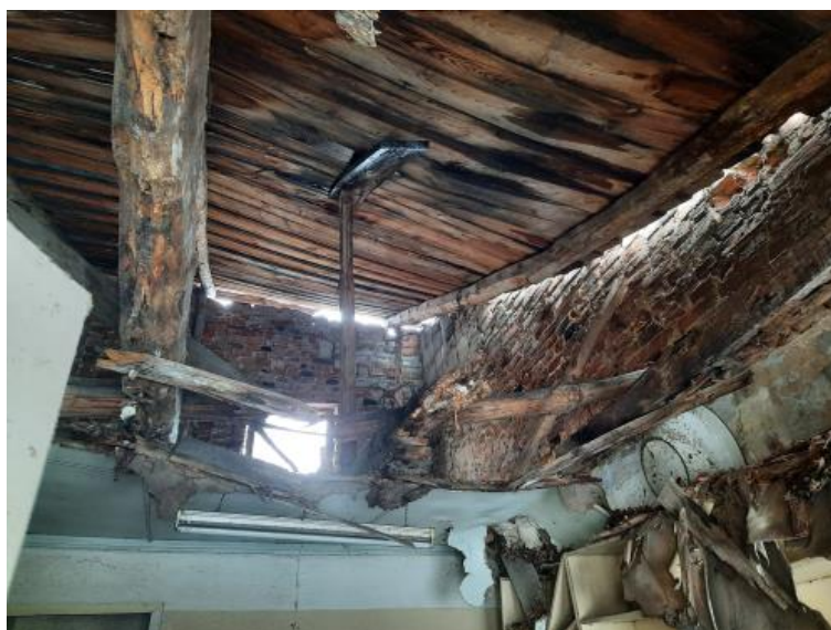
Uszkodzona konstrukcja dachu
