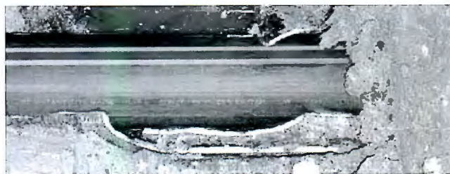
Rura ROBUST układana metodą bursting
