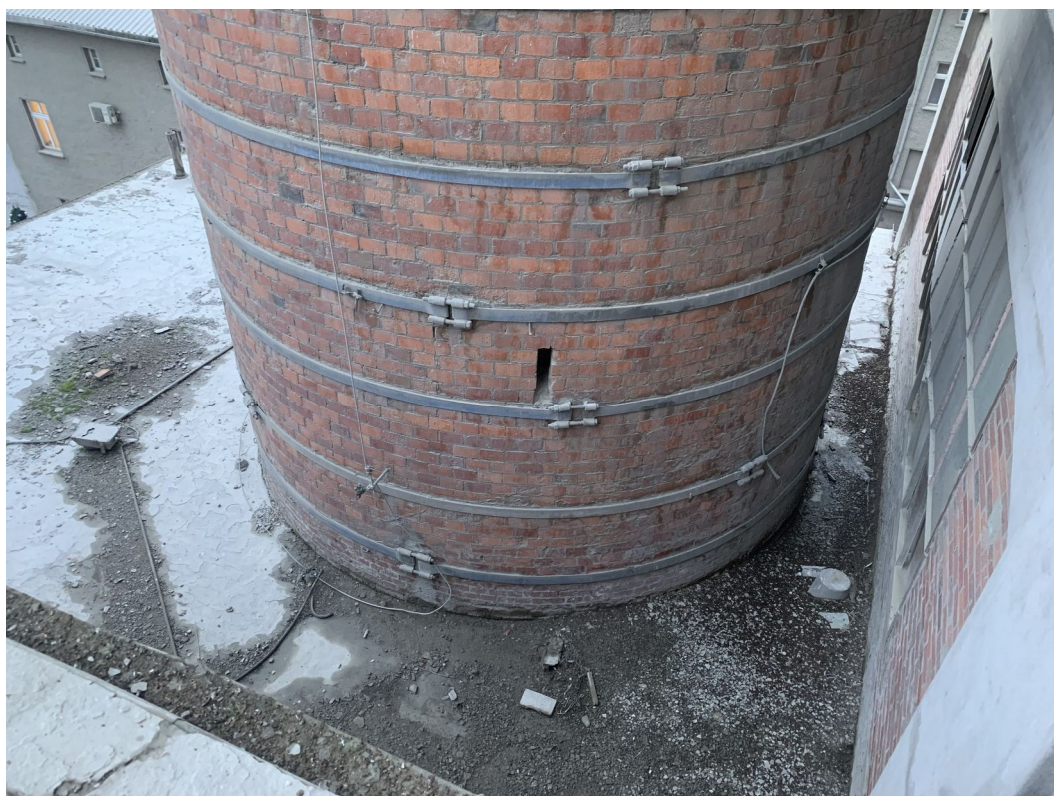
Fot. 4. Strefa komina ponad dachem hali
