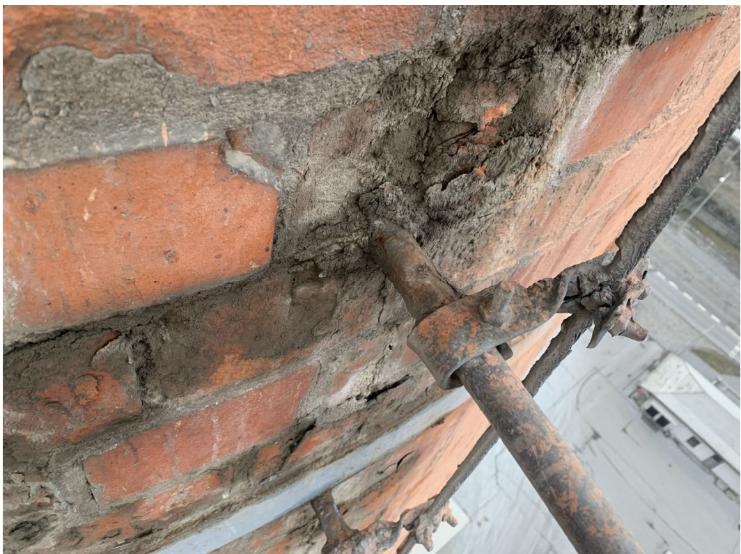
Fot. 9. Górna część komina – miejsca silnej degradacji muru, pocienienie przekroju szczebli
