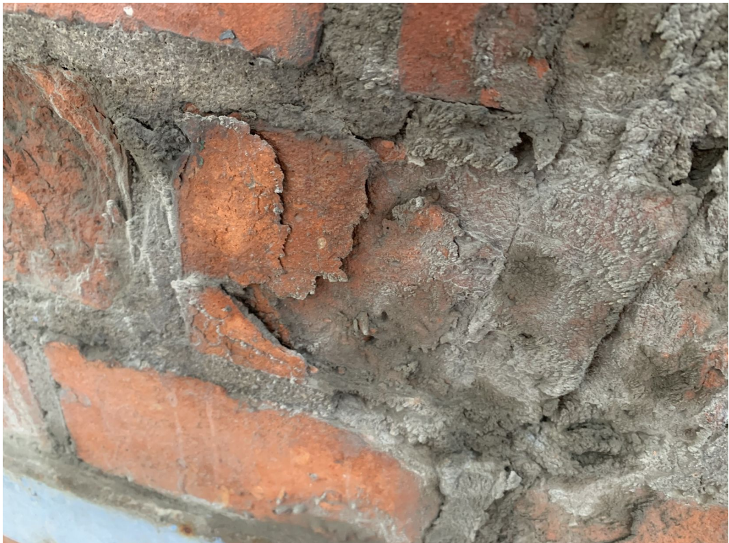
Fot. 11. Szczytowa część trzonu ceramicznego – uszkodzenia korozyjne cegieł, złuszczenia warstwowe
