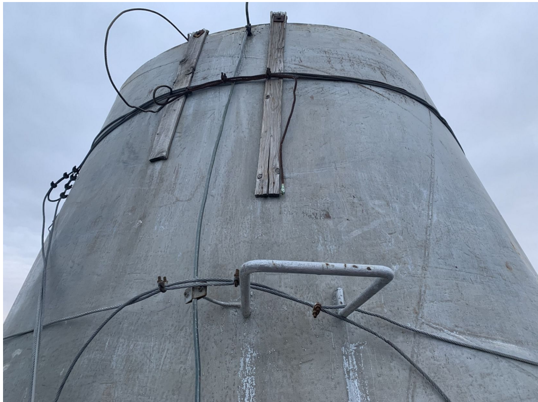
Fot. 6. Zwężka stalowa – bez uszkodzeń
