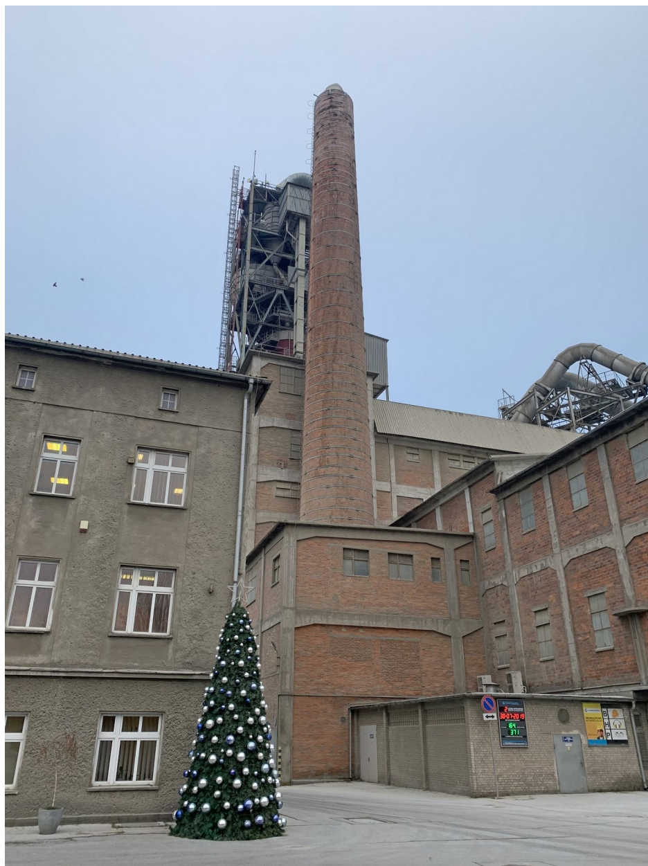
Fot. 1. Widok ogólny komina
