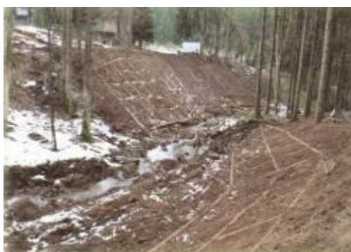
Nadleśnictwo Międzylesie – kratownica na brzegach potoku Nowinka w Leśnictwie Nowa Wieś
