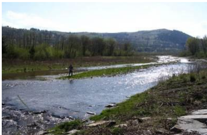
Fot. 1. Odtwarzająca się łacha korytowa powyżej bystrza o zwiększonej szorstkości (Koncepcja 2008)
