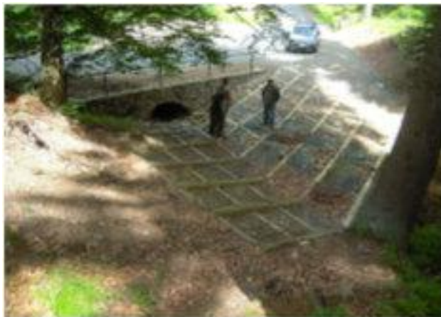
Kratownica drewniana poniżej przepustu pod drogą gminną – kratownica pełni rolę ubezpieczenia wypadu i jednocześnie brodu umożliwiającego wjazd droga leśna pod górę – Nadleśnictwo Zdroje fot. R.Majewicz
