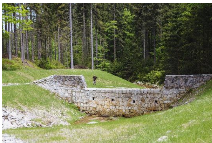
Zapora przeciwrumowiskowa w Nadleśnictwie Łądek Zdrój z oczyszczoną w ramach projektu retencji górskiej niecką (min. funkcja przeciwpowodziowa) i dobudowaną przeplawką. Zapora przerywa ciągłość transportu rumowiska - należy monitorować potrzebę alimentacji rumoszu poniżej zapor. Źródło: Archiwum CKPŚ.
