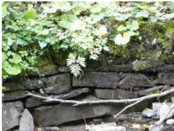
Murki kamienne bez zaprawy w N-ctwie Łądek Zdrój (góra) i Węgierska Górka (po prawej) (fot. M. Goździk)
