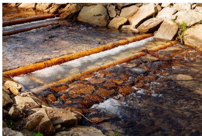
Kaskada bardzo niskich progów łatwa do pokonania dla organizmów wodnych, z basenami poniżej progu podpartymi gurtem doskonale zabezpieczonym narzutem kamiennym i belkami podłużnymi. Zwraca uwagę dobre zakotwienie belek w brzegach. Niestety brak przelewów na małą wodę. Źródło: Archiwum CKPŚ.
