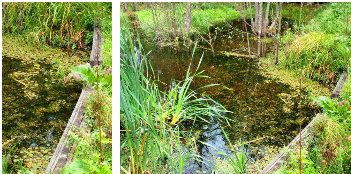
Nawet małe zastawki ulegają naporowi wody jeśli pozbawione są wzmocnień zastrzałem, oczepem i podparciem od dołu umocnieniem. Fot. Z. Filippek Źródło: Archiwum CKPS
