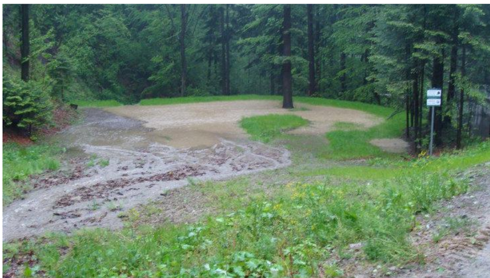
Zbiornik retencyjny na pływ powierzchniowy zaraz po wybudowaniu, dodatkowo zasilany wodą spływającą z leśnej drogi – Nadleśnictwo Piwniczna. Źródło: zasoby własne Nadleśnictwa Piwniczna
