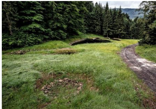
Doły chłonne i kałuże przejmujące wodę odprowadzaną rowkami z drogi. Warto zwrócić uwagę, że sytuacja terenowa położenia drogi względem cieku bardzo sprzyja odprowadzeniu wody z drogi wodospustami i dolotami także do zbiorników widocznych poniżej. Źródło: Archiwum CKPŚ.
