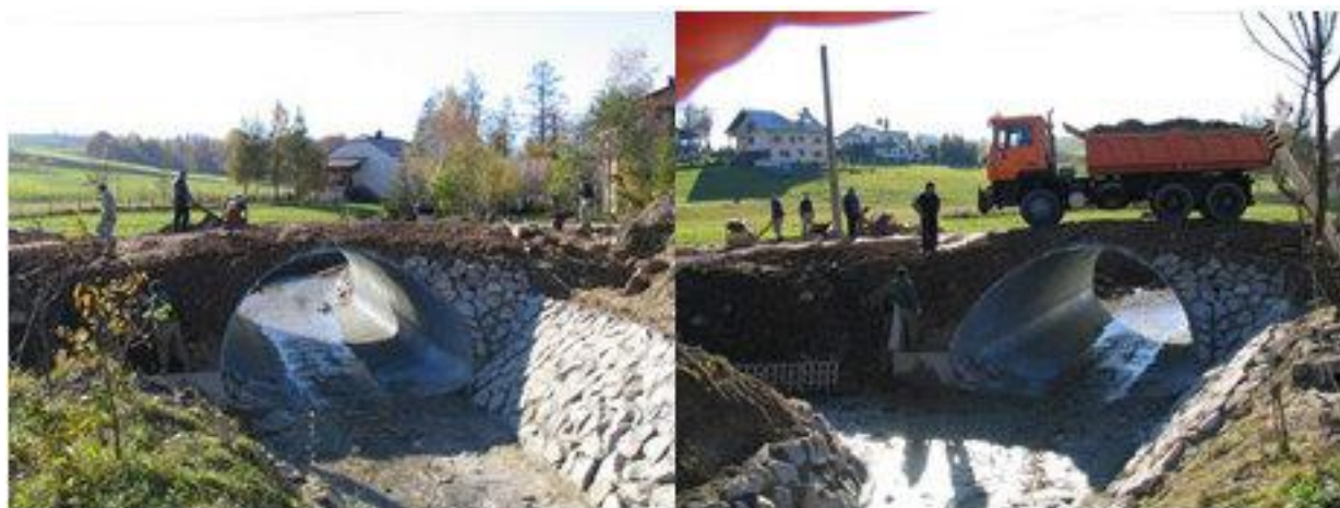
Przykłady adaptacji przepustów do zmian klimatu.
