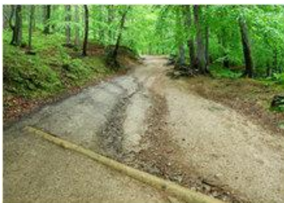
Wodospust z pojedynczego okrągłaka
