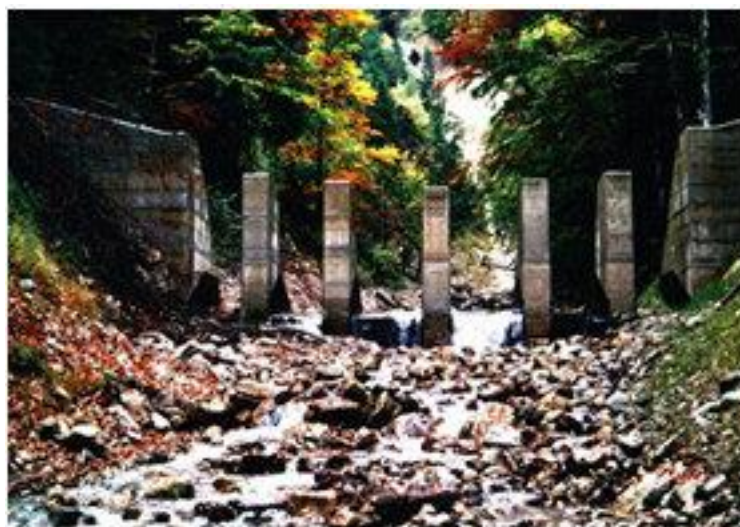
Zmodernizowana zapora szczelinowa (Austria)
