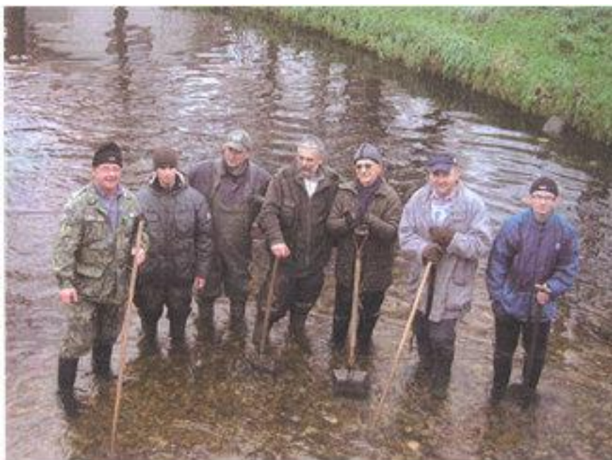
Ręczne wsypywanie materiału żwirowo kamennego w dno uregulowanego cieku o zaburzonej morfologii. Źródło: J.Nyk, J.Domagała „Sztuczne tarliska dla ryb...” w „Użytkownik rybacki nowa rzeczywistość” Spała 2008 r.
