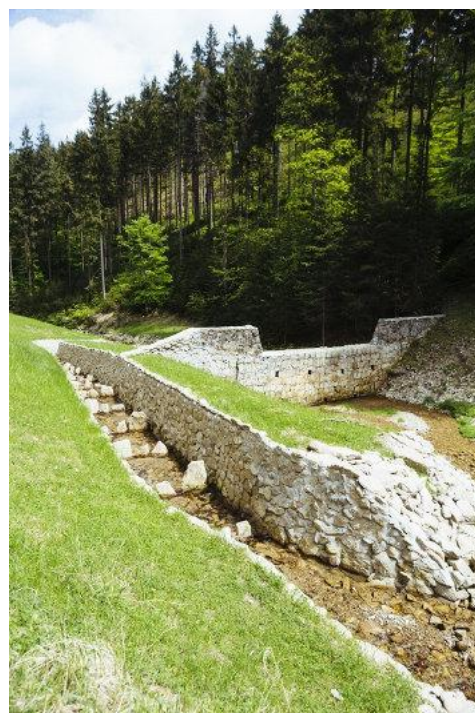
Zapora przeciwrumowiskowa w Nadleśnictwie Łądek Zdrój z oczyszczoną w ramach projektu retencji górskiej niecką (min. funkcja przeciwpowodziowa) i dobudowaną przeplawką. Zapora przerywa ciągłość transportu rumowiska - należy monitorować potrzebę alimentacji rumoszu poniżej zapor. Źródło: Archiwum CKPŚ.
