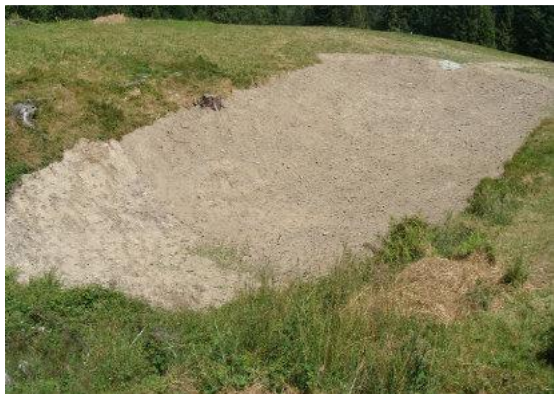
Miejsca na mikrozbiorniki wykopane na zboczach górskich zasilane spływem powierzchniowym przygotowane w Nadleśnictwie Piwniczna – Źródło: Archiwum CKPŚ.
