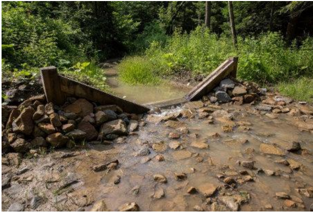
Próg powyżej brodu ukierunkowujący wodę na bród.
