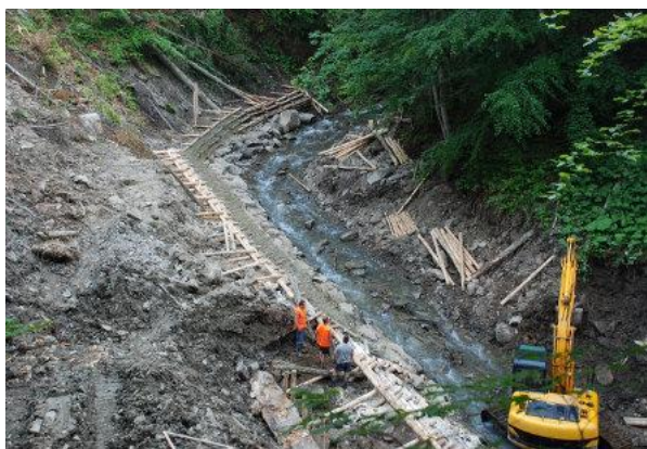
Budowa największej kaszycy w projekcie retencji górskiej – zwraca uwagę solidne ubezpieczenie podstawy kaszycy głazami – Nadleśnictwo Stuposiany Źródło: Archiwum CKPŚ.
