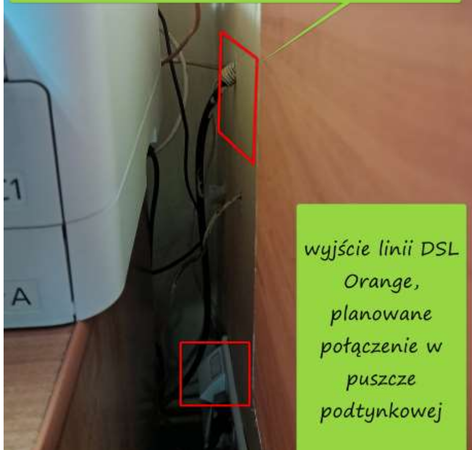
Rysunek 3 - miejsca połączeń instalacji
