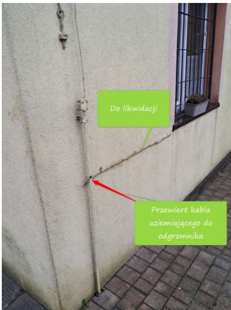
Rysunek 4 - kabel uziemiający do odgromnika
