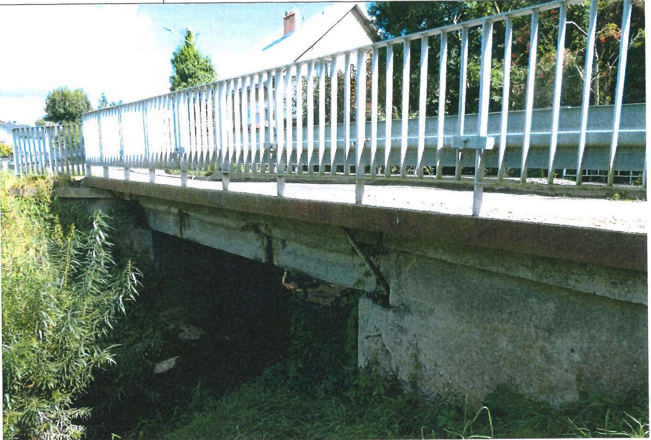
Fot. 1. Widok na obiekt
