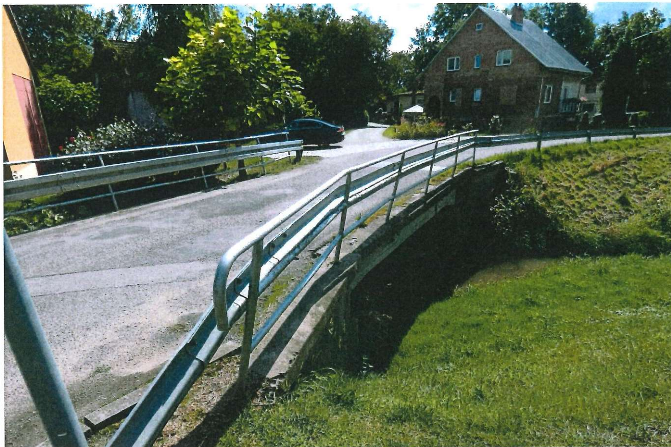
Fot. 1. Widok na obiekt
