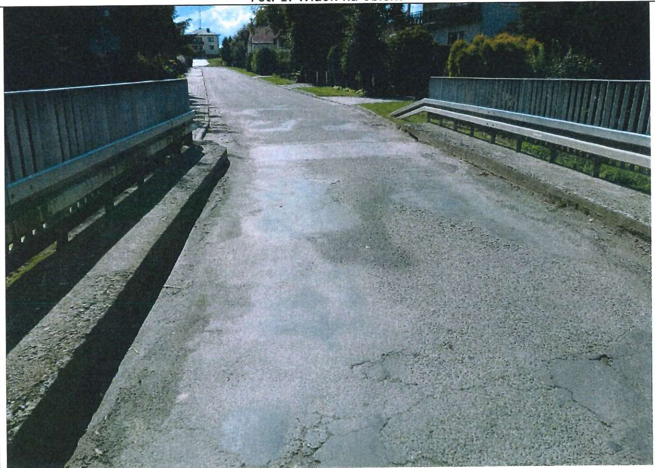
Fot. 2. Widok na nawierzchnię jezdni na obiekcie
