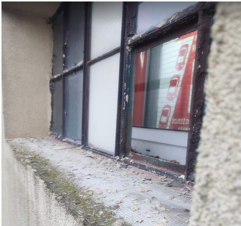
Rysunek 6 - Krata okienna do demontażu
