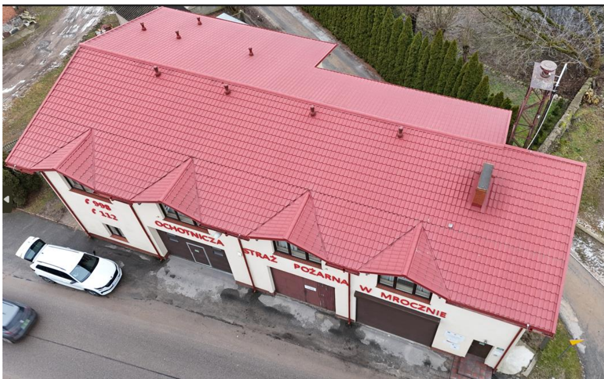
Rysunek 4 - Widoczne kominki i komin wentylacyjny
