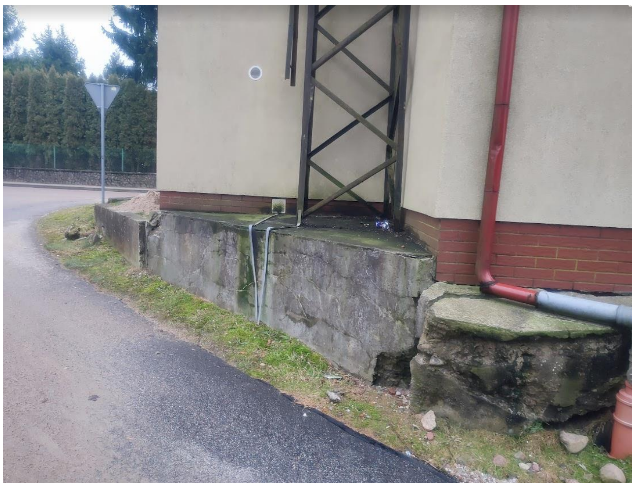
Rysunek 7 - Istniejący mur oporowy i utwardzenie
