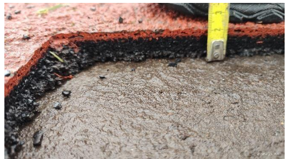
Ryc. 6 Widok na odkrywkę nawierzchni bieżni
