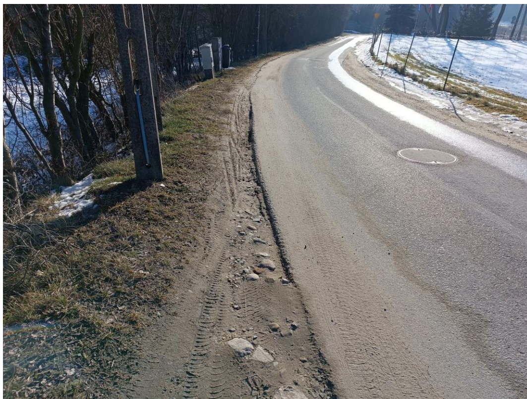
Fot: Istniejąca nawierzchnia bitumiczna ( koleina na poboczu)
