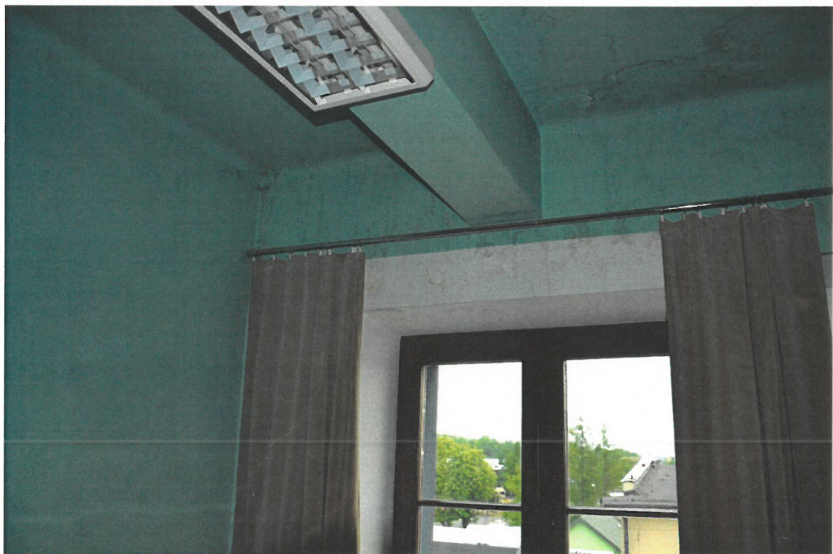
Zdj.28 Zalany sufit pomieszczenia studia nagrań
