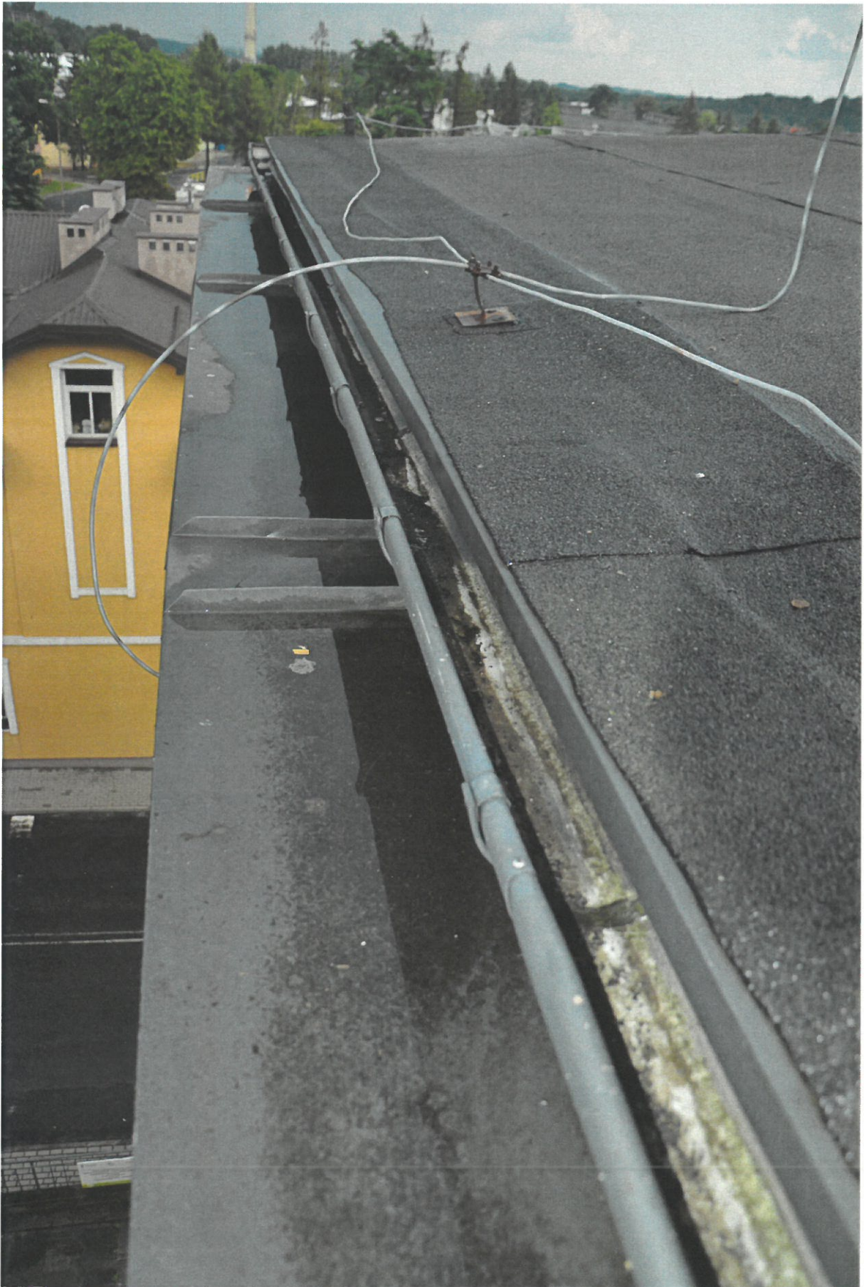
Zdj.20 Widok na obróbki od strony ul. Michałusa
