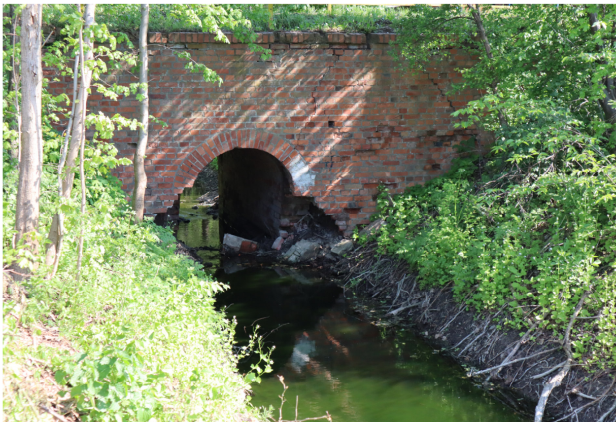
Fot. 8 Widok na wlot – widoczne pęknięcia ścian bocznych oraz uszkodzenie części przelotowej.
