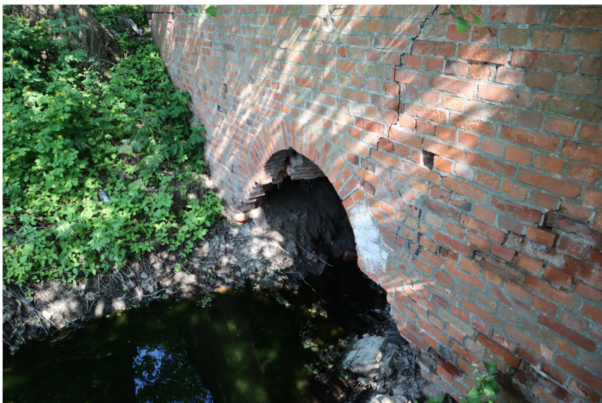
Fot. 7 Widok na wlot – praktycznie brak konstrukcji części przelotowej
