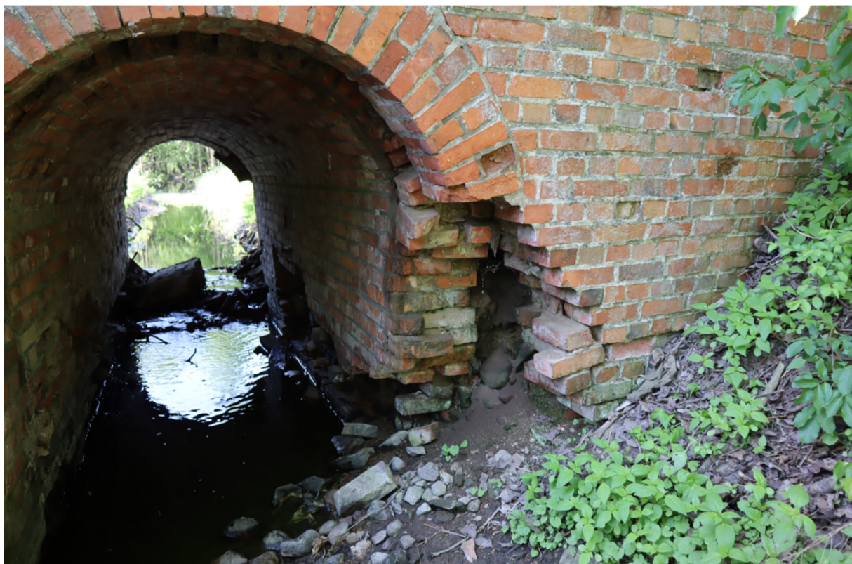
Fot.4 Widok części przelotowej od strony wylotu – widoczne uszkodzenie ściany pionowej (ściana „wisi w powietrzu”).
