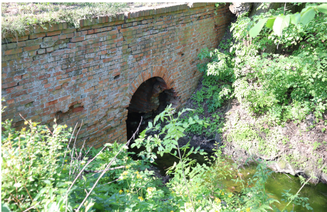
Fot. 1 Widok ściany oporowej od strony wylotu przepustu – widoczne liczne ubytki cegieł oraz pęknięcia całej ściany.
