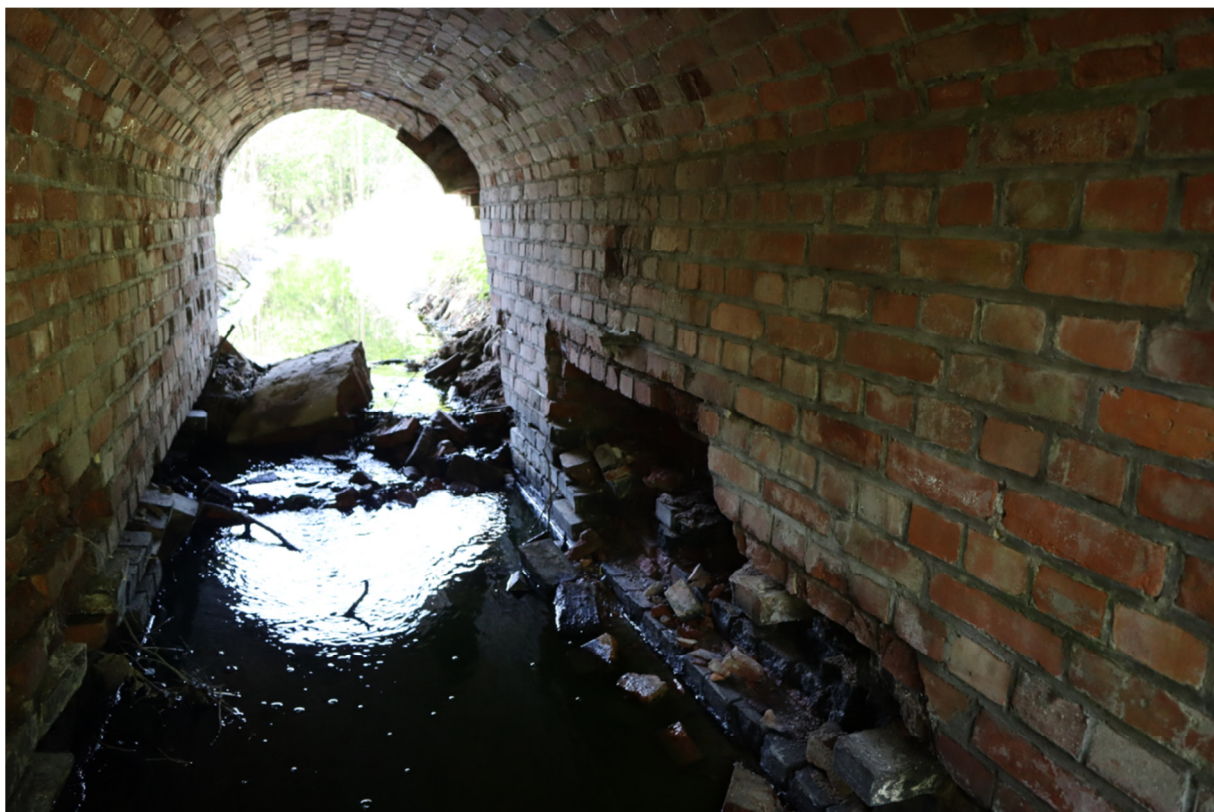
Fot. 6 Część przelotowa przepustu – widoczne liczne uszkodzenia ścian pionowych.
