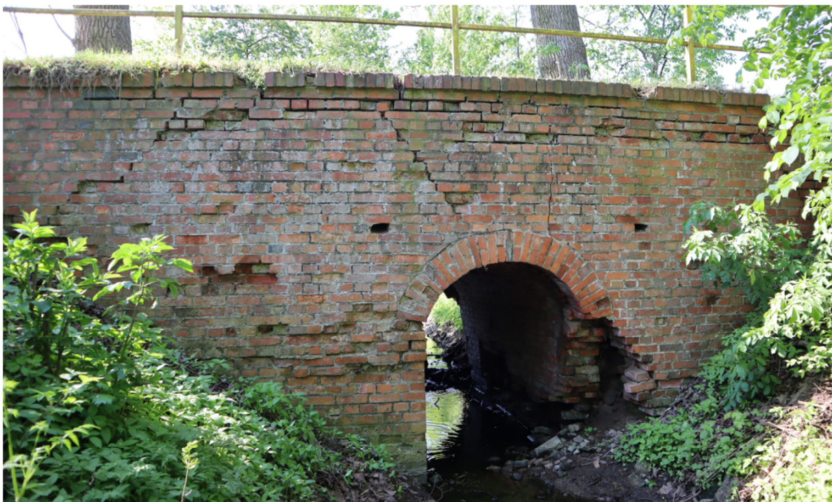
Fot. 3 Widok od strony wylotowej przepustu – widoczny stan awaryjny ścian bocznych oraz części przelotowej przepustu.
