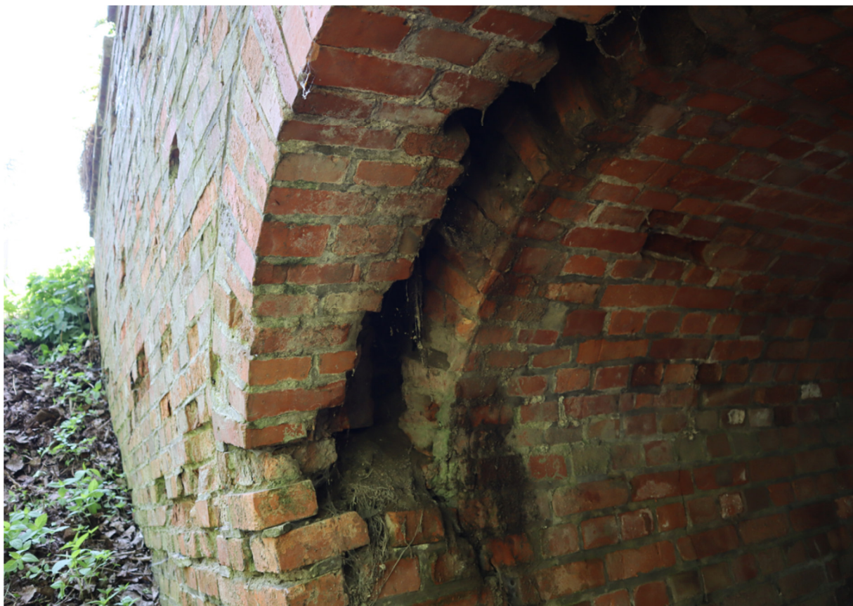
Fot.5 Widoczne odspojenie ściany bocznej od części przelotowej przepustu na wylocie.
