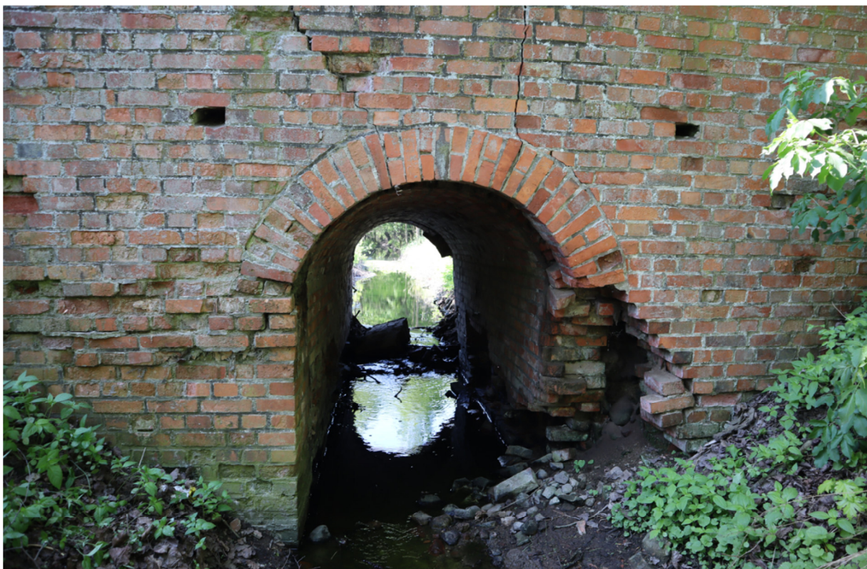
Fot. 2 Widok od strony wylotowej przepustu – widoczne uszkodzenie części przelotowej przepustu na połączeniu z ścianą boczną, widoczne pionowe pęknięcia ścian bocznych oraz przemieszczenia cegieł.
