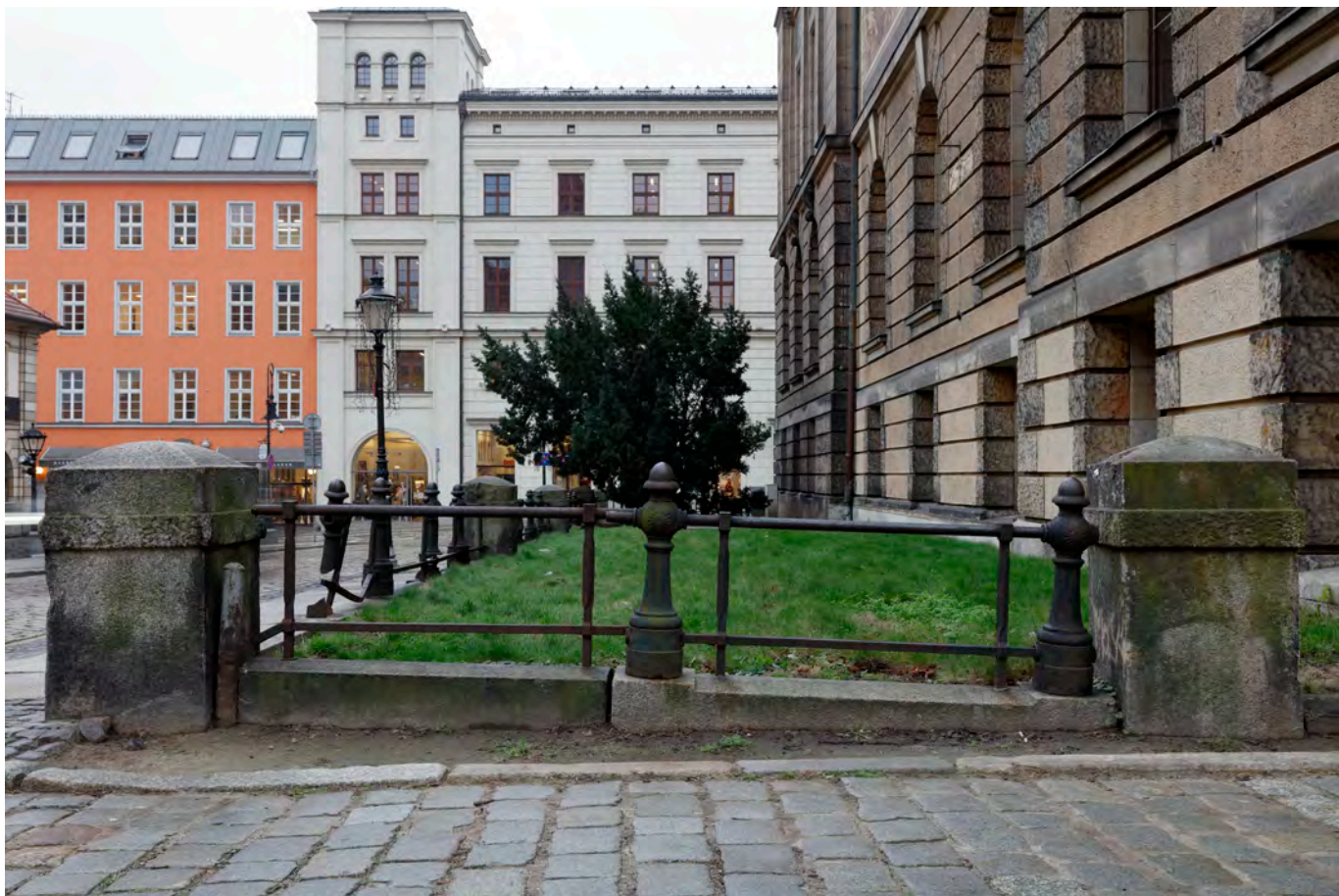
Ilu. 52. Muzeum Narodowe w Poznaniu, fragment ogrodzenia od strony pn.-wsch. Bardzo zły stan zachowania części metalowej i kamiennej ogrodzenia z licznymi przemieszczeniami.
