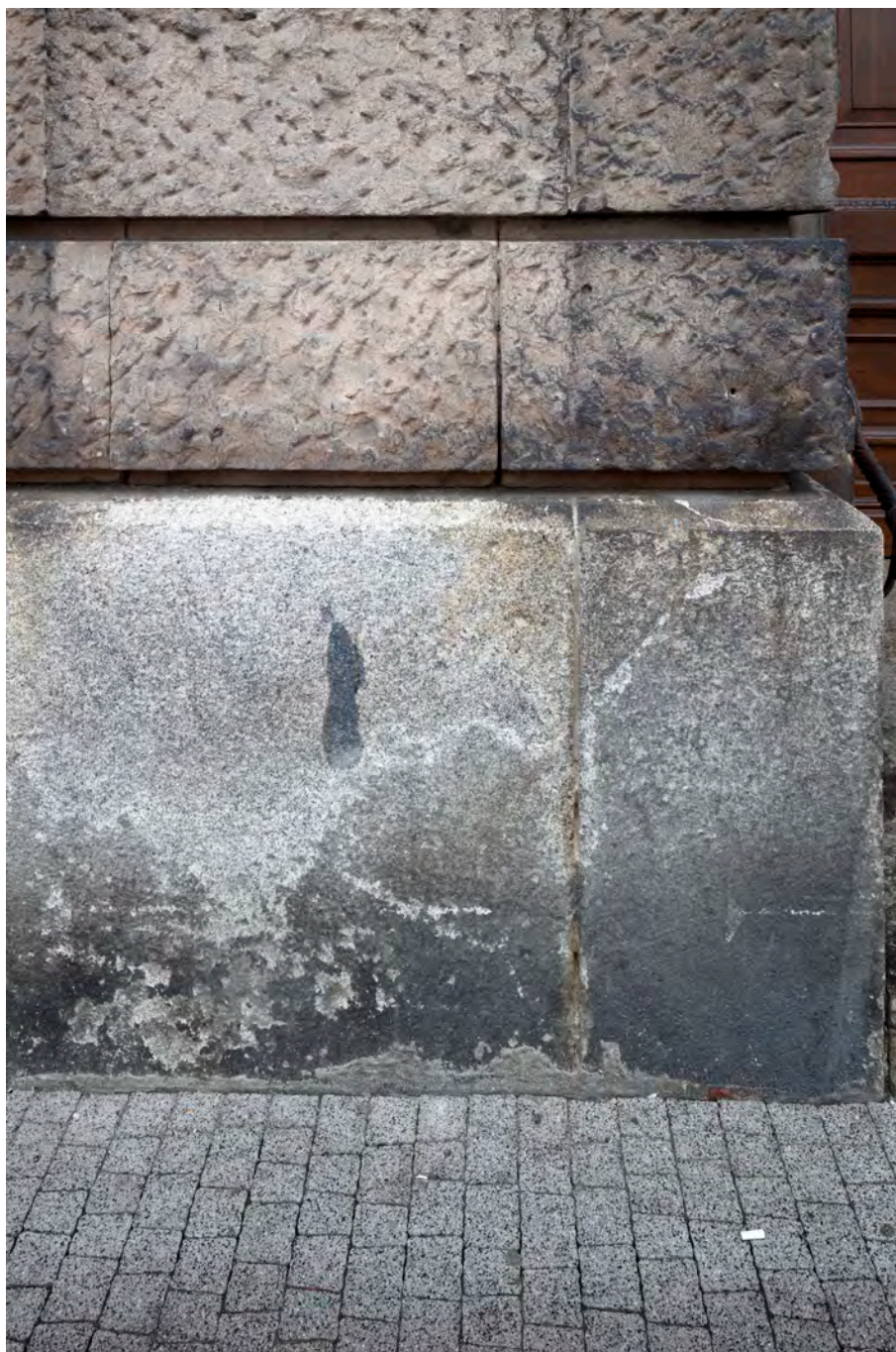
Ilu. 33. Muzeum Narodowe w Poznaniu, fasada, fragment cokołu. Stan zachowania cokołu granitowego – widoczna dezintegracja granitu, pęknięcia i złuszczenia.
