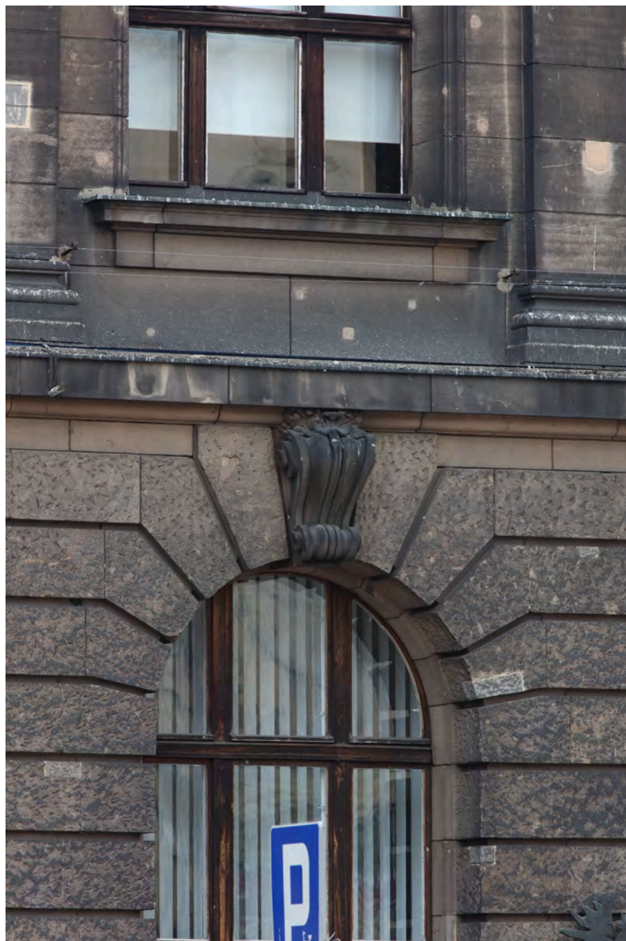
Ilu. 15. Muzeum Narodowe w Poznaniu, fasada. Powierzchnia pokryta szaroczarnymi nawarstwieniami, szczególnie intensywnie w miejscach występujących przed lico – np. zupełnie czarny jest klucz obramienia okiennego czy bazy pilastrów.
