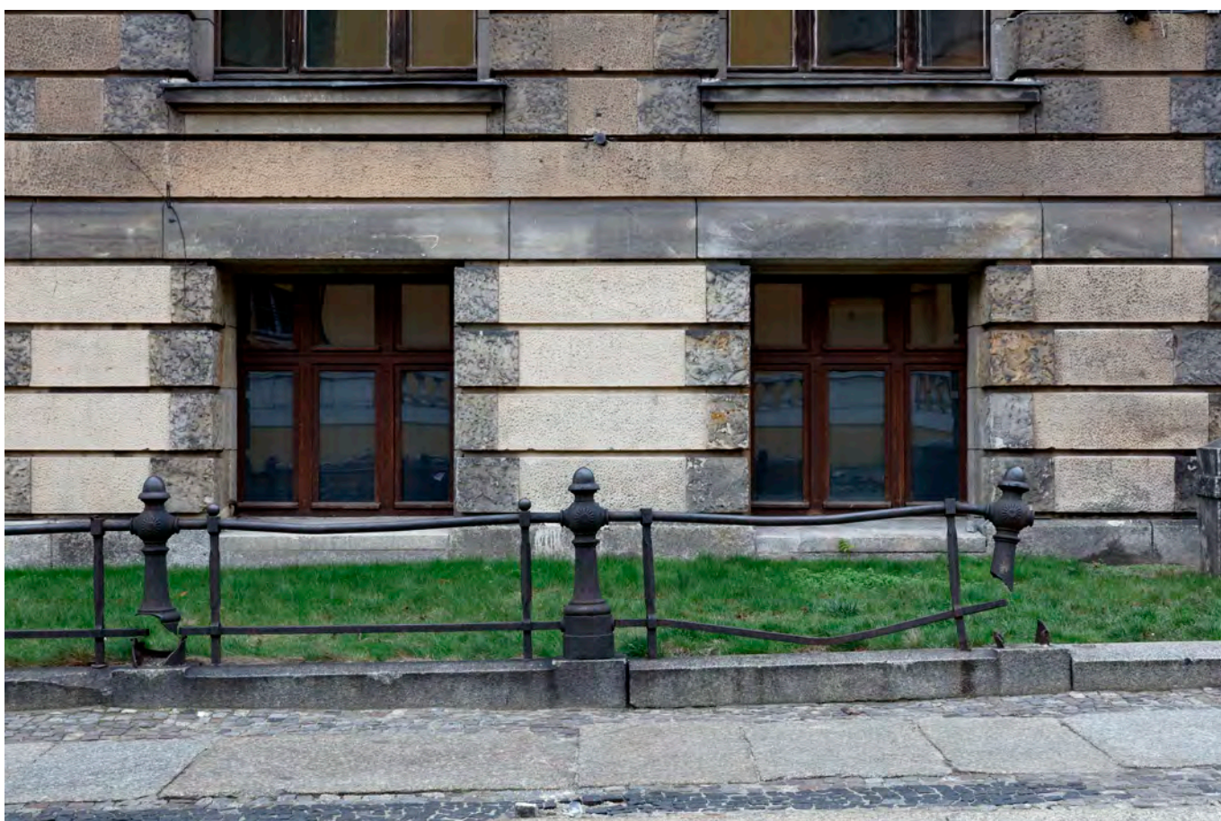
Ilu. 50. i 51. Muzeum Narodowe w Poznaniu, elewacja wschodnia, fragment ogrodzenia. Zarówno elementy kamienne jak i część metalowa są bardzo zniszczone. Żeliwne przęsła są uszkodzone mechanicznie, skorodowane i popękane. Tralki w stanie szczątkowym.
