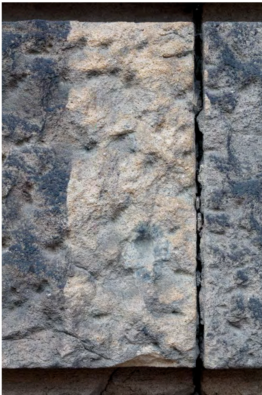
Ilu. 35. Muzeum Narodowe w Poznaniu, fasada, detal rustyki. Próba oczyszczania metodą ścierno-strumieniową lica kamiennej rustyki - szczyty są przeczyszczone, zagłębienia niedoczyszczone.
