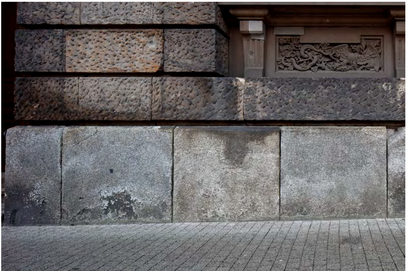
Il. 31. i 32. Muzeum Narodowe w Poznaniu, fasada, fragment cokołu. Stan zachowania cokołu granitowego – powierzchnia wyplamiona, złuszczone, z wżerami i dużymi ubytkami.
