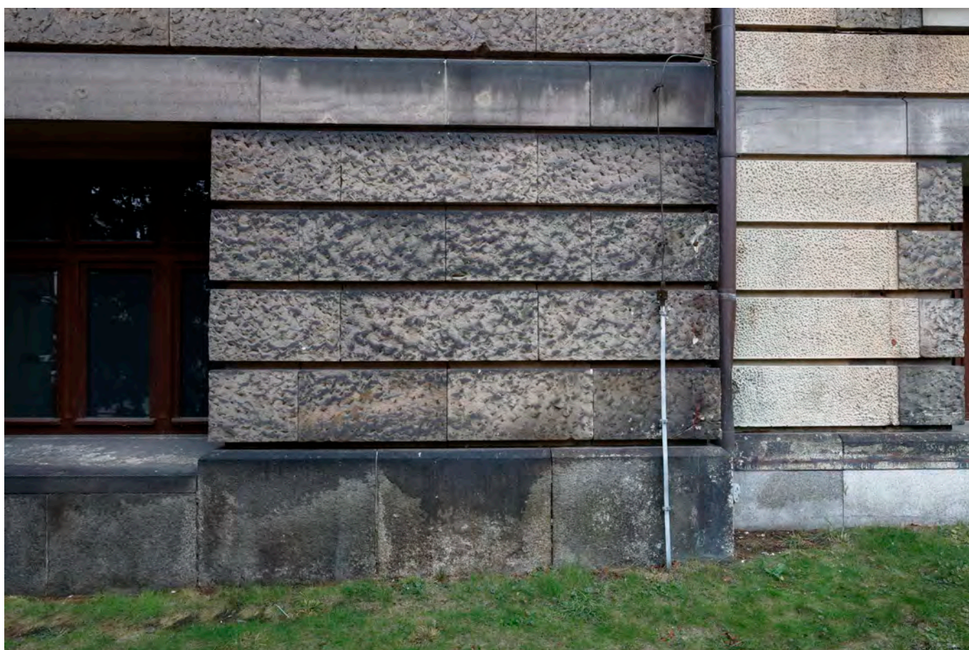
Ilu. 29. i 30. Muzeum Narodowe w Poznaniu, elewacja wschodnia. Stan granitowego cokołu. Na zdjęciu u góry dolne płyciny oczyszczono (zeszlifowano?) pozostawiając gzyms pokryty czarną powłoką (bitumiczną?). Na zdjęciu u dołu widać czarne, nierównomiernie rozkładające się na powierzchni zacieki (?), pod nimi złuszczone, z licznymi wżerami granit.
