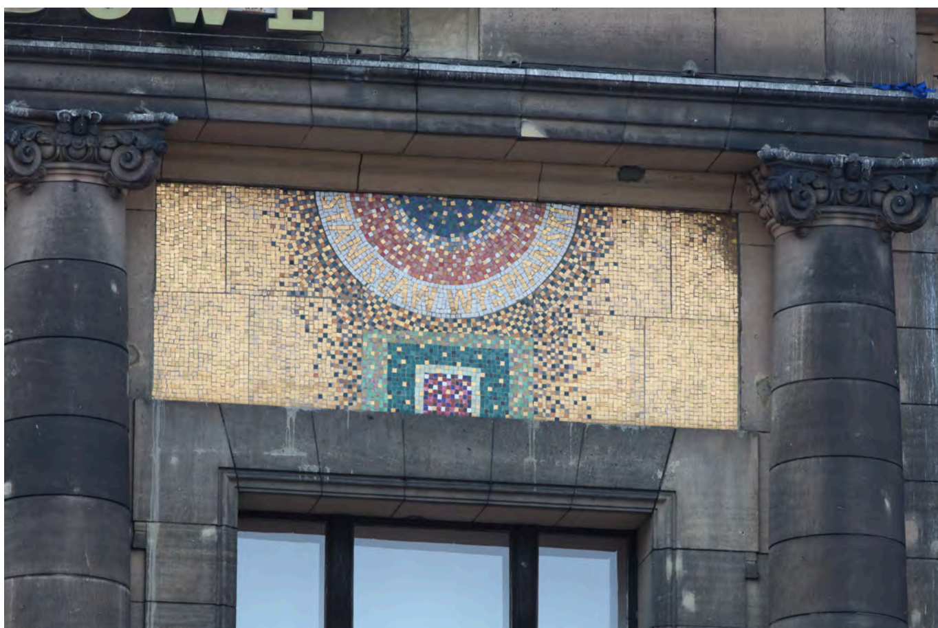
Ilu. 42. i 43. Muzeum Narodowe w Poznaniu, fasada, mozaiki. Widoczna technika wykonania oraz stan zachowania powojennych mozaik, które zastąpiły oryginalne portrety artystów niemieckich.
