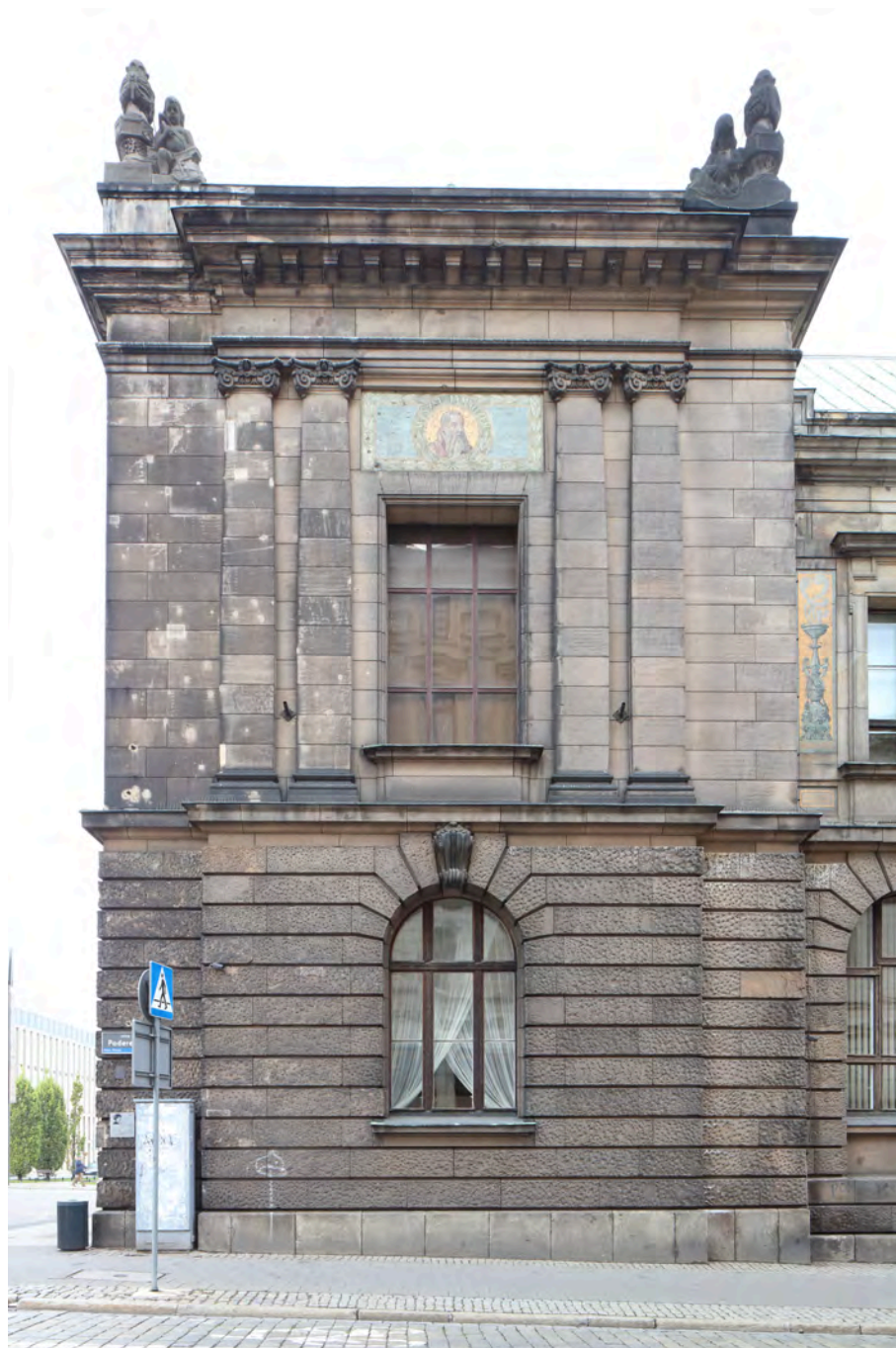
Ilu. 2. Muzeum Narodowe w Poznaniu, elewacja południowa, ryzalit pd.- zach. Równomiernie pokrytą nawarstwieniami atmosferycznymi powierzchnię rozbijają jaśniejsze plamy uzupełnień.
