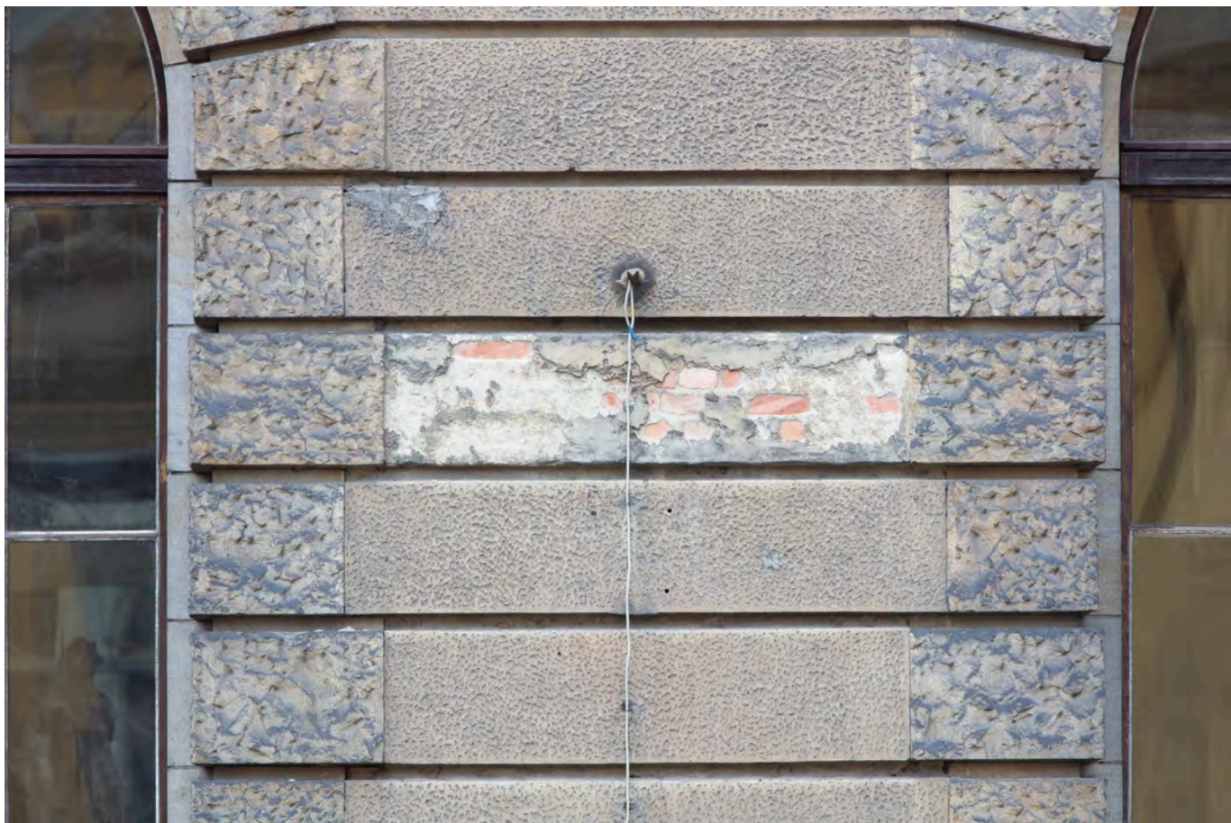
Ilu. 40. Muzeum Narodowe w Poznaniu, elewacja wschodnia, fragment. Widoczny skuty fragment tynku – wynik doraźnych działań budowlanych.
