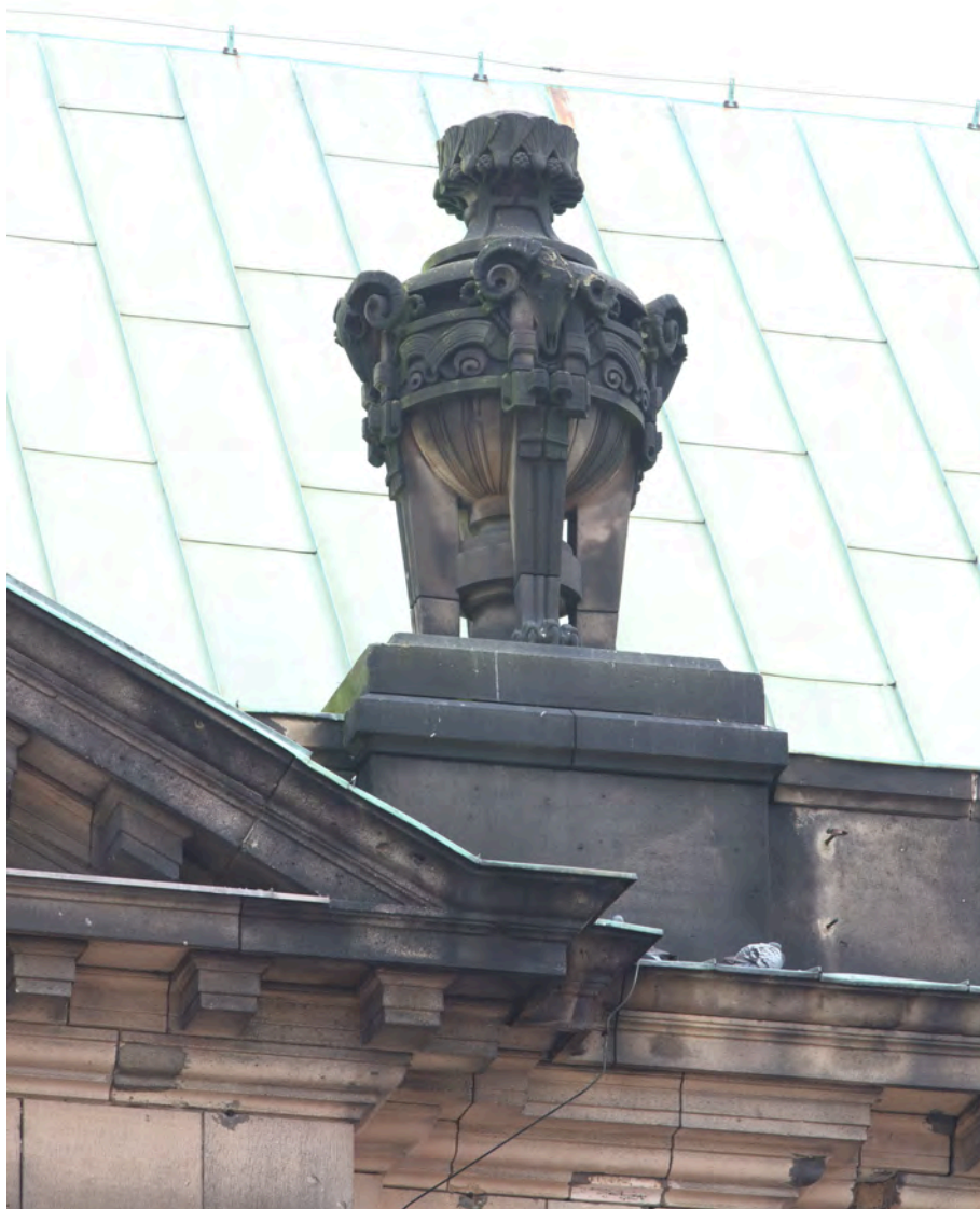
Il. 14. Muzeum Narodowe w Poznaniu, fasada, partia gzymsu. Dekoracje rzeźbiarskie oraz detale kamienne ponad gzymsem wieńczącym są szczególnie narażone na negatywne oddziaływanie czynników destrukcyjnych. Pokryte są czarnymi nawarstwieniami atmosferycznymi oraz koloniami mikroorganizmów.
