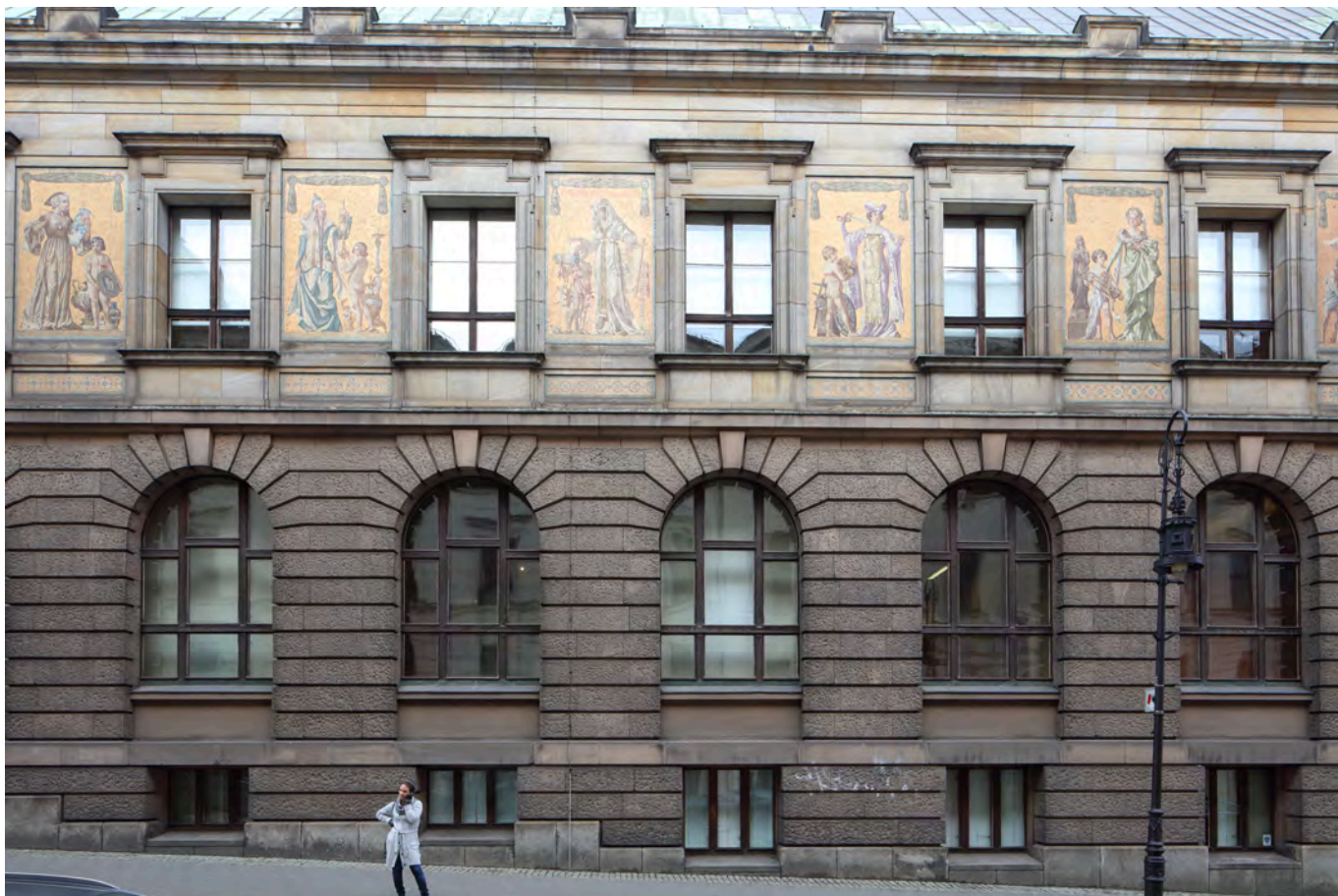
Ilu. 3. Muzeum Narodowe w Poznaniu, elewacja południowa, część środkowa. Powierzchnia elementów kamiennych oraz dekoracji mozaikowych pokryta ciemnymi nawarstwieniami oraz zabrudzeniami.
