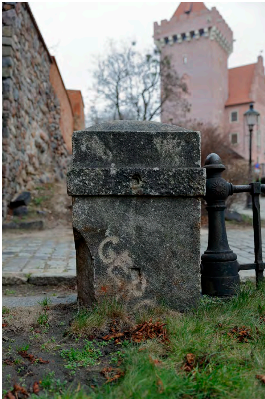
Ilu. 53. Muzeum Narodowe w Poznaniu, ogrodzenie od strony wschodniej, fragment. Granitowy słupek ze znacznym ubytkiem, brudny, porośnięty koloniami mikroorganizmów.
