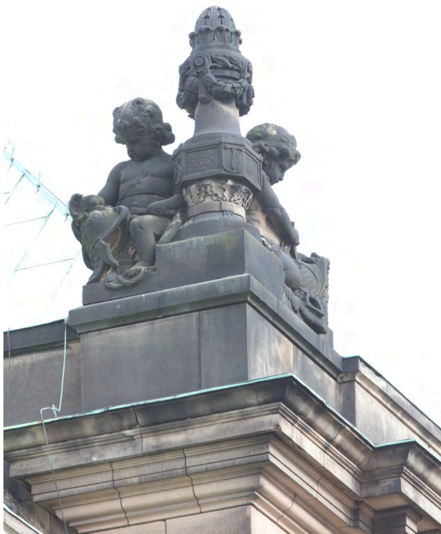
Ilu. 12. Muzeum Narodowe w Poznaniu, partia gzymsu. Dekoracje rzeźbiarskie oraz detale kamienne ponad gzymsem wieńczącym są szczególnie narażone na negatywne oddziaływanie czynników destrukcyjnych. Pokryte są czarnymi nawarstwieniami atmosferycznymi oraz koloniami mikroorganizmów.
