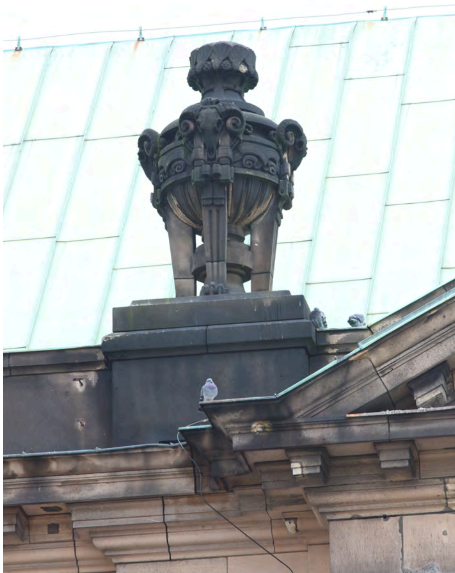
Ilu. 13. Muzeum Narodowe w Poznaniu, fasada, partia gzymsu. Dekoracje rzeźbiarskie oraz detale kamienne ponad gzymsem wieńczącym są szczególnie narażone na negatywne oddziaływanie czynników destrukcyjnych. Pokryte są czarnymi nawarstwieniami atmosferycznymi oraz koloniami mikroorganizmów.
